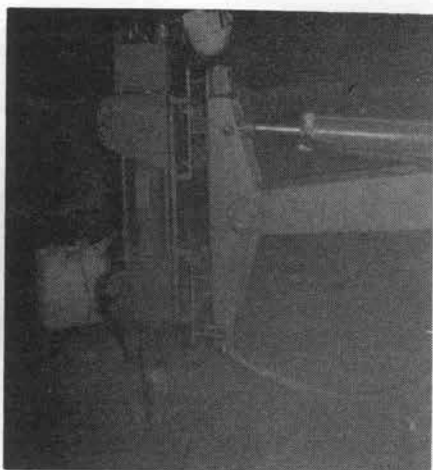
写真-6 ブレーカアタッチメント（浜岡原子力工事）
