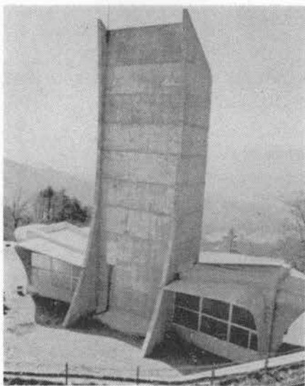
写真-1 立坑送排気口
