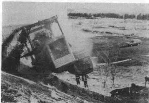
写真-7 ブルドーザの転落状況 (回転角 340°)
