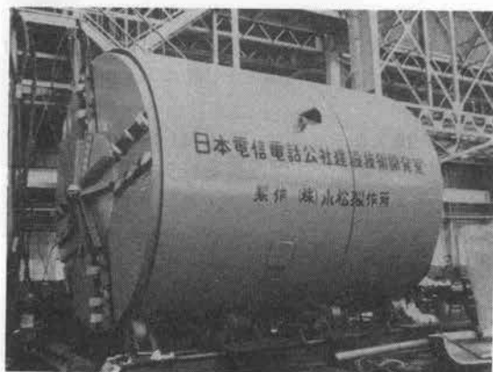
写真-10 3,676 mmφ 限定圧気式シールド (小松製作)
