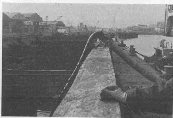
揚泥(含泥率93.5%)状況
