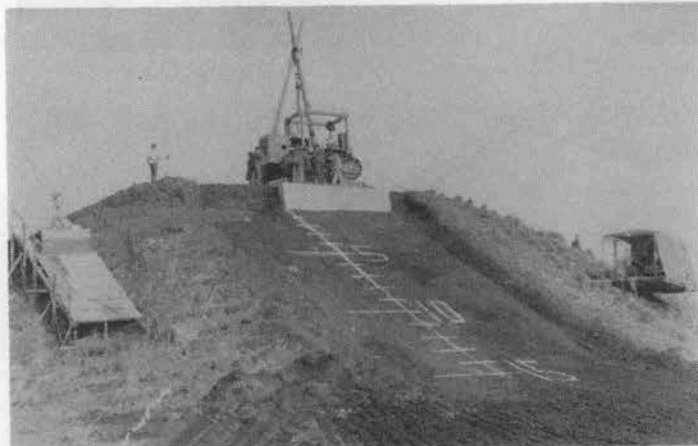
写真—1 ブルドーザの転落実験場
