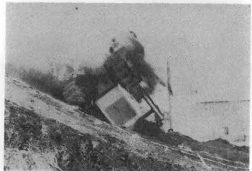
写真-8 ブルドーザの転落状況 (回転角 450°)
