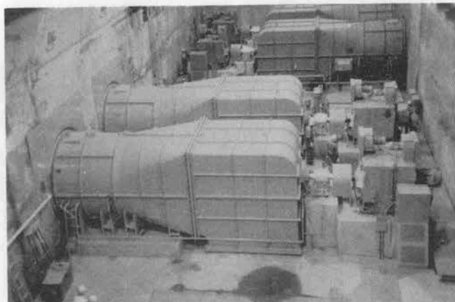
写真-4 地下換気所
