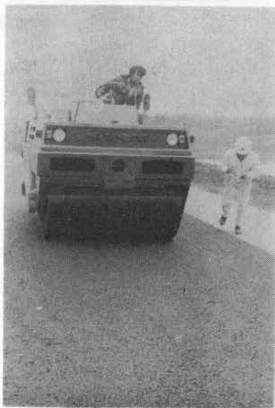
写真-324.1 試験時の作業状況
