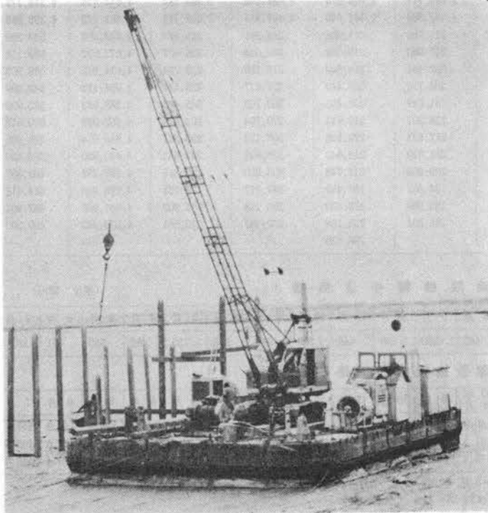
← テムズ河口のヘドロ上で、クレーンを搭載してくい打ち作業を行なっているホバークラフト式作業足場
