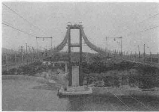
写真-2 完成したキャットウォーク
