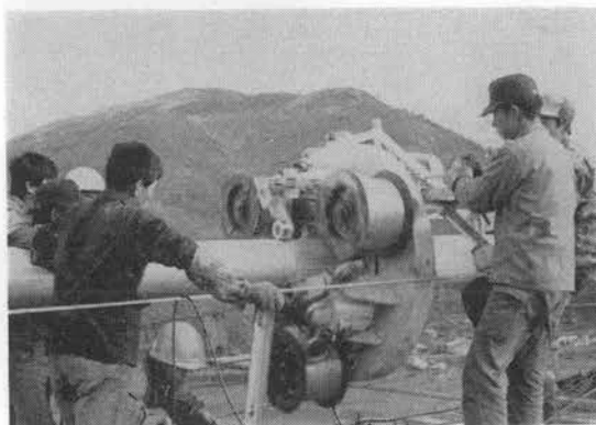
写真-8 中央スパンにおけるワイヤラッピング作業
