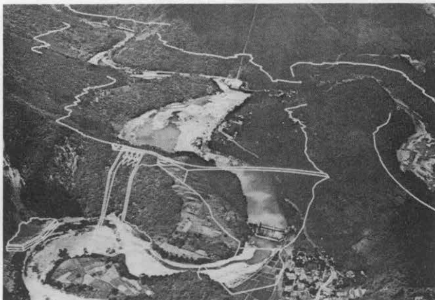
写真-2 ダムサイト遠景および完成予想形状線
