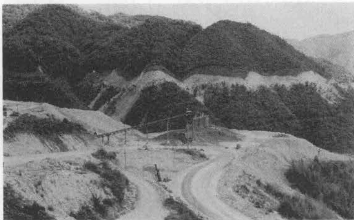
写真-2 コアプラント
