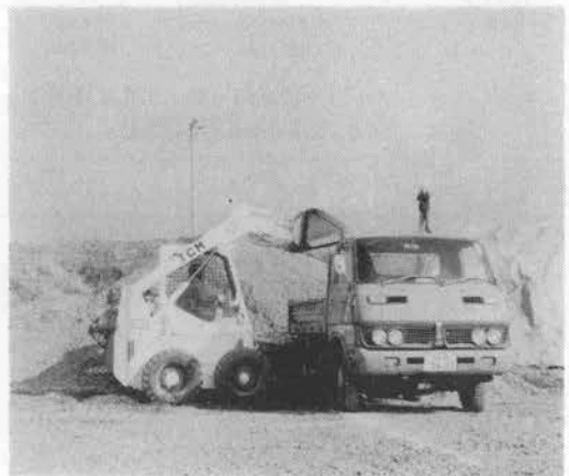
写真—328.2 積込作業試験
