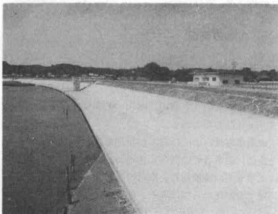
写真-2 新設の湖岸堤（前方は農業用揚排水機場とその樋門）
