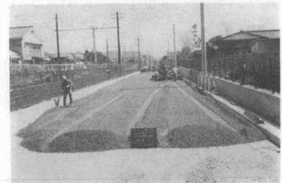
写真-3 粒調鉍滓の敷きならし作業
