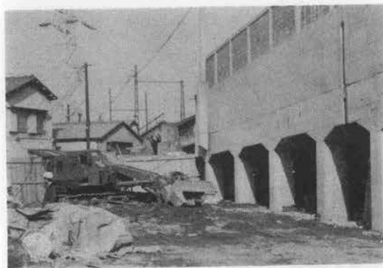
写真-1 コンクリート無騒音破壊機
