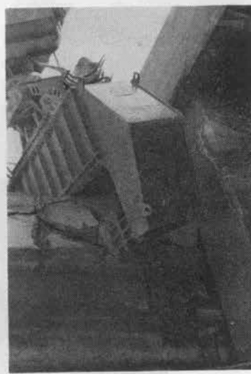
写真-5 外に引出して破壊する壁状橋脚
