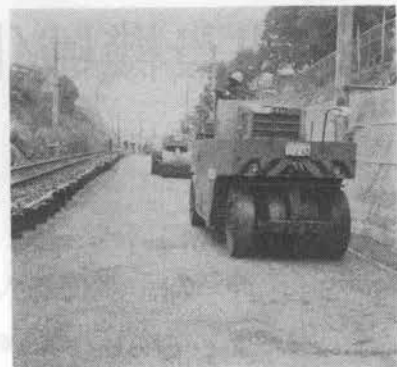
写真-4 タイヤローラによる締固め作業
