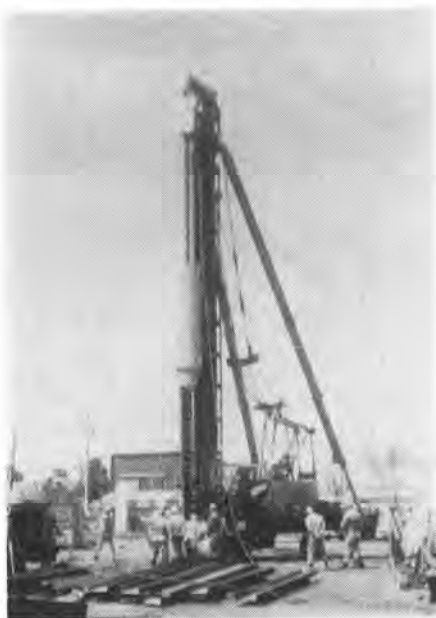
写真-4 無振動無騒音鋼矢板圧入機
