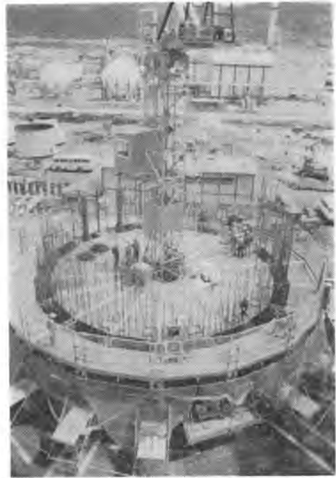
写真-7 装置組立終了(約3 m 上昇するとクレーンも一緒につり上げられる。マストに設置してあるのは司令室)
