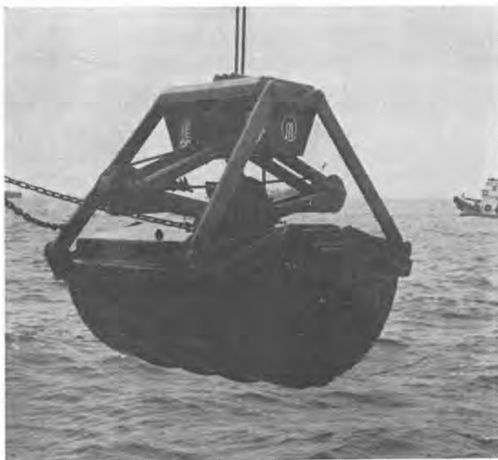
作業中のヘドロ用MNPバケット
