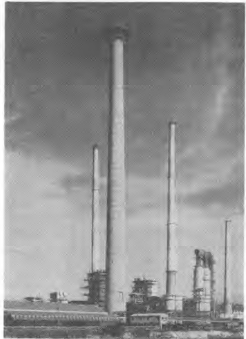
写真-1 スライド終了した 200 m 超高煙突(山口県徳山市)
