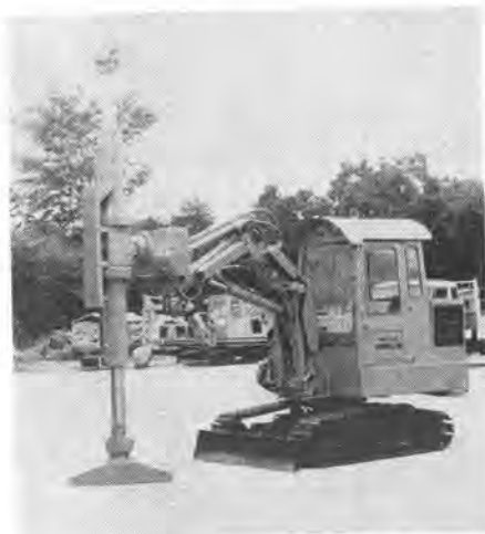
写真-1 低公害ビル解体機“アサヒジャッカ 160”
