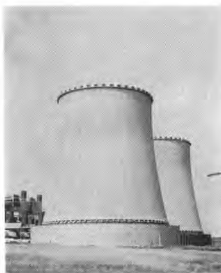
写真-1 スウェーター工法で施工したクーリングタワー
