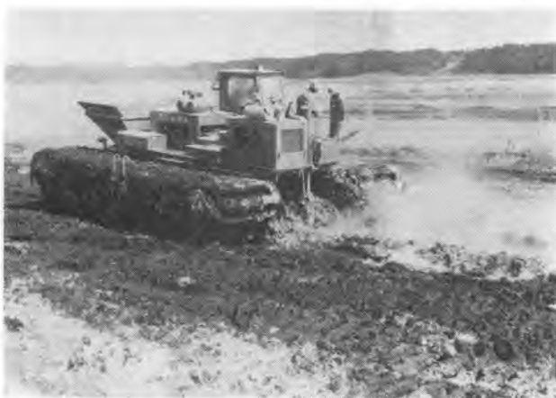
写真-4 マッドスタビライザによるヘドロの安定処理 (処理厚 1\text{ m} , ヘドロの含水比 280~300%)
