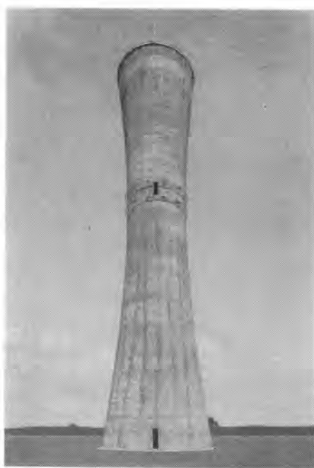
写真-3 スウェー工法で施工した高架水槽
