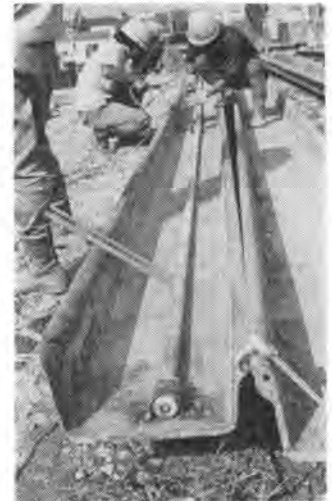
写真-3 ジェットパイプの取付
