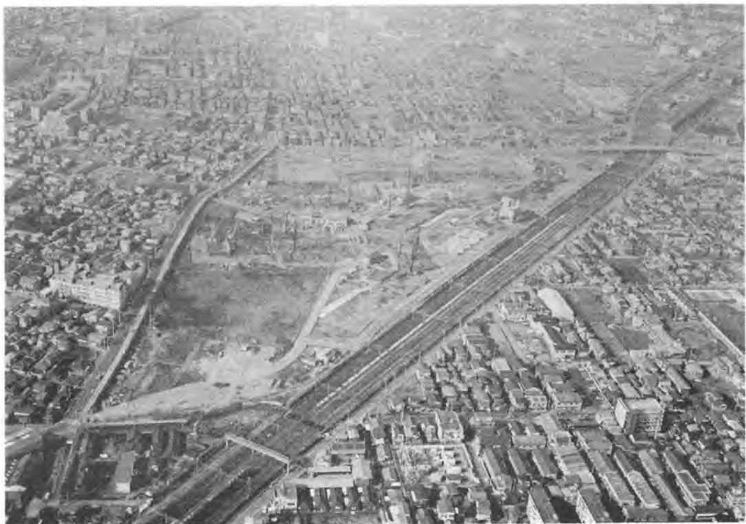
写真-5 川口芝園地 J.J パイル工事現場
