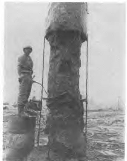
写真-2 混合処理パイル
