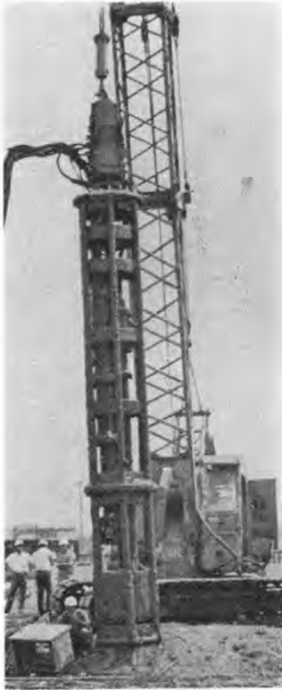
写真-1 深層処理タイプ施工機
