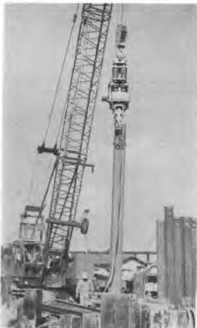
写真-4 シートパイルの打込み
