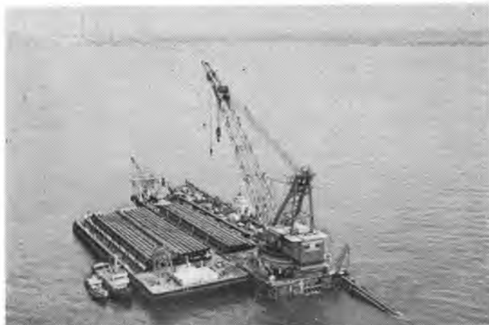
写真—1 敷設船による敷設状況
