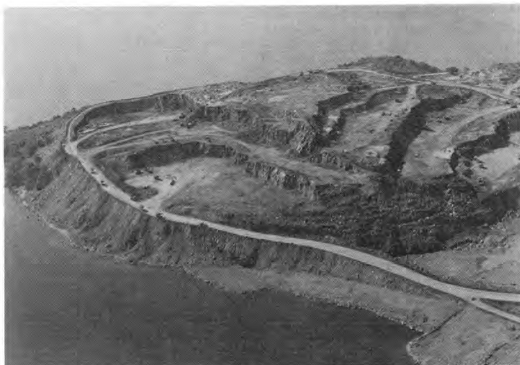
写真—1 ベンチカット作業状況
