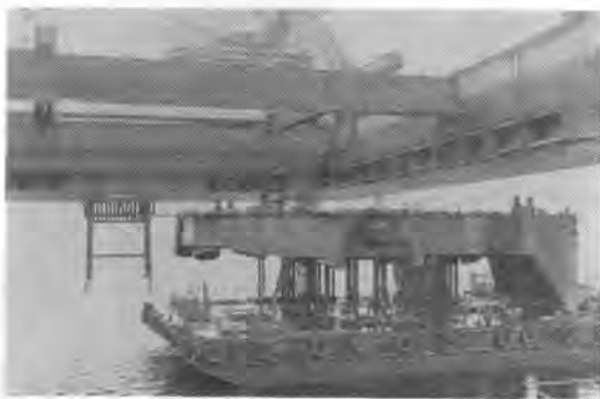
写真-4 SEP 開口部へのテンプレート引込据付作業
