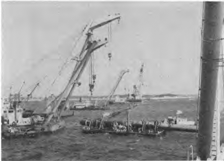
写真-3 水平ベンド部の敷設状況(浮遊えい航法)
