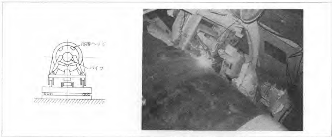
写真-2 自動溶接状況(下進法)
