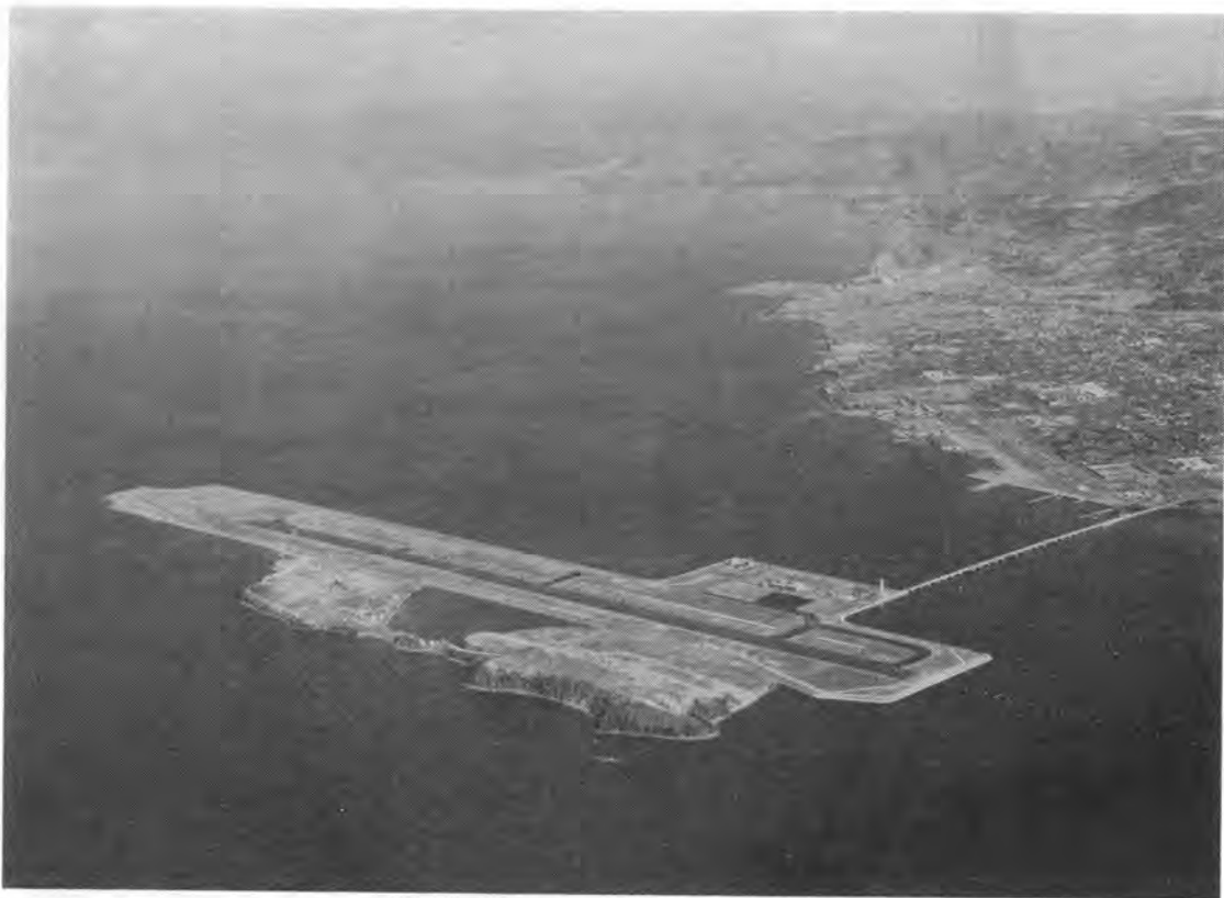
写真-2 上空より見た長崎空港
