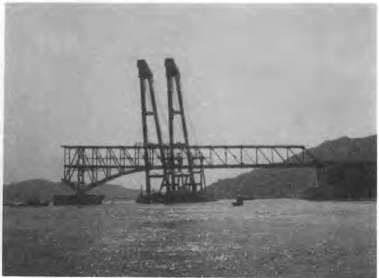
写真-3 大島大橋大島側側径間架設
