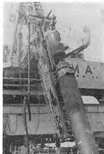
写真-5 SEP "KAJIMA" による くい打ち作業
