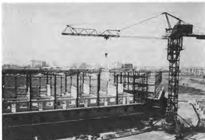
写真-1 建設中の千葉ガーデンタウン
