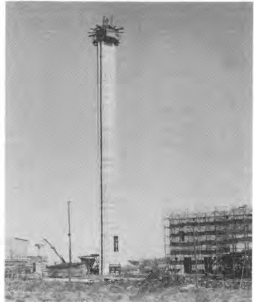
写真-3 H煙突の施工状況
