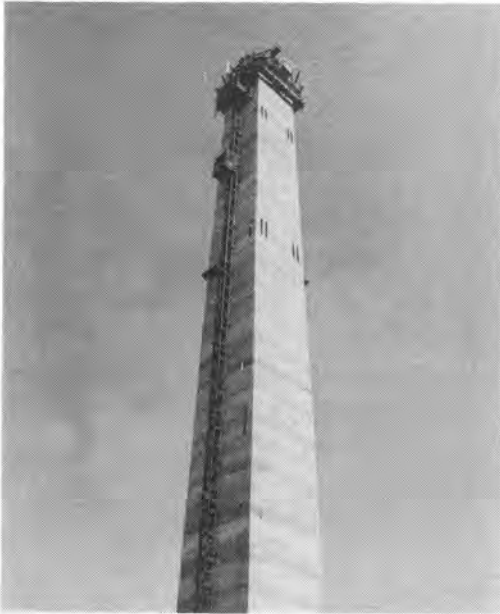
写真-2 F煙突の施工状況
