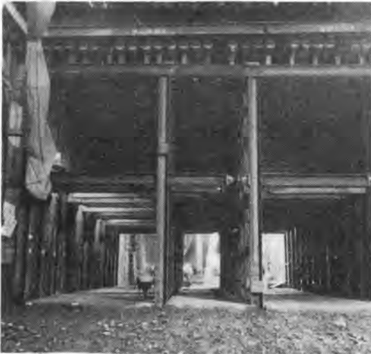
写真-3 掘削を完了した横断面
