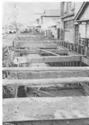
写真-3 在来のオープン工法だと沿道住民の交通、第三者障害の危険がある
