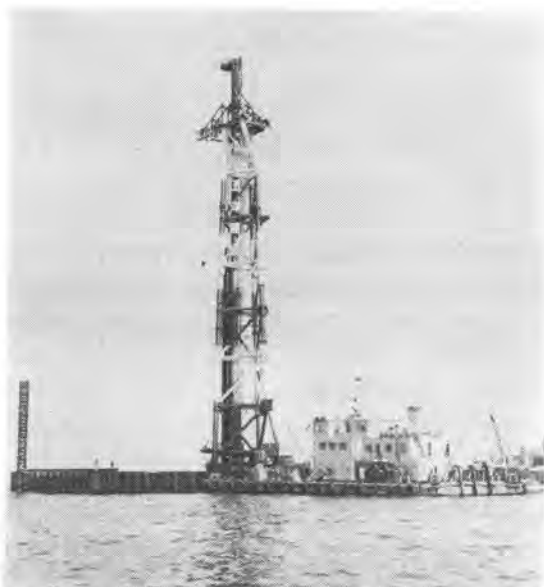
写真一 大型斜ぐい打ち船“CP-2001”
