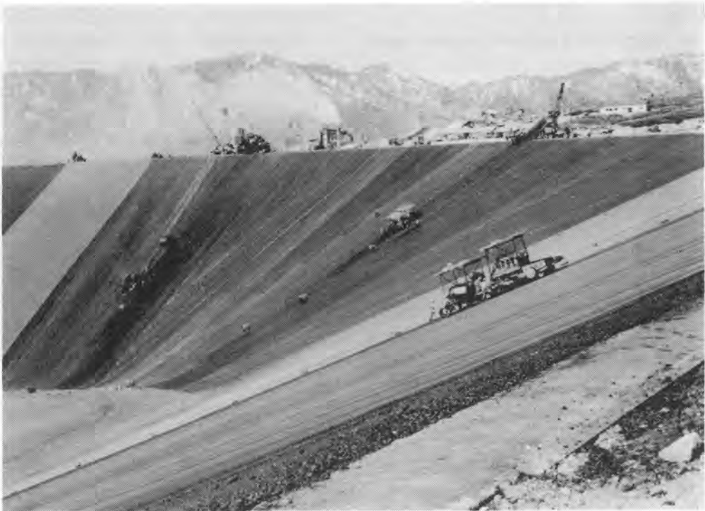
写真-1 アスファルト斜面舗装（沼原ダム，昭和47年完成）
