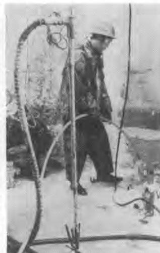
写真-2 注入作業
