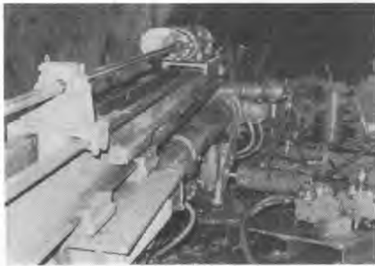
写真-1 栃洞鉱でのテスト状況
