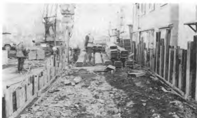
写真-2 振動、騒音に悩まされる在来工法
