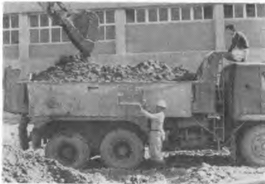
写真-5 排土の搬出状況
