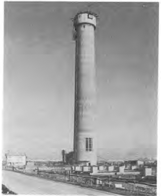
写真-1 N煙突の施工状況
