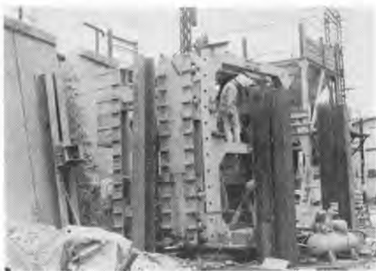
写真-1 横坑用 OSA 掘削機の組立
