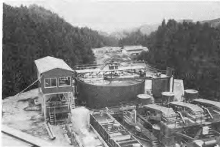
写真-1 300 m 3 /hr シックナと 300 m 3 /hr バケットかき上げ型の併用
