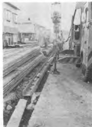
写真-4 在来のオープン工法だと資材の置場にも沿道住民の迷惑になる
