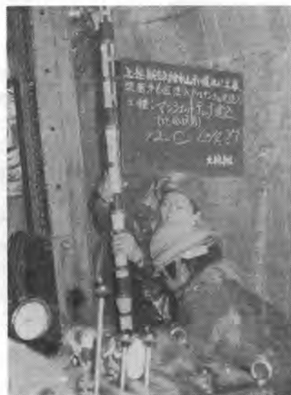
写真-4 注入測定管建込中
