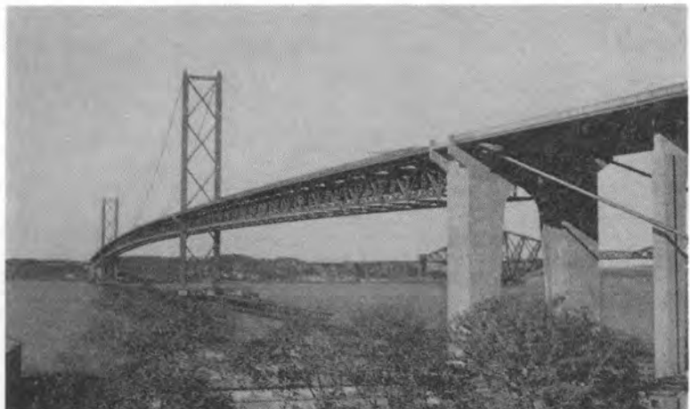
写真-2 フォース道路橋
