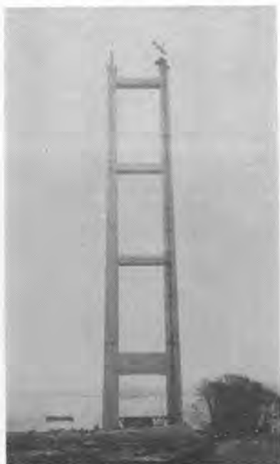
写真一七 ハンパー橋のコンクリートタワー
