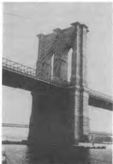
写真-4 石造りのブルックリン橋のタワーピヤ
