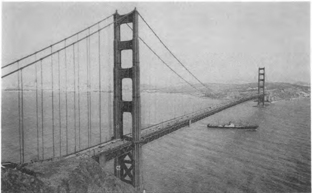
写真-1 ゴールデン・ゲート橋
