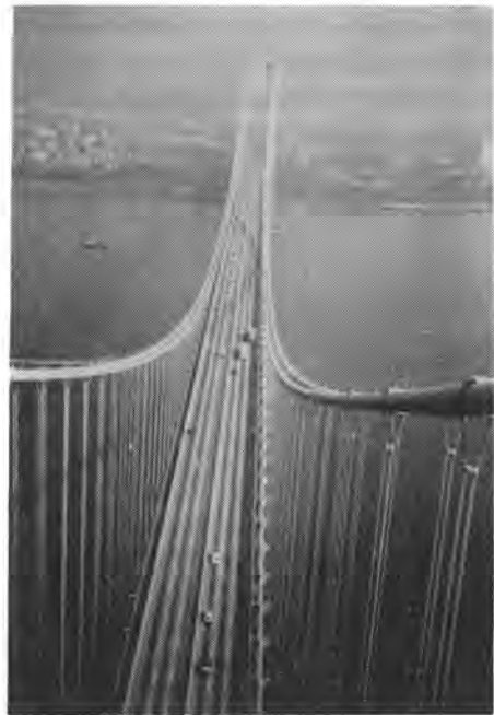
写真-3 高さ 192 m の塔頂から見たベラザノ・ナロウズ橋
