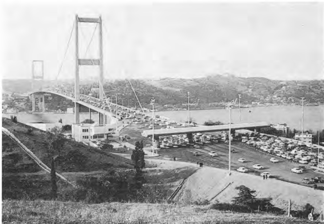
写真-6 トルコ・イスタンブールのボスボラス橋
