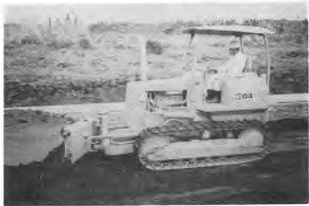
写真 1.1-2 CAT D3 ブルドーザ (パワーアングルチルト)
