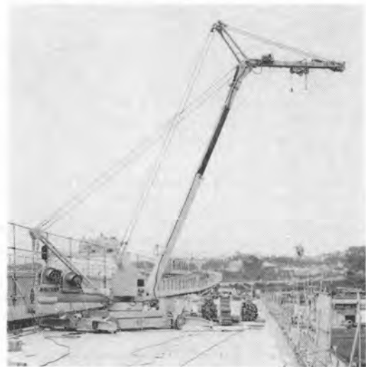
写真 2.4-3 越原 U-16 ユニバーサルクレーン
