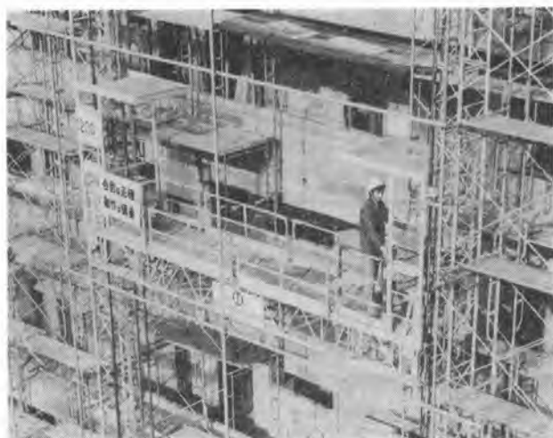
写真 2.3-2 ロングスパン工事用エレベータ
