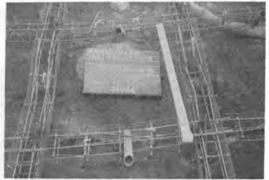
写真-3 配筋・型わくの状況（フリーフレーム工法）
