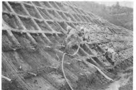
写真-4 配筋・型わく設置の状況
