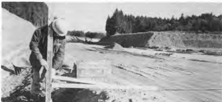
写真-2 写真-1 ののり面工施工後の状態(ネット+たね吹付工)
