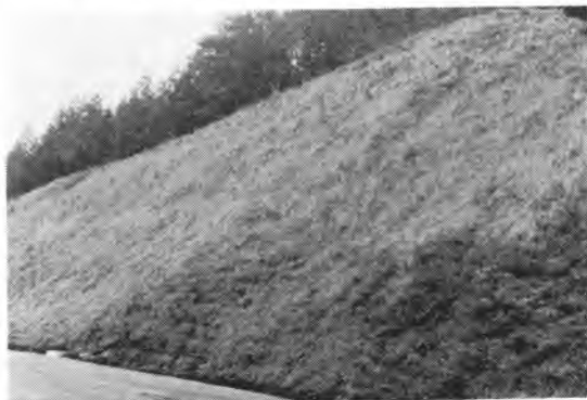
写真-9 写真-8 ののり面工施工後の状態(つぼ掘り工)
