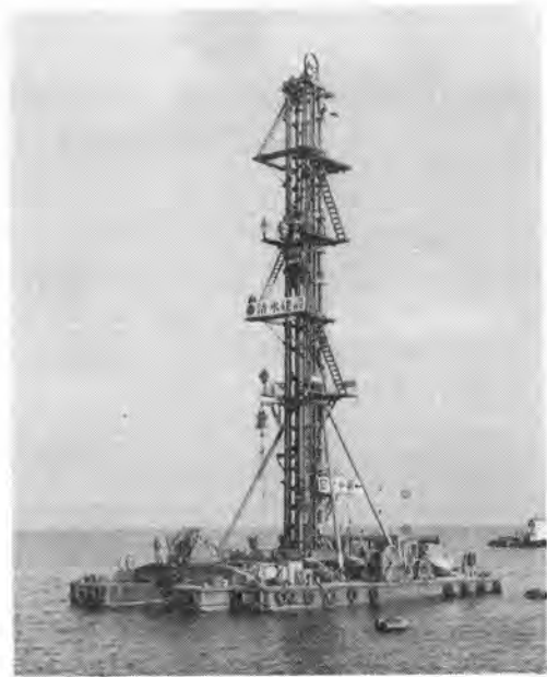
写真 3.3-3 DCM 工法用地盤改良船
