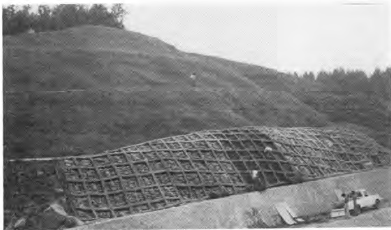
← 写真-7 写真-6 ののり面工 施工後の状態
