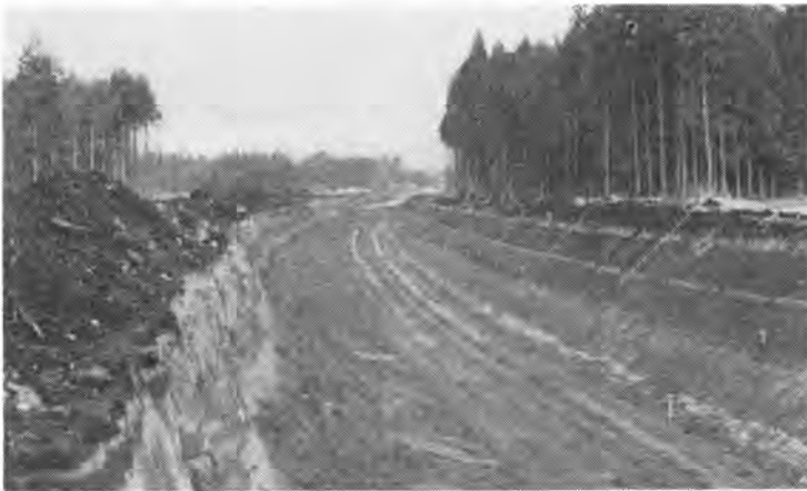
写真-1 Sta. No. 145 付近の掘削当時の状態 【上層より表層ローム、七木桜軽石層、今市軽石層、ローム、鹿沼土(軽石層)】
