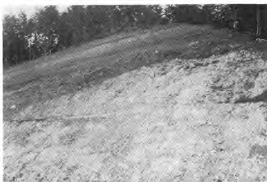
写真-8 今市 I.C. B, ランプ Sta. No. 1~3 付近の 掘削当時の状態
