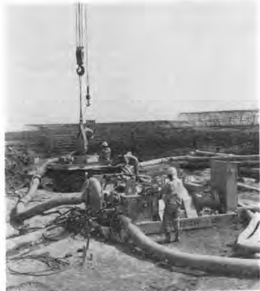
写真 3.2-5 日立建機 S320 リバースサーキュレーションドリルの稼働状況
