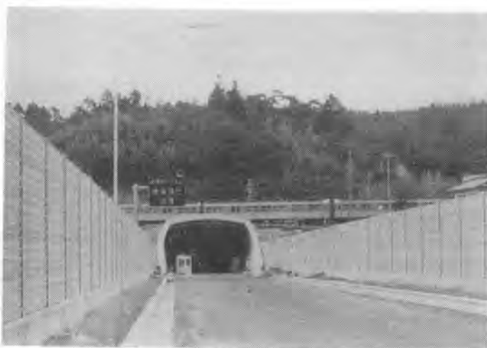
写真-1 北坑口付近
