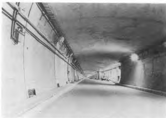
写真-2 完成したトンネル内部
