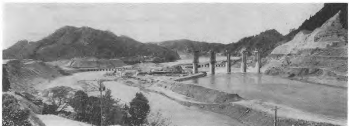
写真-2 上流より見た工事全景（昭和 49 年 3 月転流直後）
