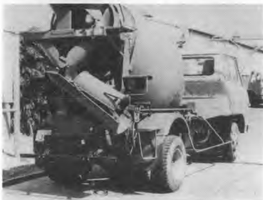
写真6.2-1 葦場工業製 1.6m 3 トラックミキサ車
