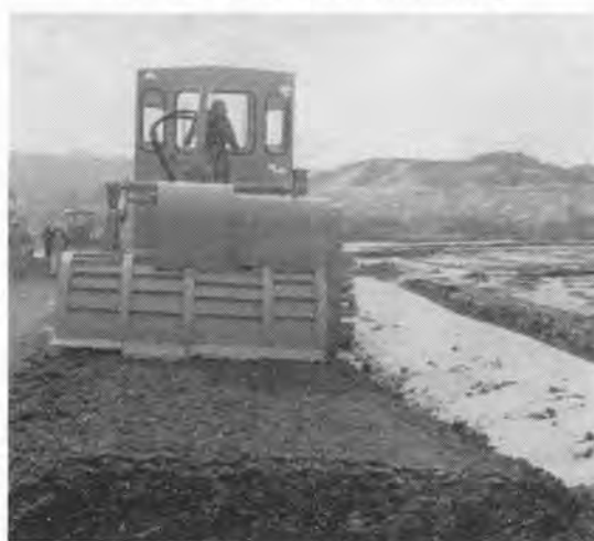
写真-5 ライムミキサによる混合攪拌状況
