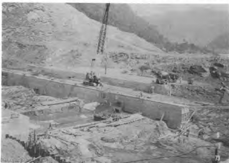
写真-7 ダムコンクリート打設状況
