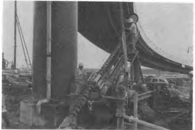
写真-5 橋脚防護アンカー工事
