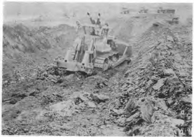
写真-3 アリスチャルマ HD 41 ブルドーザによるリップング状況
