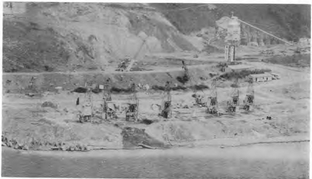
写真-4 イコス機による掘削状況
