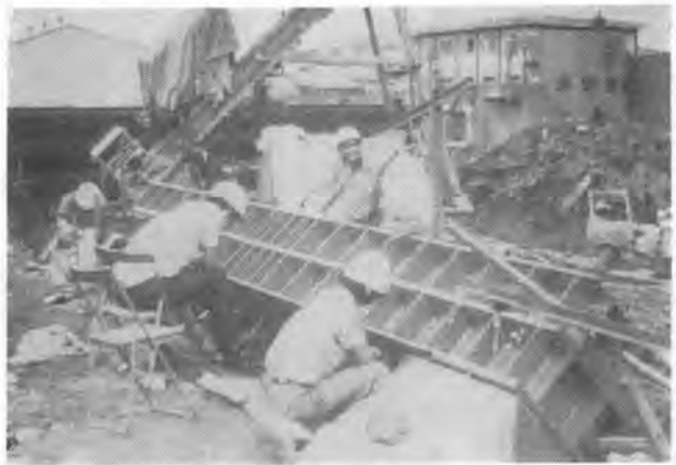
写真-3 引張試験の状況
