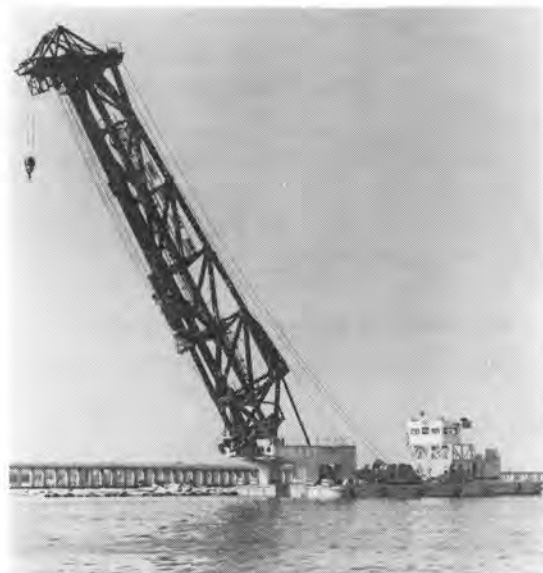
写真9-4 大型くい打ち船
