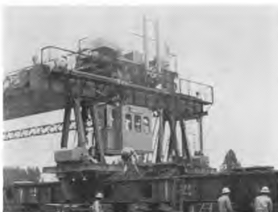
写真-1 天井式けた架設機(前方脚付近)
