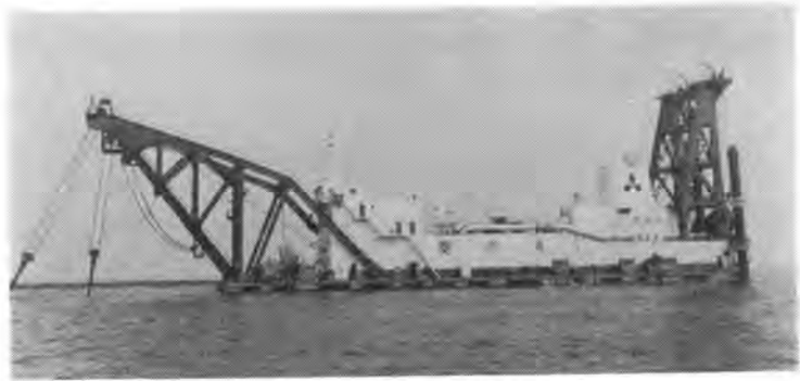
写真9-1 大型ポンプ浚渫船
