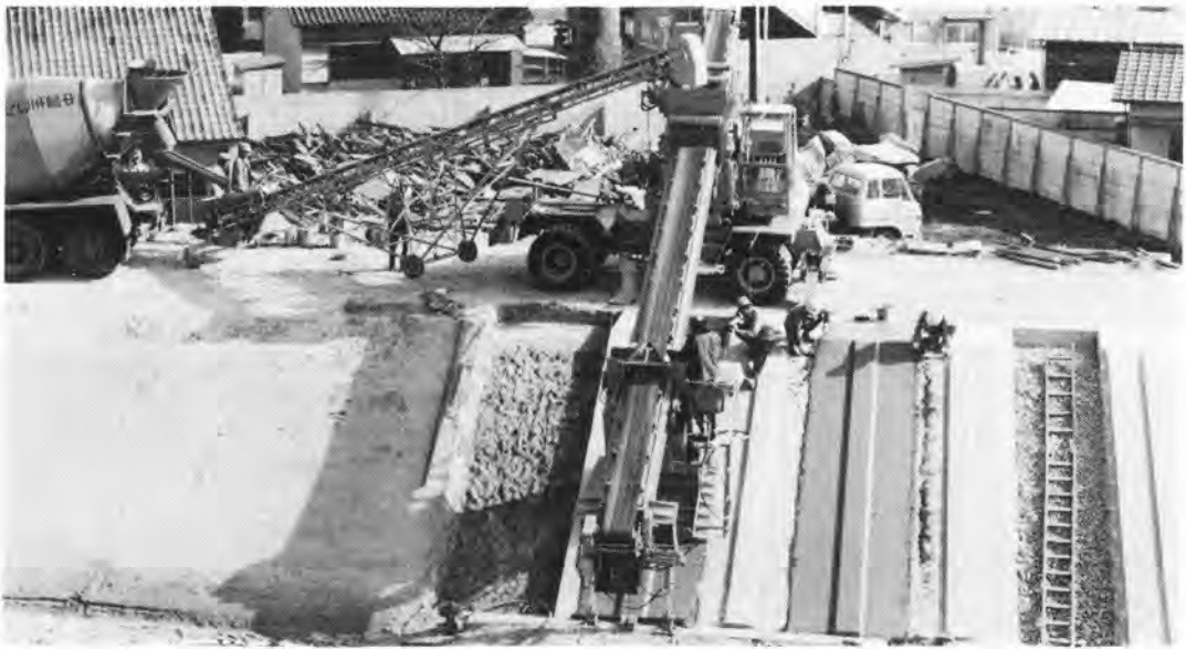
写真-1 のり面コンクリート打設機
