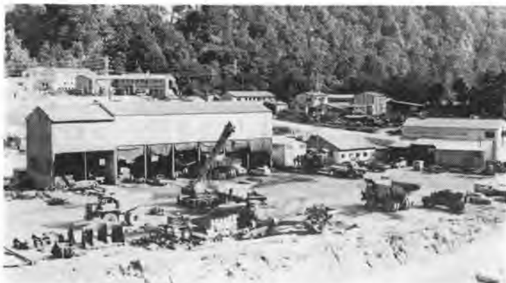
写真-5 モータプール
