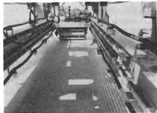
写真-2 横方向グレーピング施工の状況
