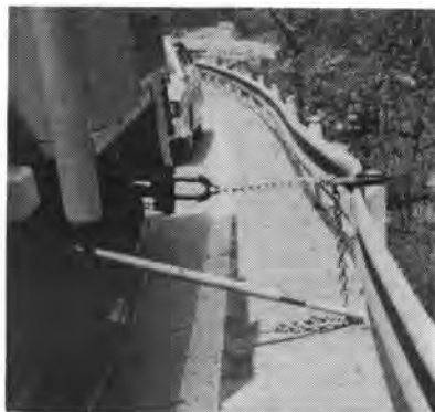
写真-5 ガードレール支柱修正
