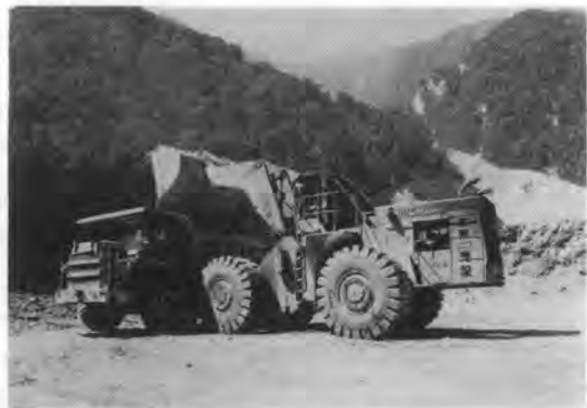
写真-4 積込状況
