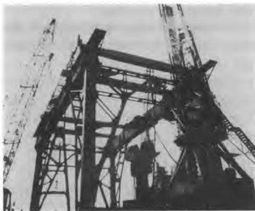
写真-14 油圧式門形くい打ちやぐら
