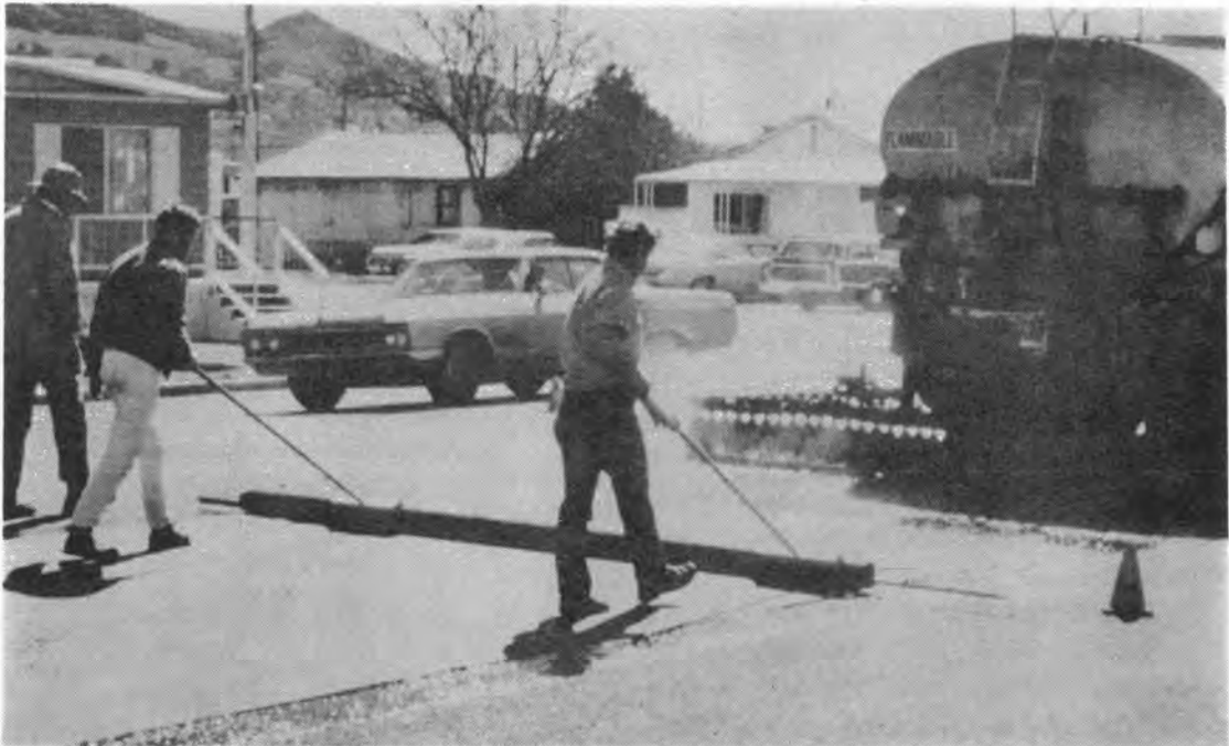
合成樹脂シートがシールコートされた古い舗装面に迅速に敷設される。2年間のテスト期間中レフレクションクラッキングはほとんど発生しなかった。
