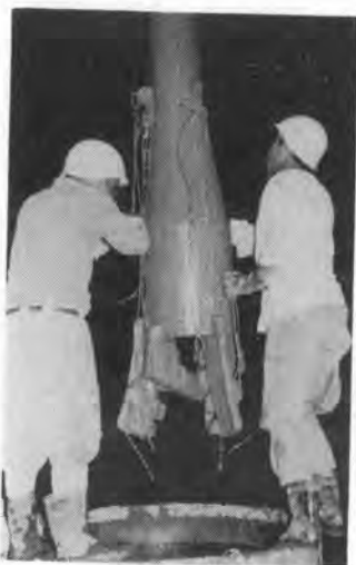
写真-18 ワイヤ式による掘削完了(スライム処理済み)
