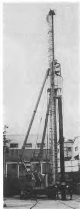
写真-8 電動式アースオーガマシンを搭載した全油圧電動式クローラクレーン KH 150 E →
