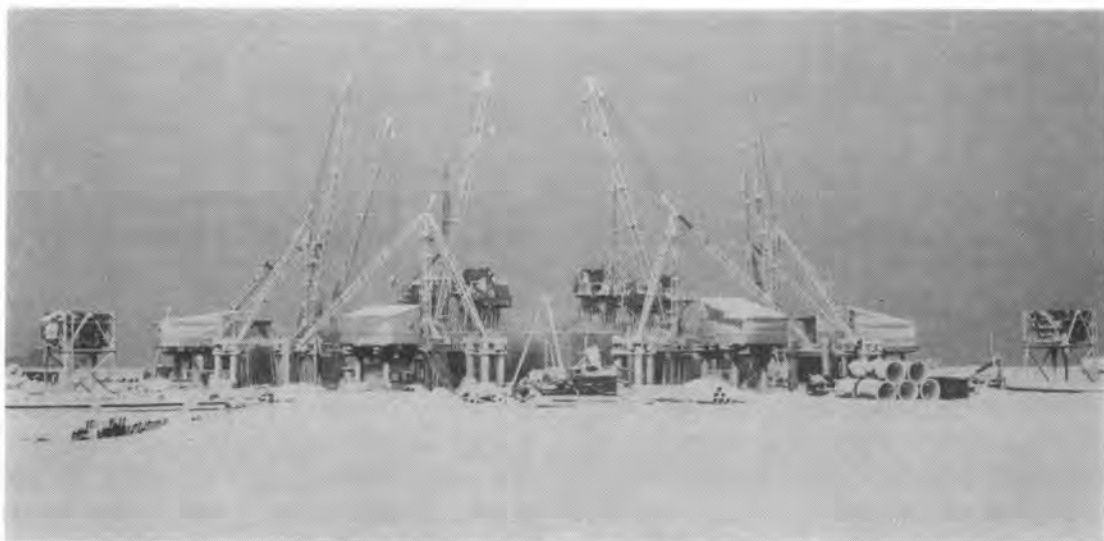
写真-2 大型ケーソン工事(高炉基礎)
