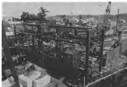
写真-5 コンテナ式土砂搬送装置
