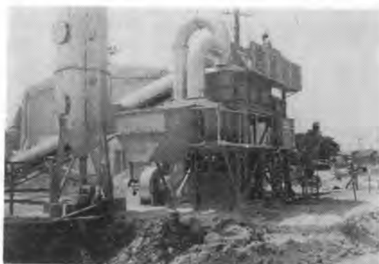
写真-27 セントラルミキシングプラント
