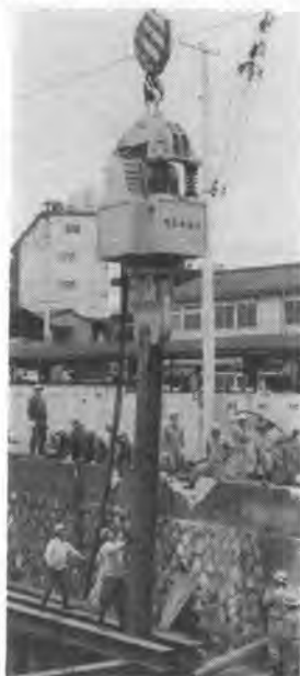
写真-11 低振動型バイブロハンマ LSV-120
