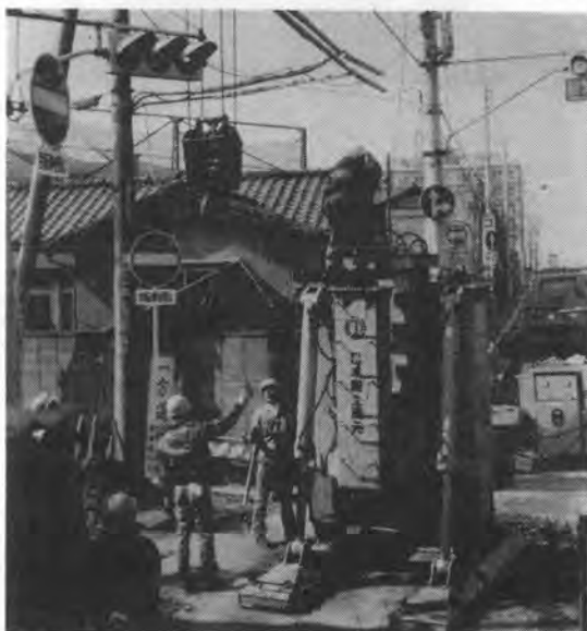
写真-19 コクド式油圧くい抜き機(混雑地点の作業状況)
