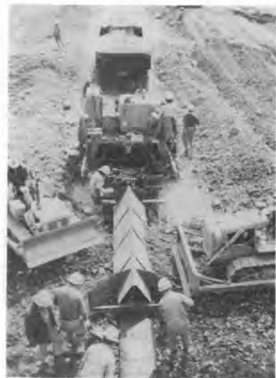
写真-50 アスファルトコア舗設機の施工状況
