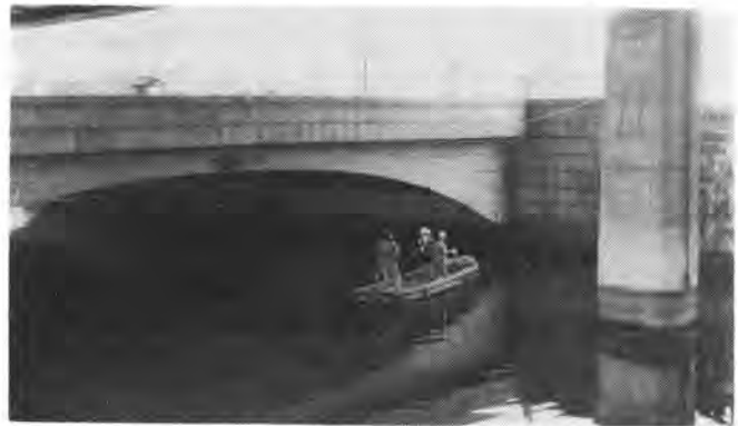
写真-2 組橋で、右側に見えるのは高速道路の橋脚、左上は高速道路の一部である。
