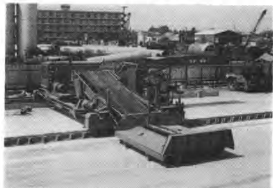
写真-43 コンクリートサイドローダ
