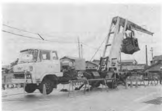
写真-7 グラブクレーン車
