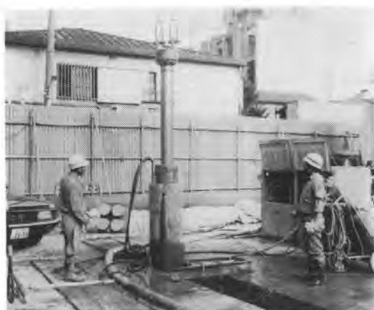
写真-21 ロッキングパイプ引抜機 (その2)
