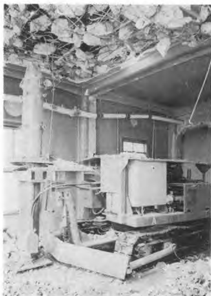
写真-4 油圧機械によるコンクリート構造物解体工法
