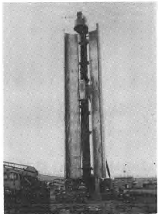
写真1 ディーゼルハンマの防音カバー（開いた状態）
