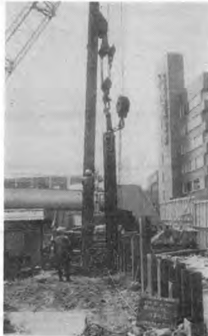
→ 写真-3 無騒音無振動鋼矢板引抜工法 (多滑車式)
