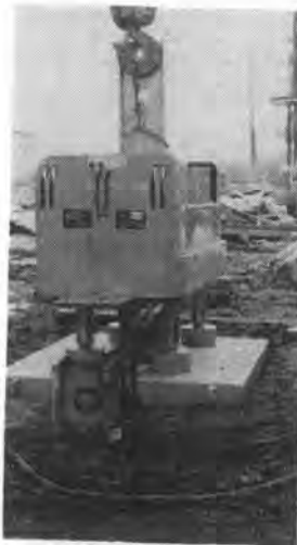
↑ 写真-2 無騒音無振動鋼矢板引抜工法 (油圧ジャッキ式)
