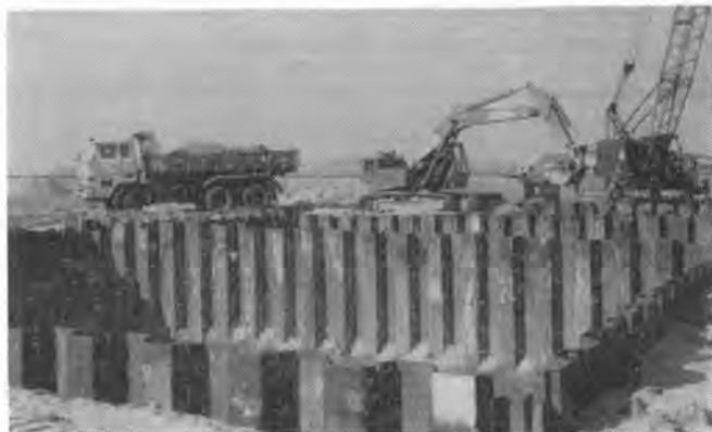
写真-1 沈殿池造成中
