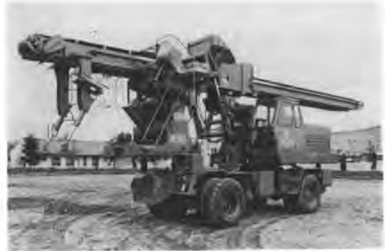
写真-1 のり面コンクリート打設機（走行姿勢）
