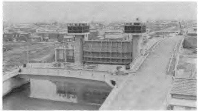
写真-4 大場川水門および伏越
