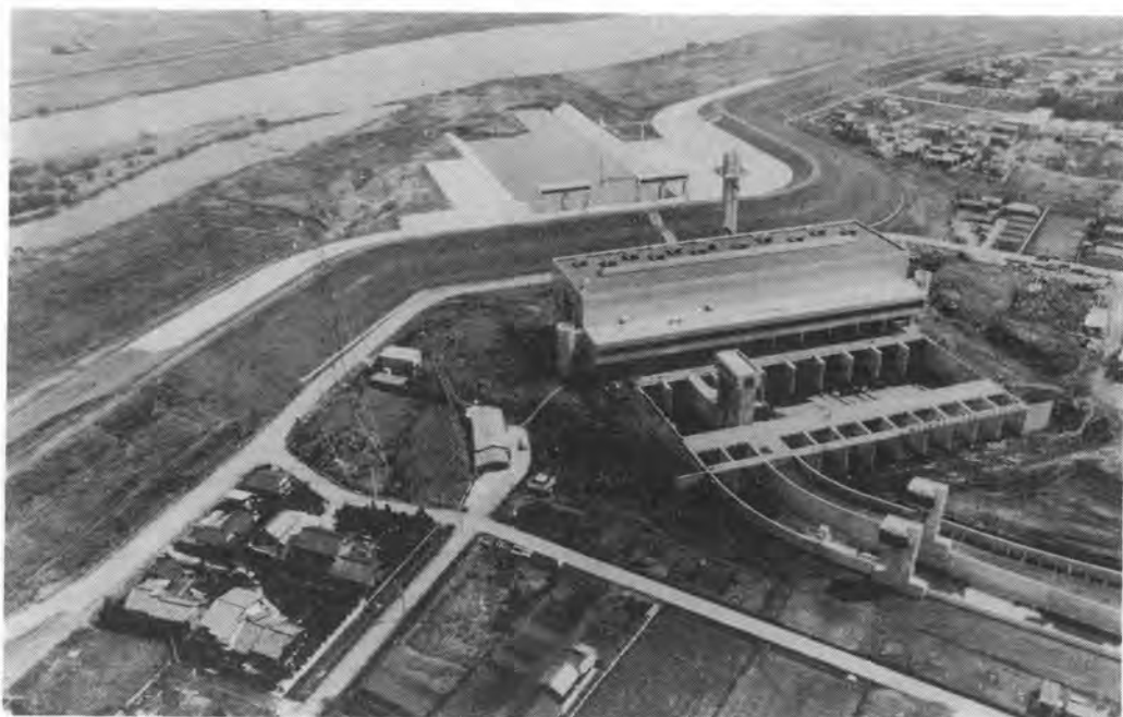
写真-1 上空より見た三郷排水機場
