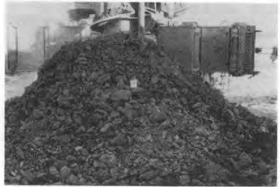
写真-5 掘削中に排出されたれき(中央に白く見えるのがタバコの箱)
