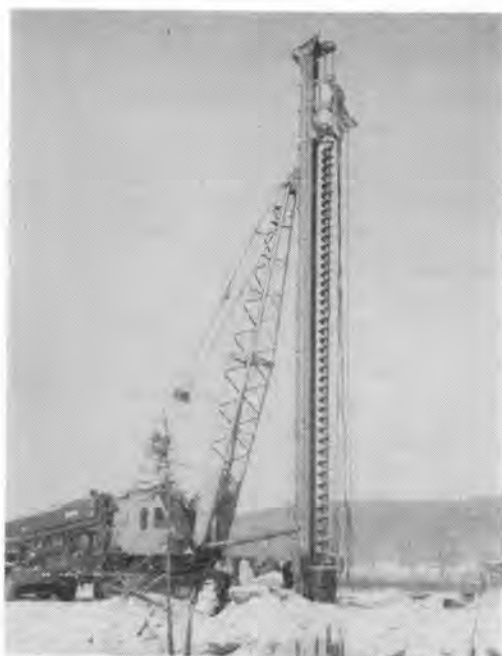
写真-1 オーガ機全景
