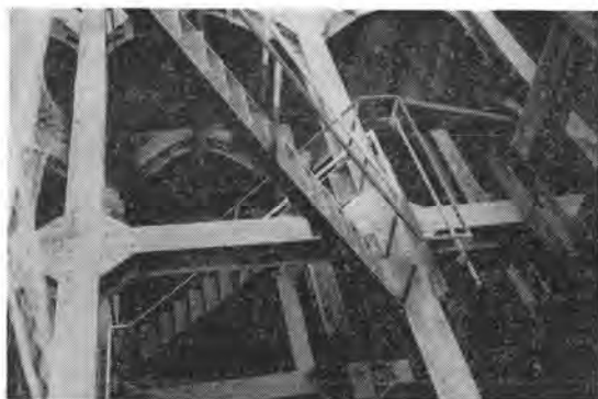
写真-3 井筒内状況
