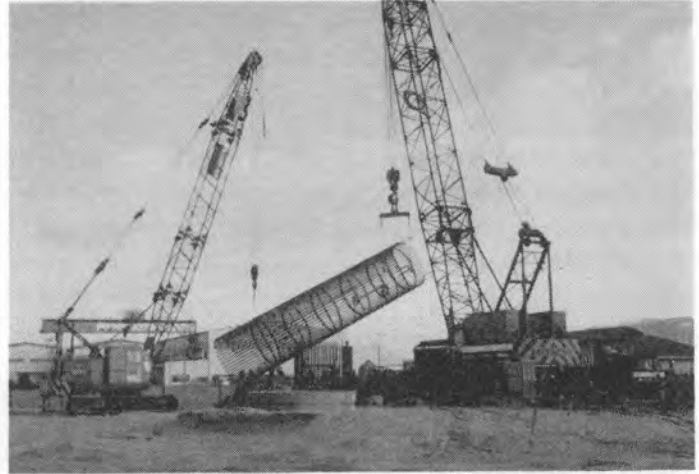
写真-6 鉄筋かごの相づり
