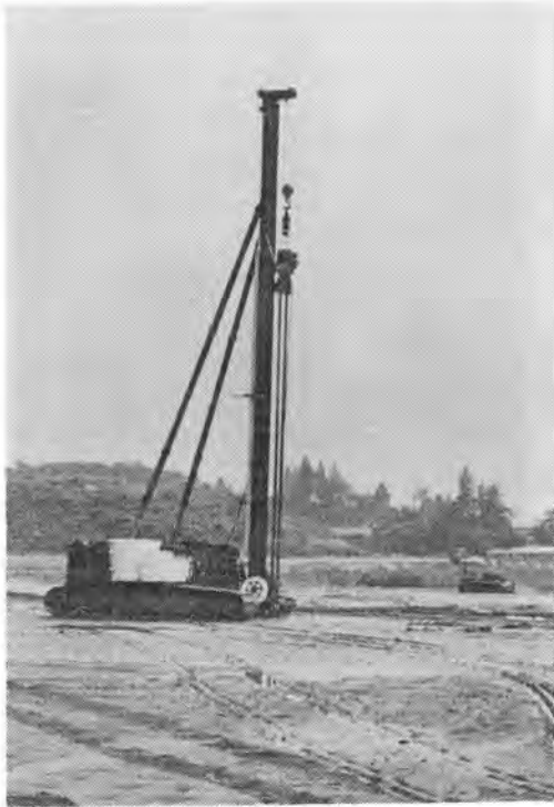
写真-8 パイプロハンマ式 (2連打)
