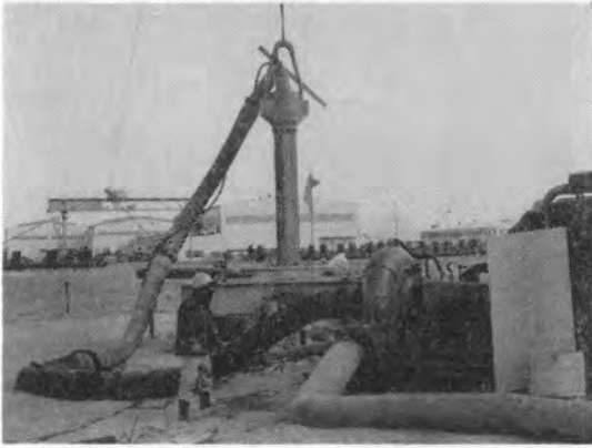
写真-3 S 600 による掘削
