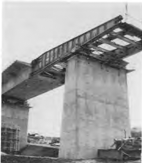
写真-5 鋼製手延げた
