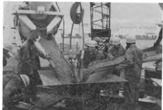
写真-10 コンクリート打設
