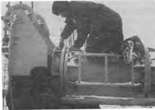
写真-2 素手で組立中の作業員
