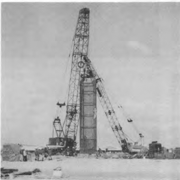
写真-7 鉄筋の建込み
