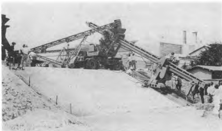
写真-2 のり面コンクリートの打設状況
