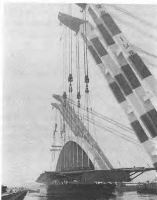
写真-4 けた積載作業
