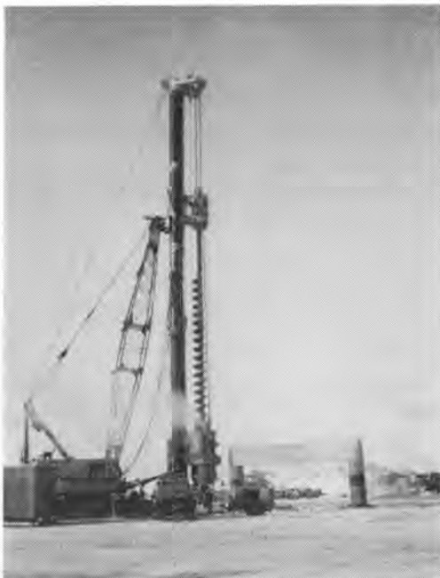
写真-7 凍ったサグ河とドーナツオーガ (中央の門形は完成した橋脚)
