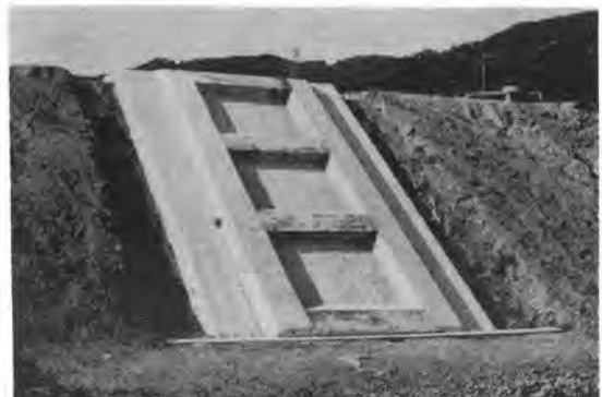
写真-5 のりわく型コンクリート版(横わくは人力打設したもの)
