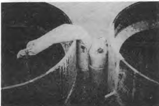
写真-2 継手管の処理
