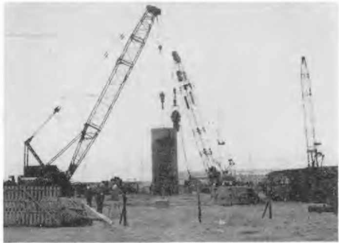
写真-2 スタンドパイプの打込み
