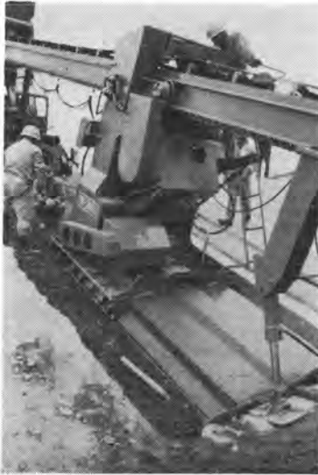
写真-3 スライディングフォームと1次打設作業状況
