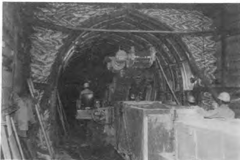
写真-1 掘削中の FL-R 23
