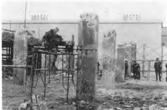
写真-8 火炎ジェットによる柱の溶断状況
