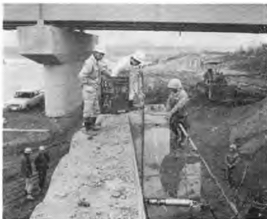
写真-6 ダルダによる橋台の破壊状況
