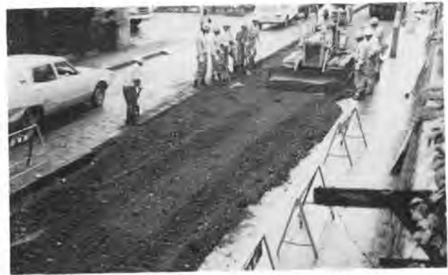
写真-6 再生アスファルト混合物の敷きならし
