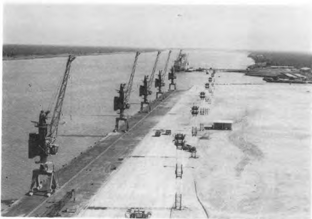
写真-7 竣工全景
