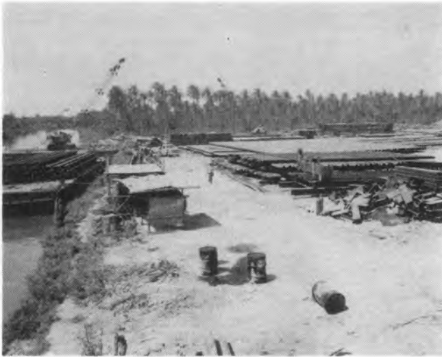
写真-1 材料置場および物揚場
