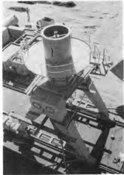
写真-6 クレーンの組立
