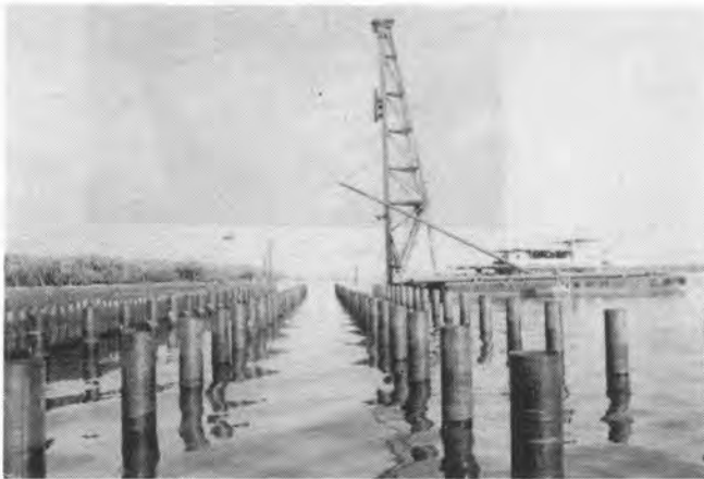
写真-3 鋼管の打設
