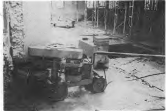
写真-10 TAC-H 型による柱の切断状況
