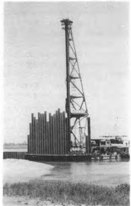
写真-2 鋼矢板の打設
