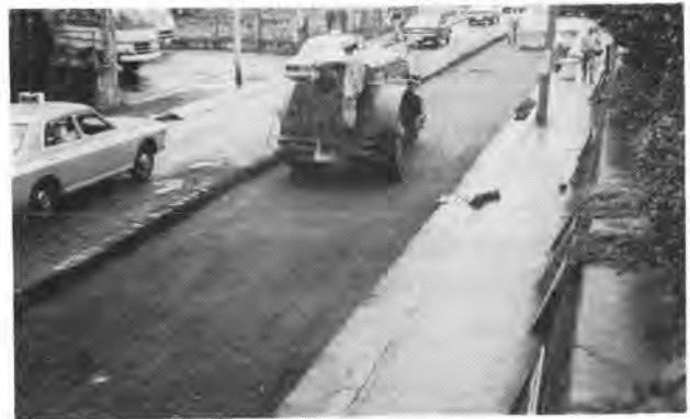
写真-7 再生アスファルト混合物の転圧
