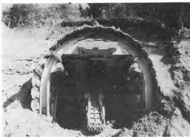
写真-3 26号トンネルを貫通したブレードシールド (国産1号機)
