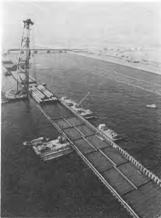
写真-2 打設中のくい打ち船と打設の完了した所
