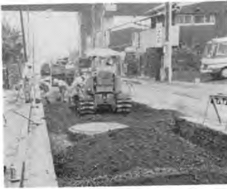
写真-5 再生路盤材の施工
