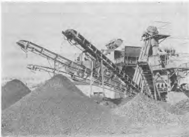
写真-1 プラント全景
