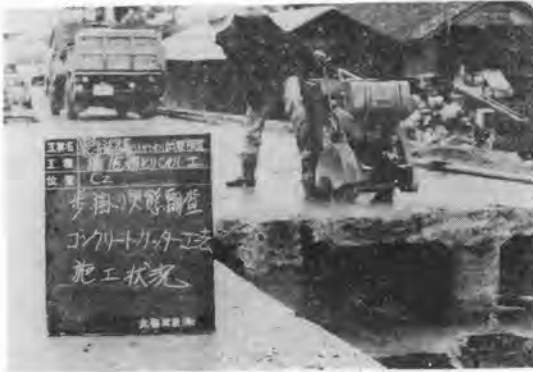
写真-9 カッタによる橋梁床版切断状況
