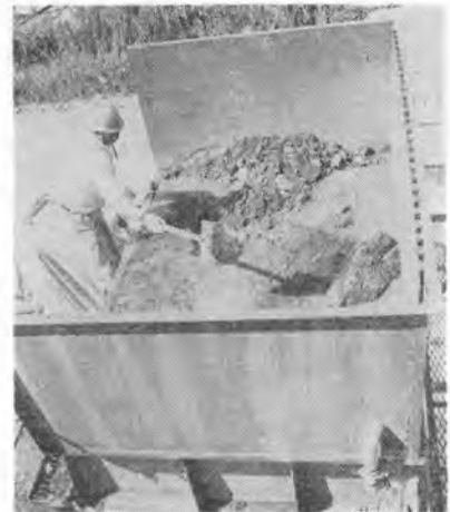
写真-3 溶解槽の内部
