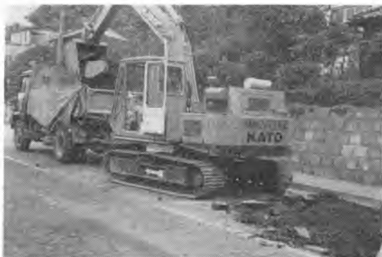
写真-1 バックホウによる廃材の採取
