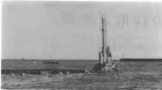
写真-3 浚渫テスト状況
