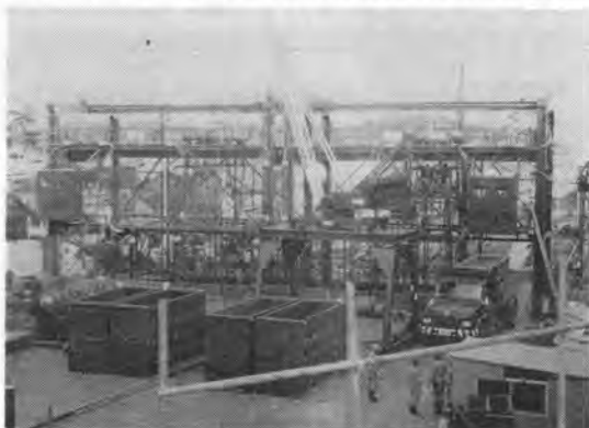
写真-3.7.1 石川島播磨・ずりコンテナシステム
