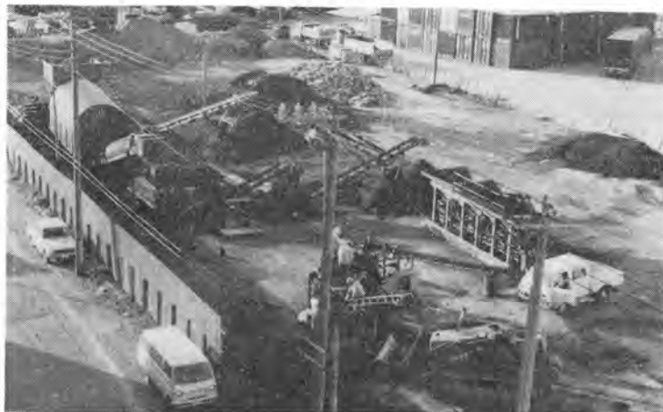
写真-2 リサイクルプラント全景
