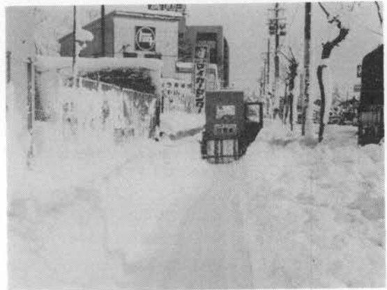
写真—2 踏固め実験車による圧雪工法
