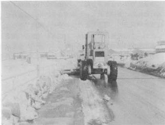
写真—1 車道からの除雪グレーダによる歩道除雪
