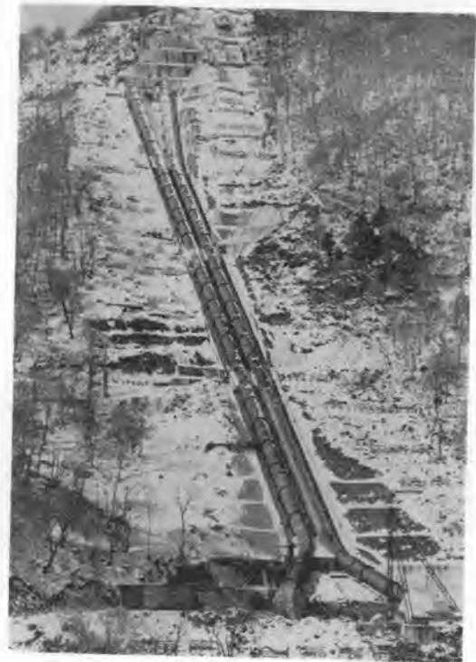
写真-1 露出部鉄管
