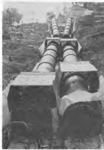
写真-3 外面溶接用足場
