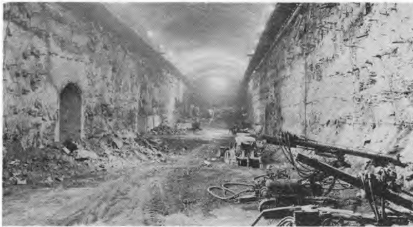
写真-3 地下発電所本体掘削状況
