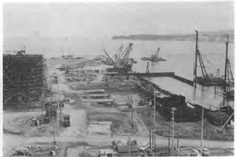
写真-2 取水口工事締切施工状況
