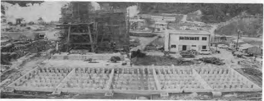
写真-1 冷却塔の基礎コンクリート打ち
