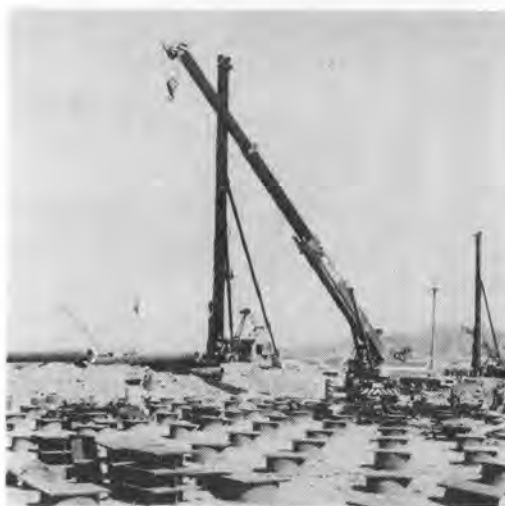
写真-5 タンク基礎くい打ち状況
