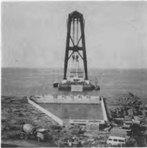
写真-3 放水口前面ケソン据付
