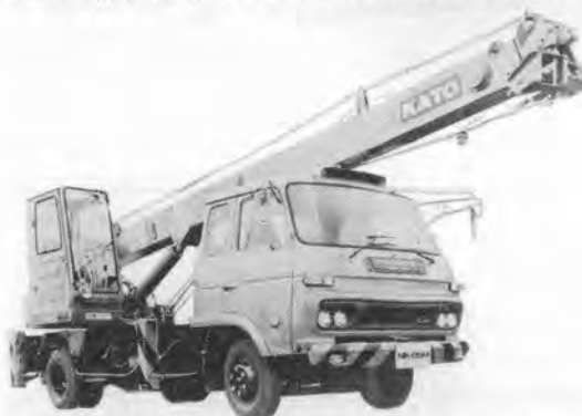
写真-3.5.2 加藤 NK-65 M トラッククレーン 表-3.5.2 NK-65, NK-65 M の主な仕様
