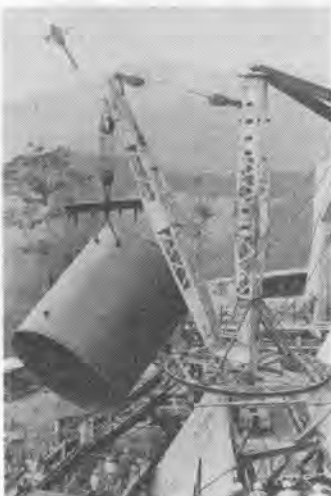
写真-2 架台とデリッククレーン
