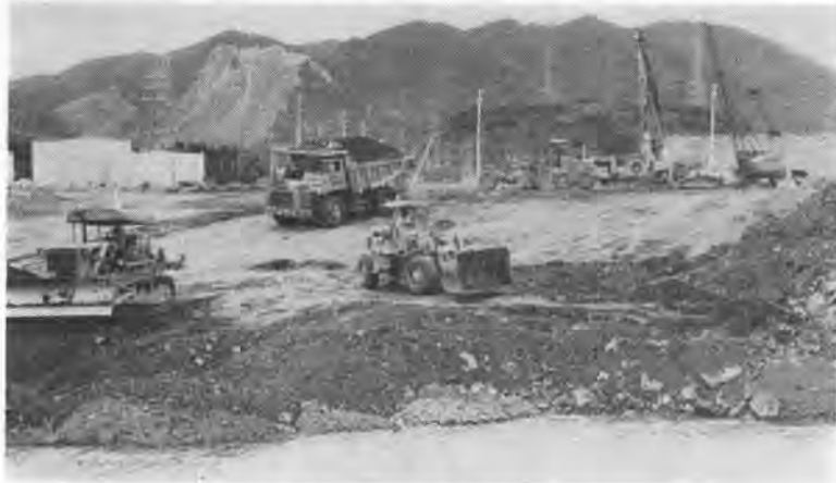
写真-1 敷地造成重機稼働状況
