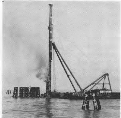
写真-4 揚油岸壁くい打ち状況
