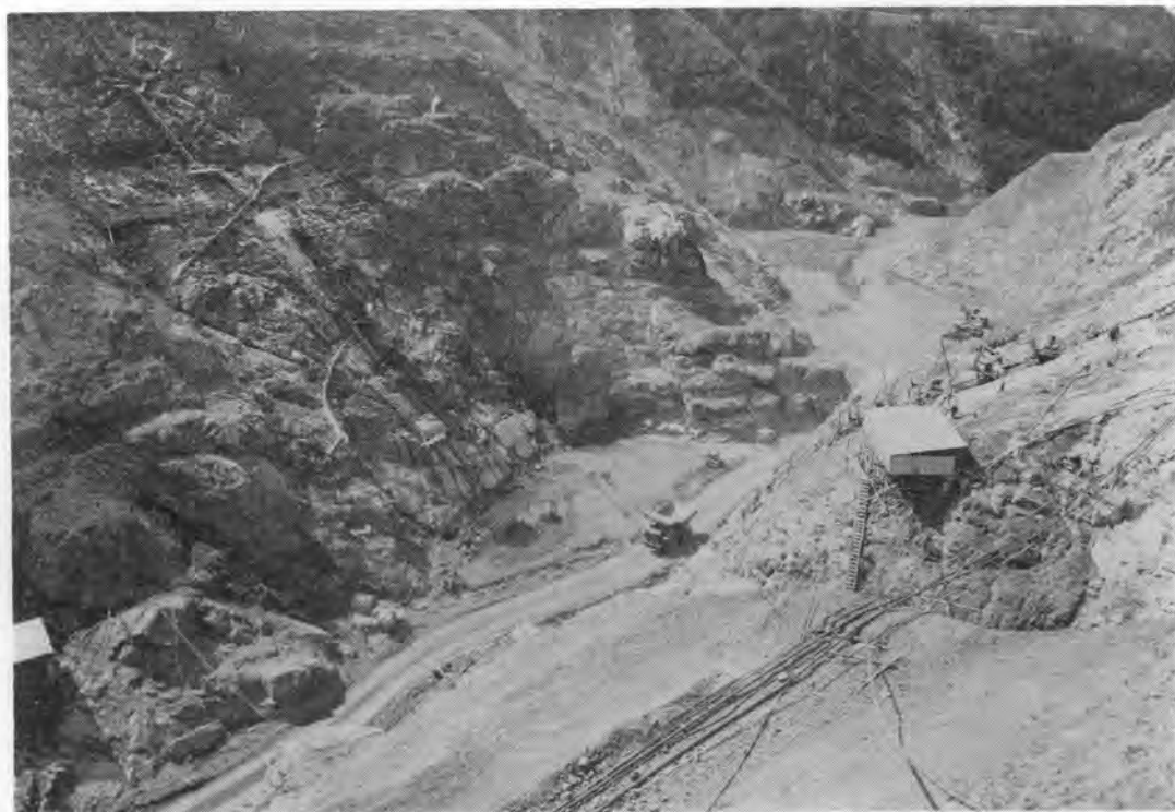
写真-1 瀬戸ダムの盛立状況
