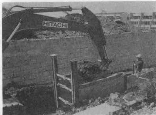
写真-2 クリングス工法による下水溝の掘削
