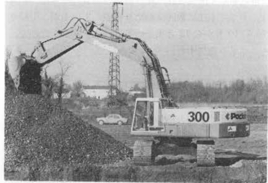
写真-3.2.2 ボクレン 300 CK 油圧ショベル
