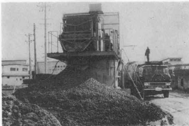
写真-3 P4C の稼働状況
