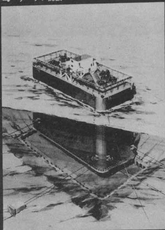
6 海中コンクリート打設
