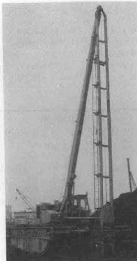
写真-6 → 日立 MA 100 U 超湿地パイルドライバ
