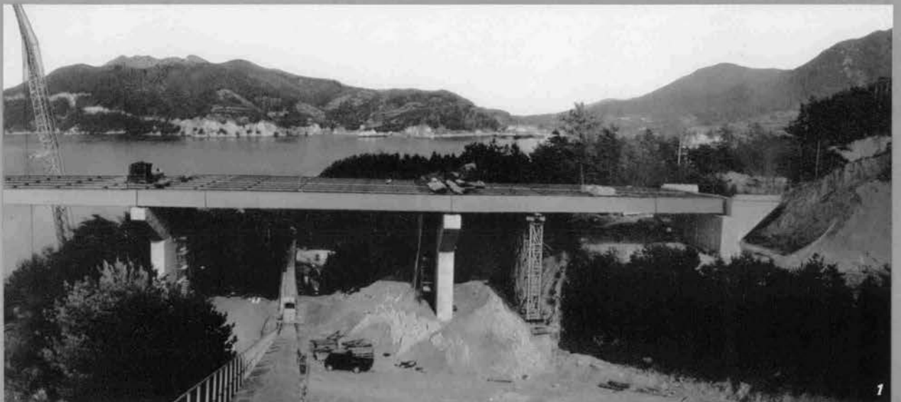
1. 伯方島側架橋現場 (橋下のコンベヤは海より骨材を運び上げるもの)
