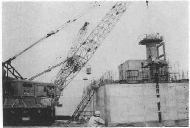
写真-5 ロックの据付
