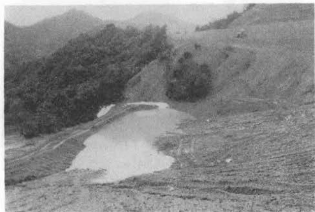
写真-5 仮沈砂池
