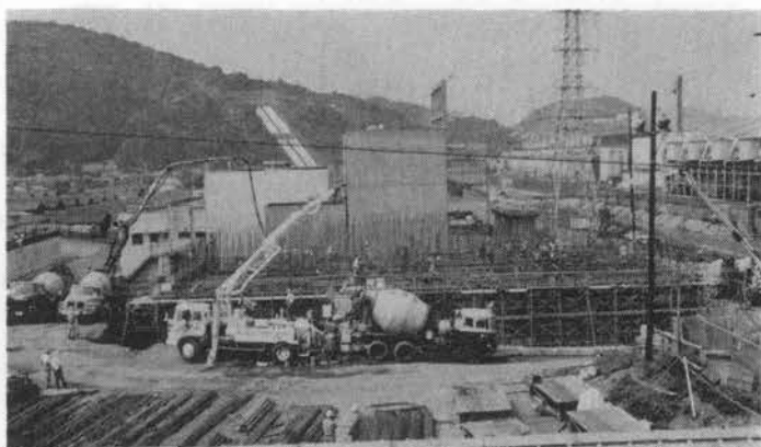
写真-4 第2ロットのコンクリート打設
