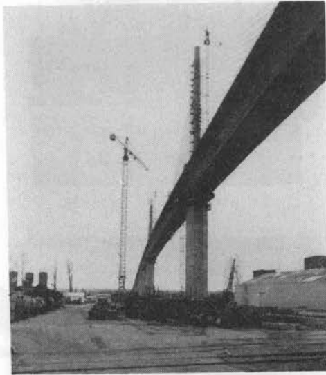
写真-4 プルトニュー橋の工事現場
