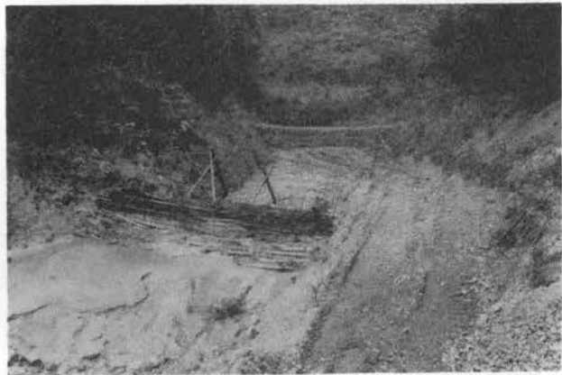
写真-4 蛇かごとそだわく工
