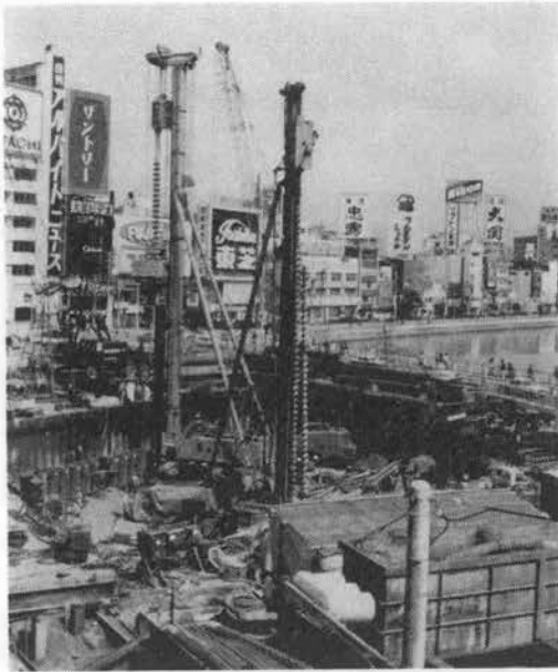
写真-3 那珂川河川内の鋼管矢板打ち
