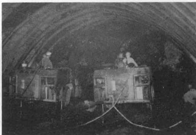
写真—2 松尾トンネルにおける作業状況
