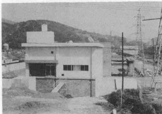
写真-1 蒲原揚水機場
