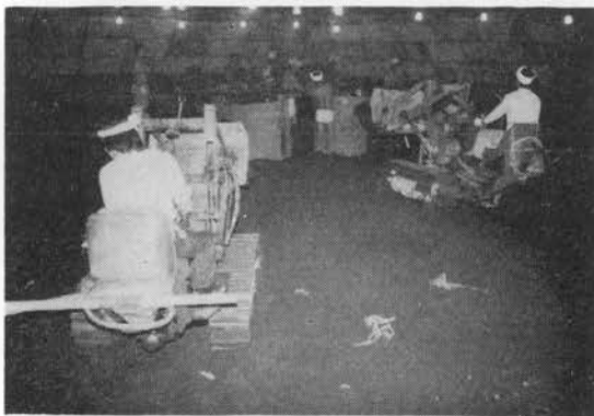
写真-6 電気ショベルによる掘削
