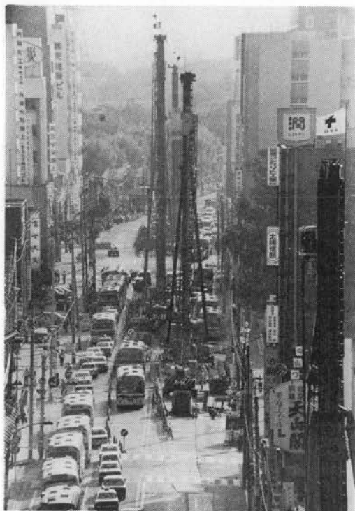
写真-1 赤坂~大名付近におけるくい打ち状況
