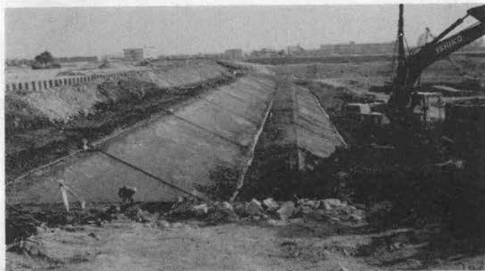
写真-3 → オープンカット工法(掘削面積 約 42,500 m 2 , 平均掘削深さ約 10.0 m)
