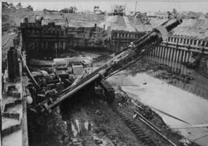
◀アースオーガ併用による鋼矢板打込作業 全油圧式クローラドリルによるアースア ンカー用さく孔作業 —清水市北部終末処理場—
