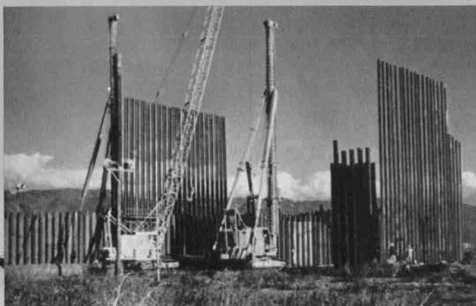
山留用鋼矢板建込作業 (V型, 27m) ▶ ▼沈砂池・ポンプ室山留支保工設置作業 (掘削面積 27m × 68m) —諏訪湖流域下水道豊田終末処理場—
