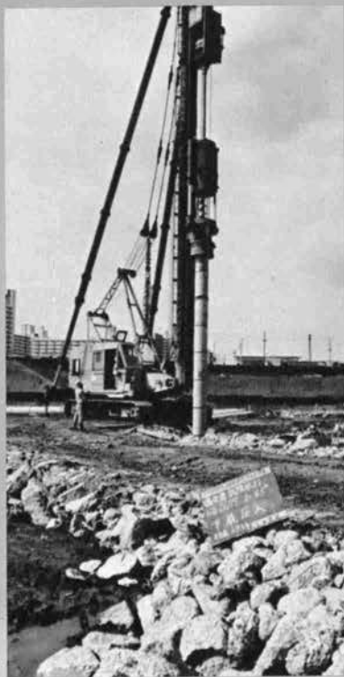
▲オープンカット工法におけるディープウェル設置 —富士市終末処理場— 中掘くい打ち機によるPCくいの打込作業▶ (油圧能力45t)
