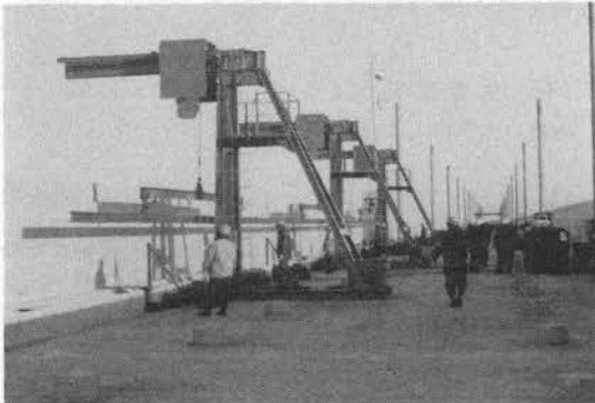
写真-4 高架上のクレーン据付およびレールつり上げ状況
