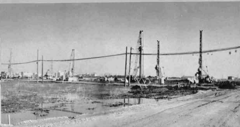
◀流動化地盤改良工・サンドコンパクションバイブル施工中▲ —江戸川左岸流域下水道江戸川第二終末処理場—
