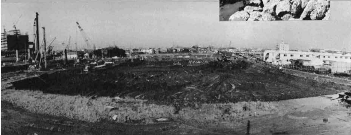
▼水処理施設オープンカット工法 (オープンカットの大きさ約1万m 2 ) —東京都中川処理場—
