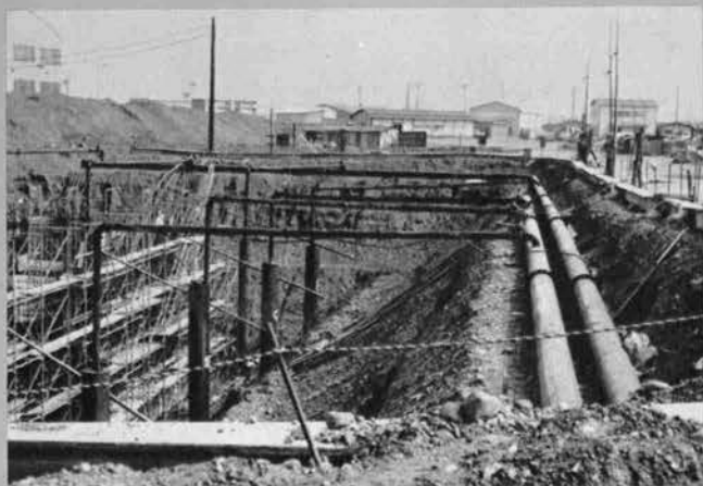
▲オープンカット工法におけるディープウェル設置 —富士市終末処理場— 中掘くい打ち機によるPCくいの打込作業▶ (油圧能力45t)
