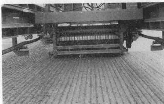
写真-36 グルーピング施工状況
