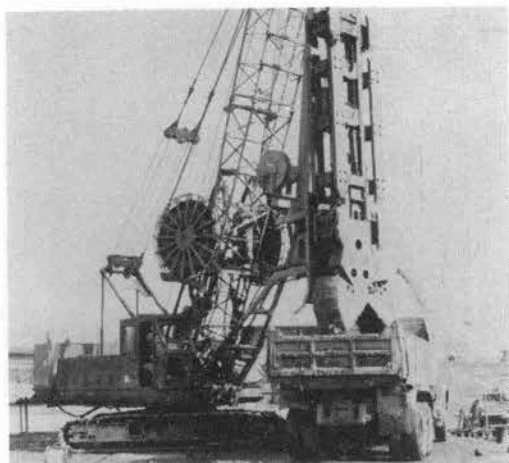
写真-8 地下連続壁掘削機 MHL-5070
