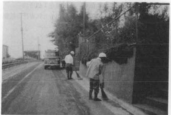
写真-5 沿道の清掃
