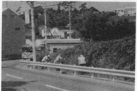
写真-6 沿道の除草
