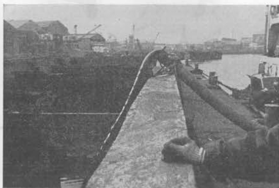
揚泥(含泥率93.5%)状況
