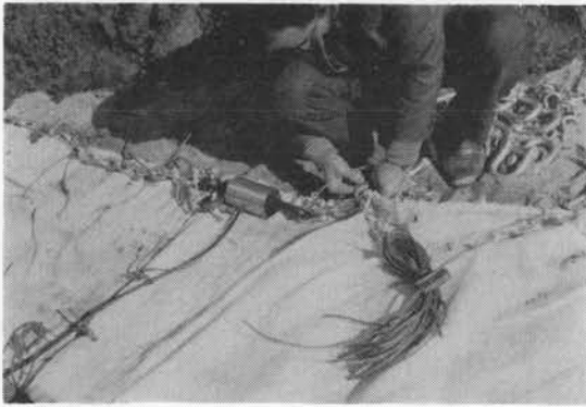
写真-5 張力計の取付
