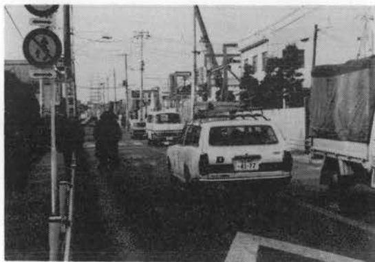
写真-1 シールド通過部道路状況
