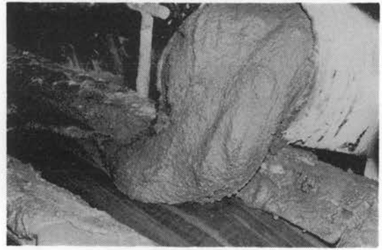
写真-4 泥土排土状況
