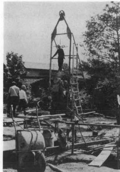
写真-1 生麦トンネル JST 注入工事
