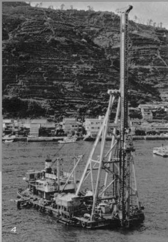
6. 打設管貫入状況 (正面が貫入推力となる油圧モータ、左に生石灰の投入口が見える…… DLM 工法)
