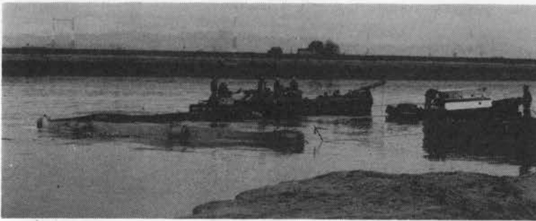
写真-2 敷設状況
