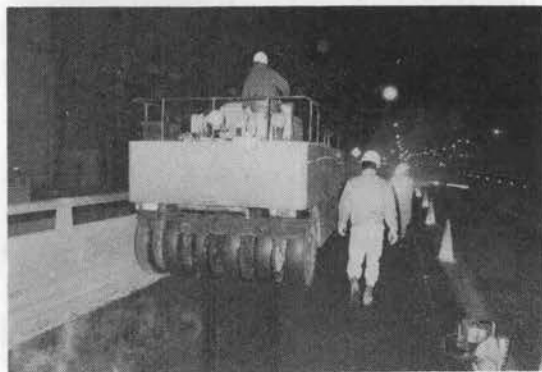
写真-6 タイヤローラによる2次転圧
