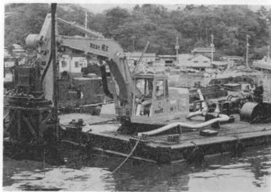
写真-10 神鋼 MK-7 汚泥浚渫船
