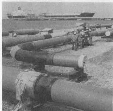
写真-2 フロータ用長管製作ヤード
