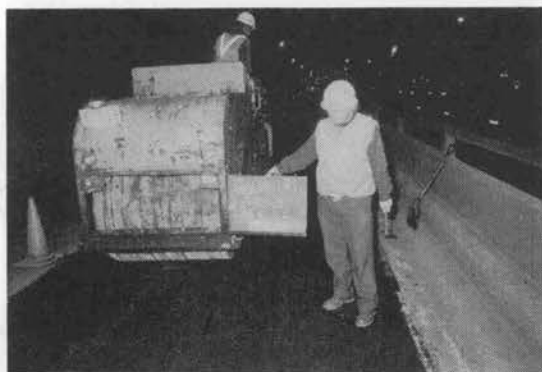
写真-7 タンデムローラによる仕上げ転圧
