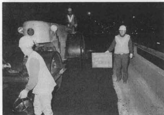
写真-5 マカダムローラによる初転圧
