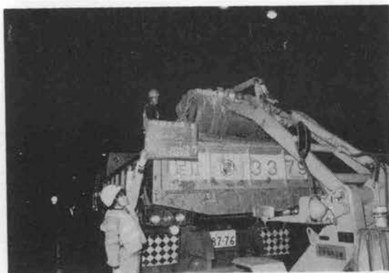
写真-3 廃材の積み込み
