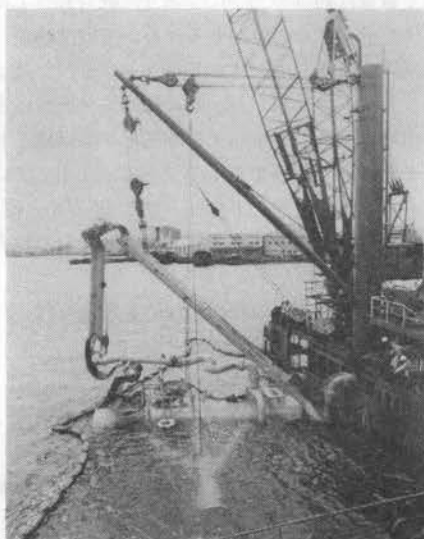
写真-6 連絡管接合状態
