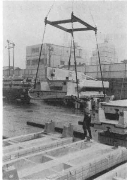
写真-1 柱型PCの荷卸し
