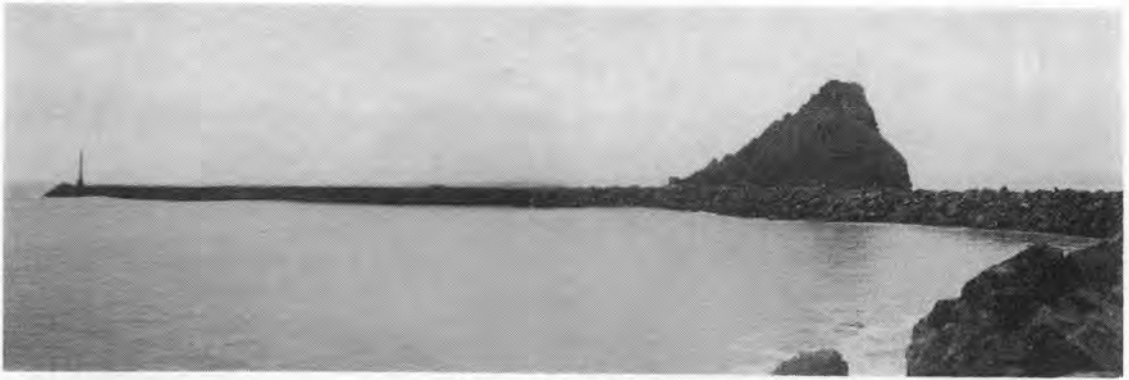
写真-4 築造中の防波堤
