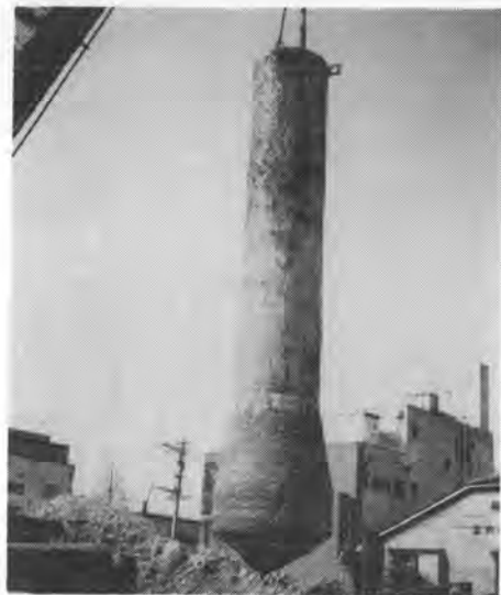
写真-3 掘起された TKR ぐい（長さ 15 m の下半分約 7.5 m 部分）
