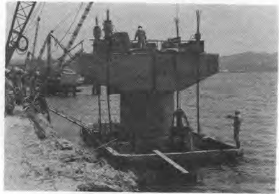
写真-4 つり上げ前の止水壁
