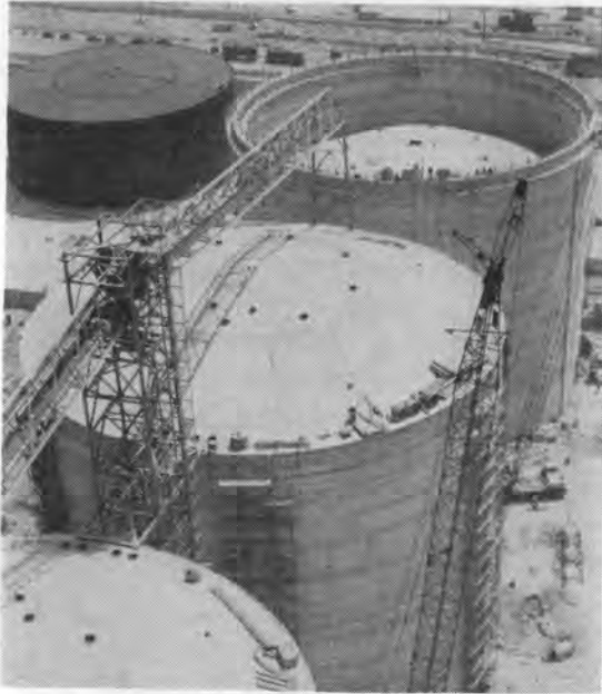
写真-10 コンクリートサイロの屋根スラブ取付工事
