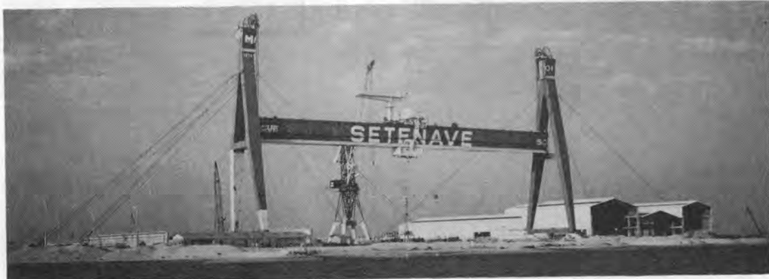
↑ 写真-7 つり上げ中のクレーンブリッジ
