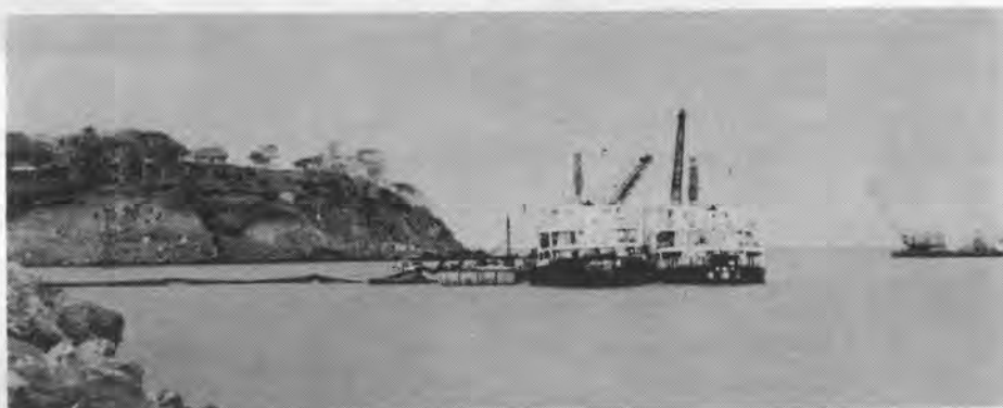
写真-3 埋立中のポンプ船
