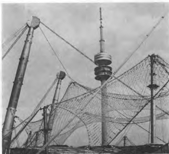
写真-6 オリンピック競技場のテント建方
