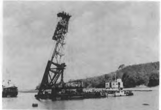
写真-5 くい打ち船
