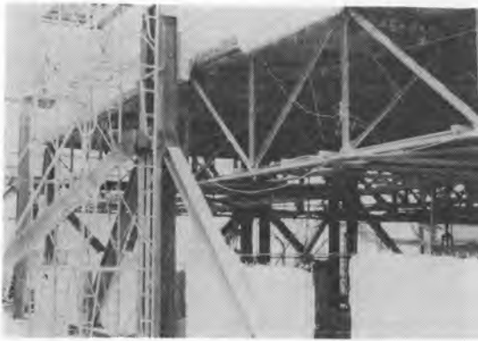
写真-3 つり上げられた屋根と仮設柱
