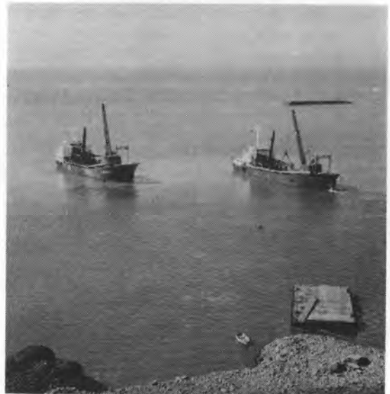
写真-6 浚渫中のグラブ船
