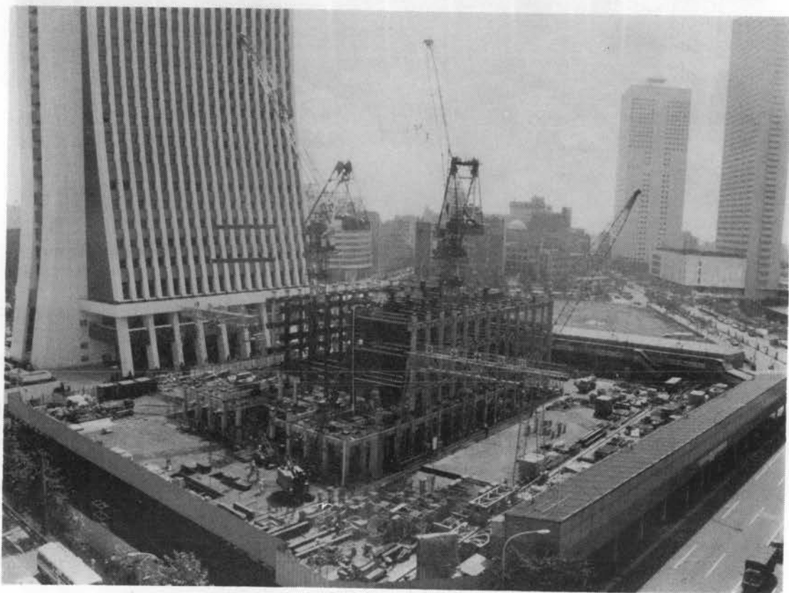
写真-4 鉄骨工事
