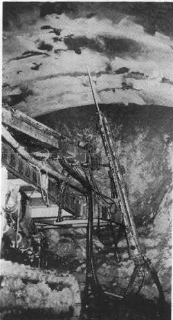
↓ 写真-2 上段掘削
