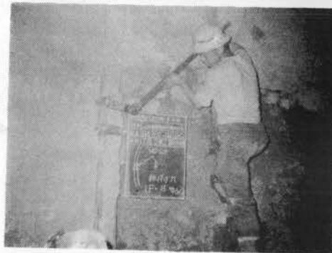
← 写真-4 可縮支保工締付状況
