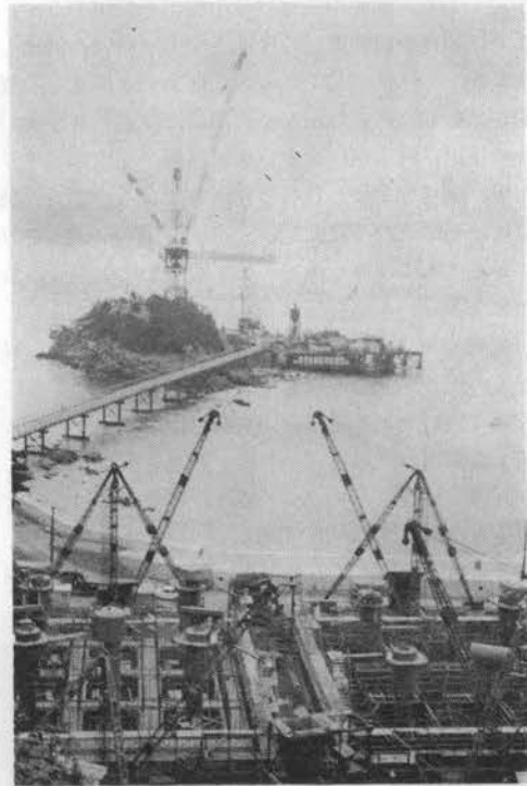
写真-5 鳴門側から見た5Aと4Pの足場
