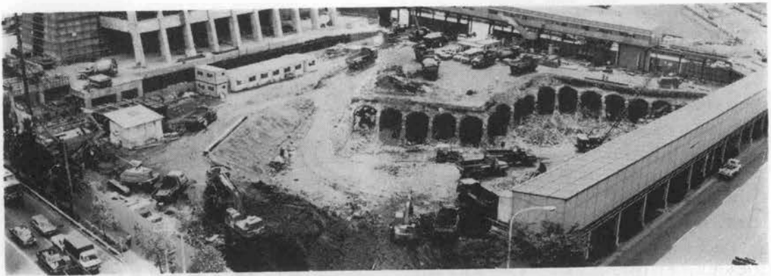
写真-1 掘削工事（地中障害物の撤去）
