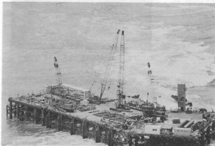
写真-6 施工中の3P海上足場
