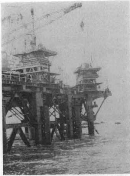
写真-3 根固め掘削中
