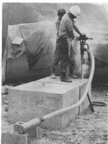
写真-2 消音マフラ (M-20型) を取付ける
