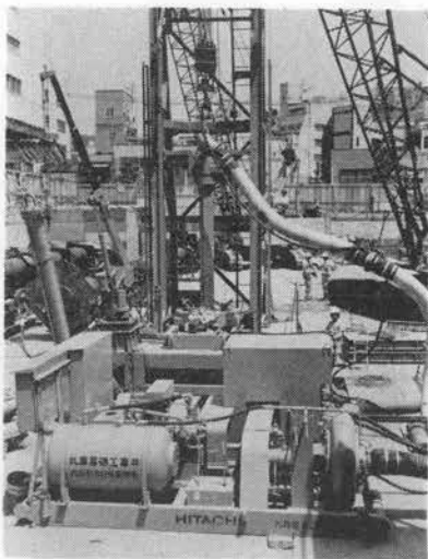
写真-15 日立 S400H リバースサーキュレーションドリル
