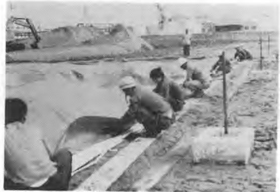
写真-1 ファゴットシート+山砂+K ソイル固定わく
