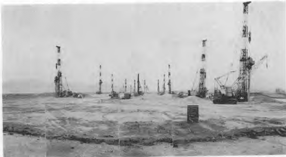
写真—3 サンドコンパクション打設状況
