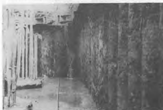
(JST施工—東海道貨物別線大口高架橋工事)
