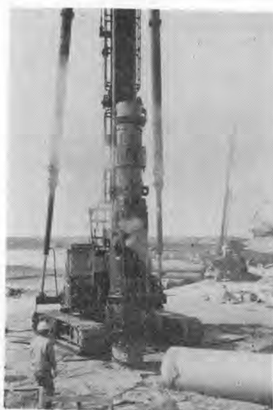
写真-2 8 t ディーゼルパイルハンマによるくい打ち
