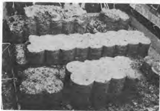
写真-1 壁状の改良土
