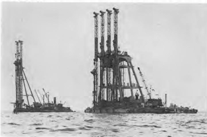
写真-1 海上施工機
