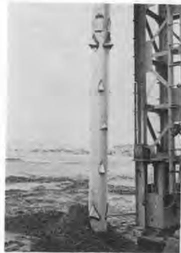
写真-2 施工中のパイプロッド工
