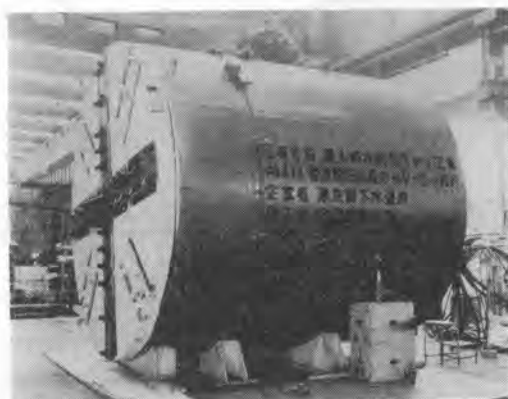
写真-8 日立 CP シールド掘進機
