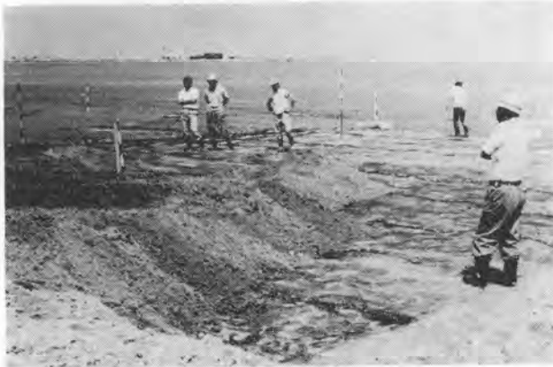
写真-2 トリカルネット(N 29)+山砂
