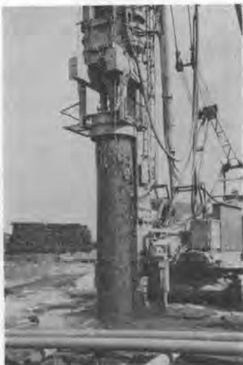
写真一 TAIP 工法作業状況
