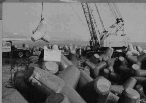
100tクレーンによる テトラポット (25t) の据付▶
