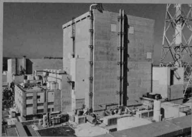
◀完成した原子炉 およびタービン建屋
