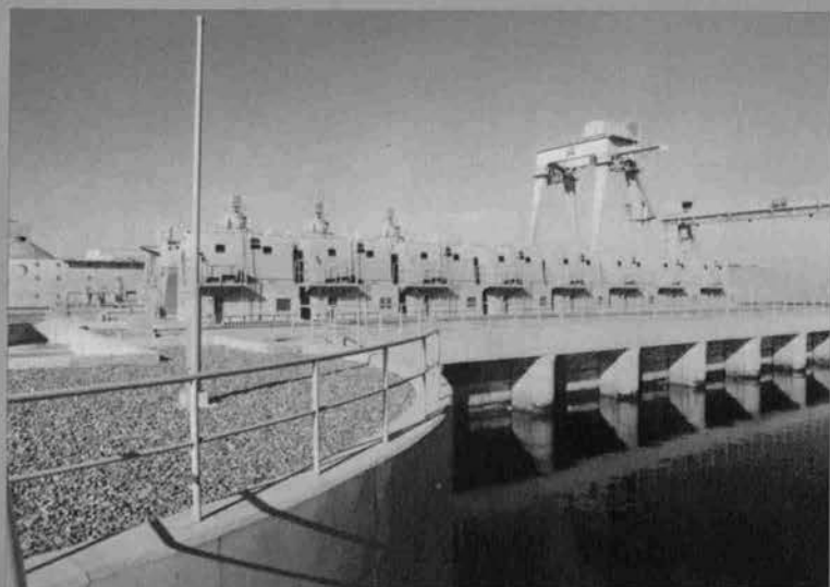
◀冷却水の取水口 (最大取水量 65 \text{ m}^3/\text{sec} )
