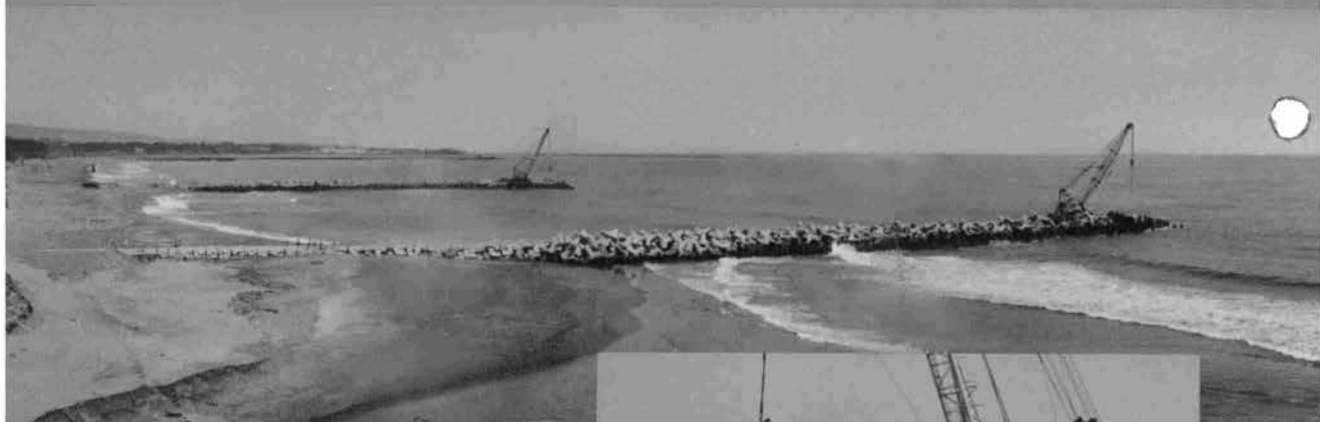
▲南北防波堤の施工状況
