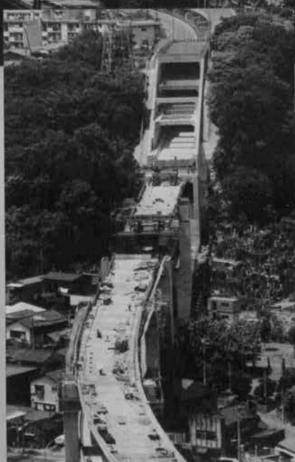
▲首都高速道路横浜高速1号線 三ッ沢換気所
