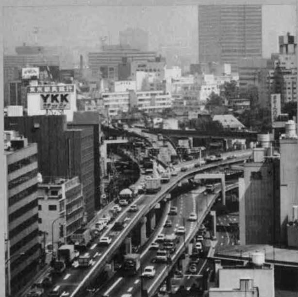
▼首都高速道路3号線（谷町）
