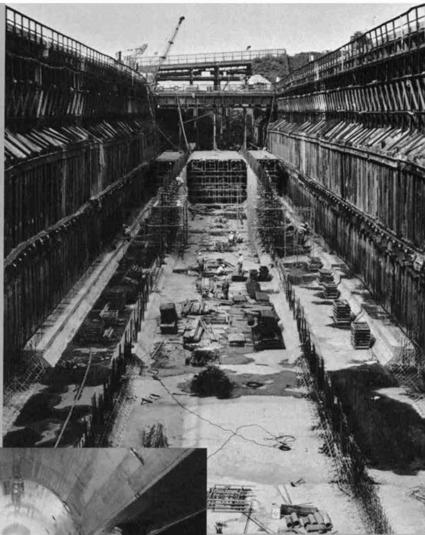
▲土留アンカー工法による 市ヶ谷駅付近の外濠内工事
