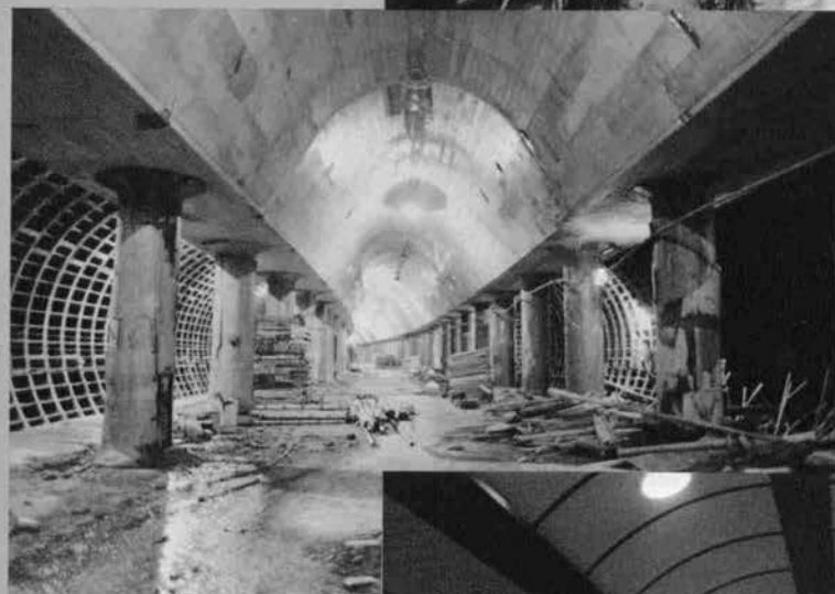
▲工事中のめがね形 シールド駅 仕上げ工事が完成した めがね形シールド駅▶
