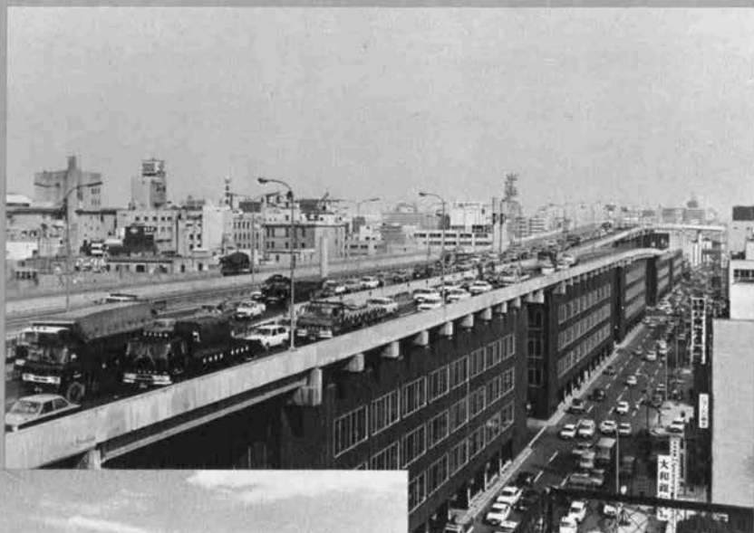
▲阪神高速道路東大阪線（船場）
