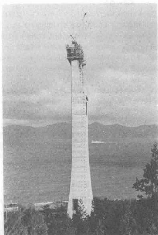
写真-1 滑揚完了時の無線中継塔
