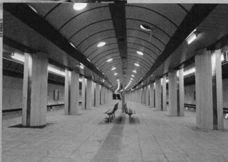
▲工事中のめがね形 シールド駅 仕上げ工事が完成した めがね形シールド駅▶
