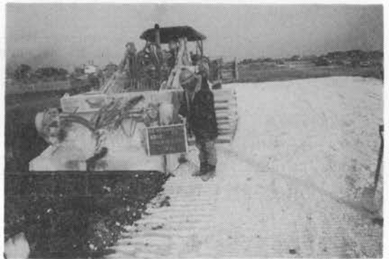
写真-3 ディープスタビライザによる1次混合 (1~3 工区)
