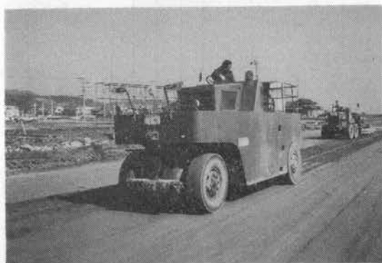
写真-8 本転圧状況
