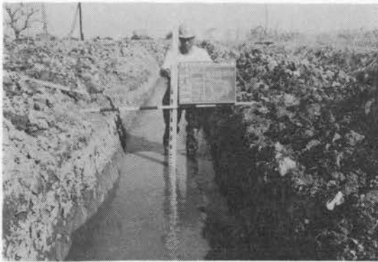
写真-1 トレンチ掘削状況
