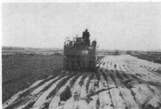
写真-7 仮転圧状況
