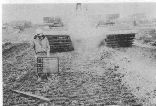
写真-6 ソイルライマによる2次混合(4~6工区)
