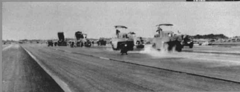
◀滑走路の アスファルト舗装
