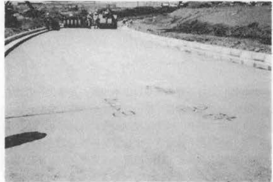
写真-4 路盤の仕上り(A区間は粒度調整砕石、B区間は粒度調整再生材)
