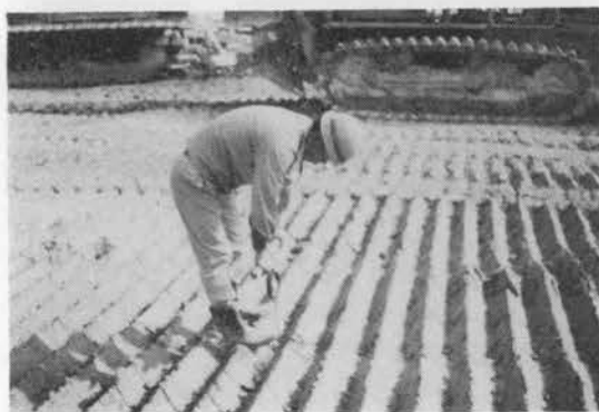
写真-10 コーン貫入試験による強度管理
