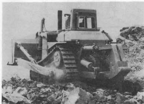
写真-3 リッピング作業
