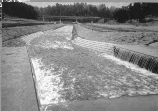
雨水排水場外排水路▶
