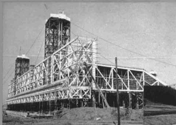
◀日航ジャンボハンガーの鉄骨組立て
