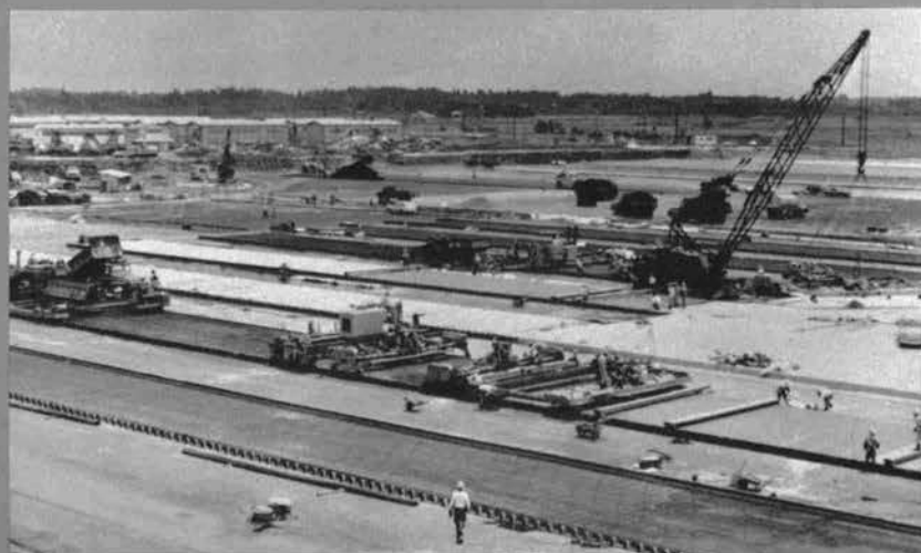
◀エプロンの コンクリート舗装
