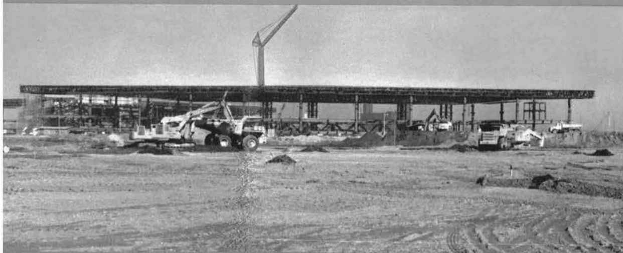
▼旅客ターミナルの鉄骨組立て
