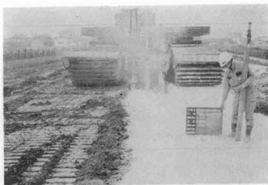
写真-4 ソイルライマによる1次混合(4~6工区)
