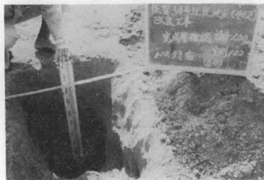
写真-11 施工終了後の混合厚さの管理
