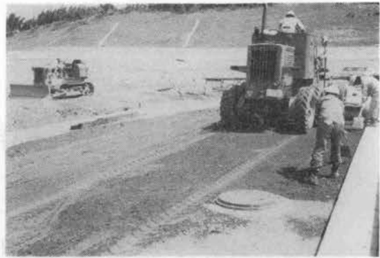
写真-3 路盤材の敷きならし(粒度調整再生材、厚さ20cm)
