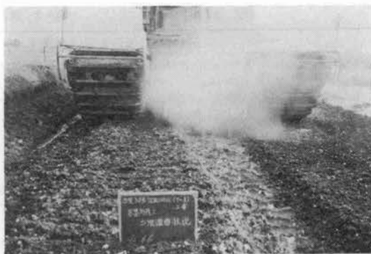
写真-5 マッドスタビライザによる2次混合(1~3工区)
