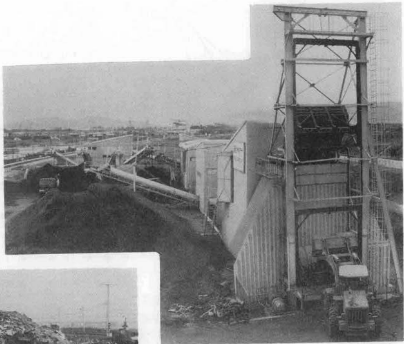
写真-1 破砕プラント全景
