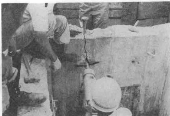
写真-2 通信用マンホールの撤去(側壁部材の割裂)
