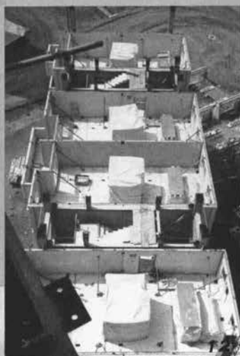
10. 地上躯体用移動式クローラ クレーン (50 t 級, 14 階用) 11. 地上躯体用定置式タワーク レーン (29 階用) 12. および 13. 積層工法による組立て
