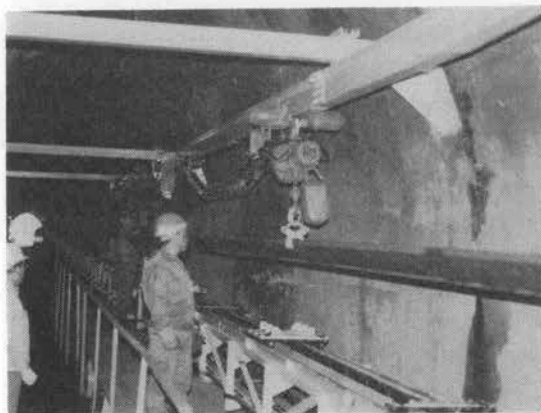
写真-2 チェンコンベヤからチェンブロックへのレール積替え状況
