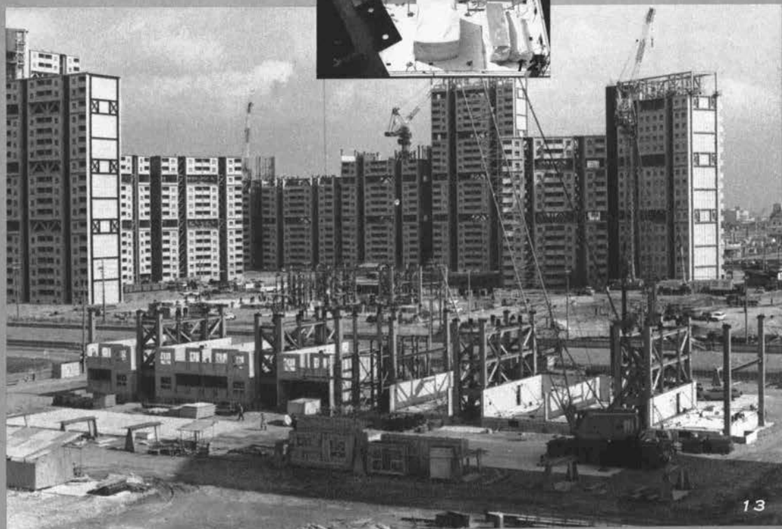
10. 地上躯体用移動式クローラ クレーン (50 t 級, 14 階用) 11. 地上躯体用定置式タワーク レーン (29 階用) 12. および 13. 積層工法による組立て
