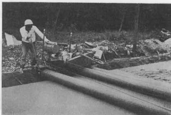
コンクリートローラーフィニッシャー 港湾、阜頭、道路、空港等仕上
