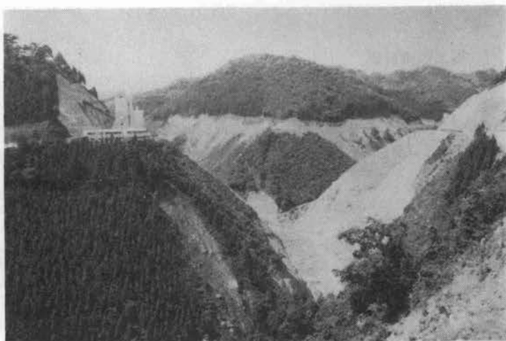
写真一 下流側より見たダムサイト
