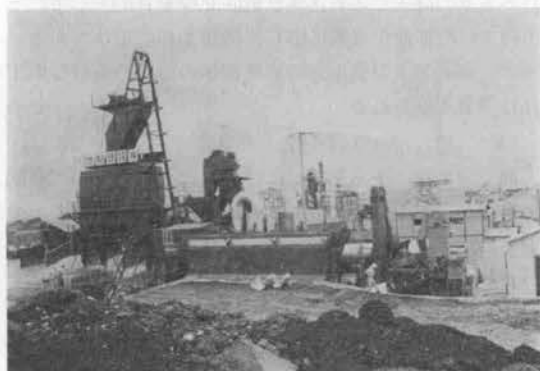
写真—35 スチーム式リサイクルプラント
