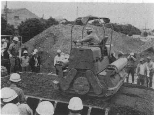
写真一2 転圧試験中の BW-200
