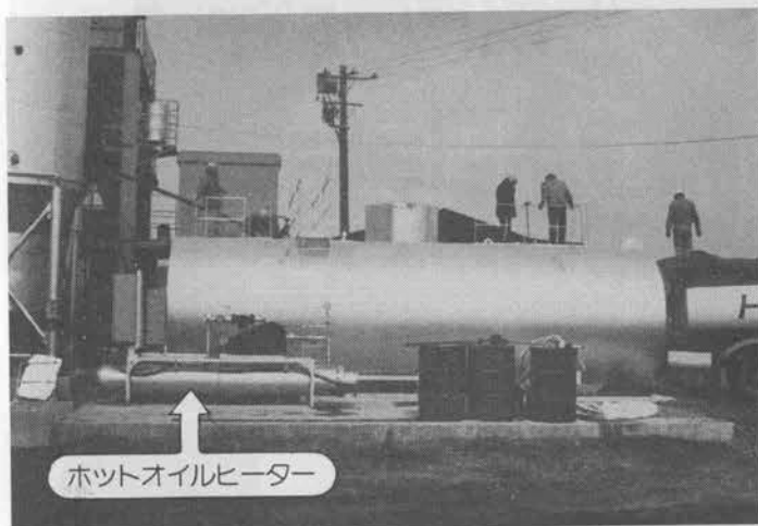
これは60Tonアスファルトプラントにアスファルトタンクヒーターと ホットオイルヒーターを設置した例です。
