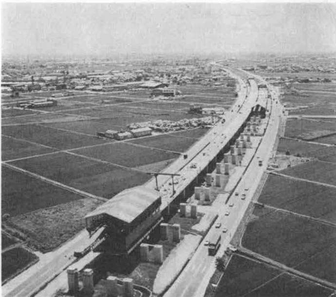
写真-1 金沢高架橋 PC 工事区間全景
