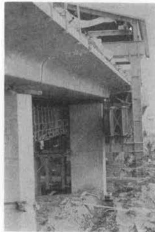
← 写真-4 後方より見た 支保工と床版
