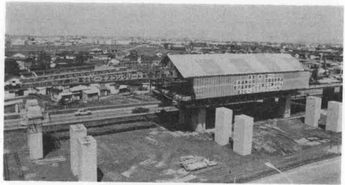
写真-11 FPS 式移動つり支保工
