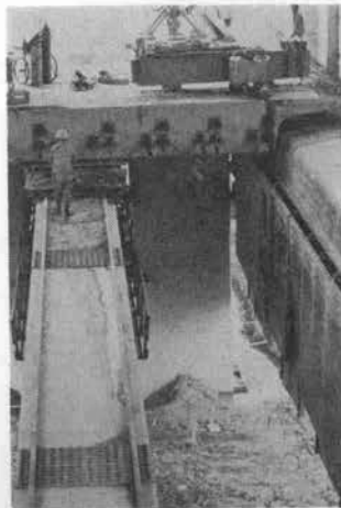
→ 写真-2 ストラバーク方式可動支保工の移動
