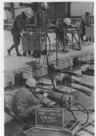
写真-7 緊張作業→
