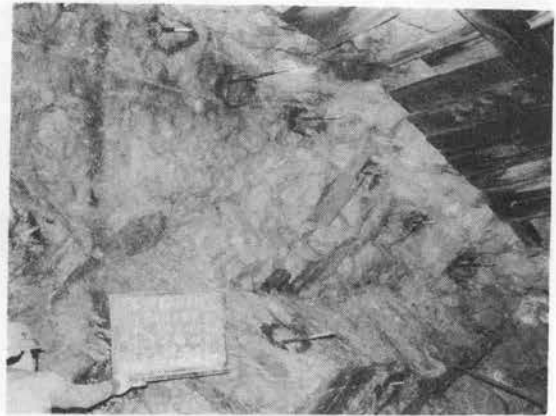
写真-4 ロックボルト施工状況
