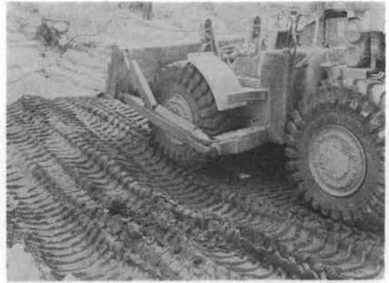
写真—4 ホイールドーザによる岩着部のコア材料締め固め (1976年6月)
