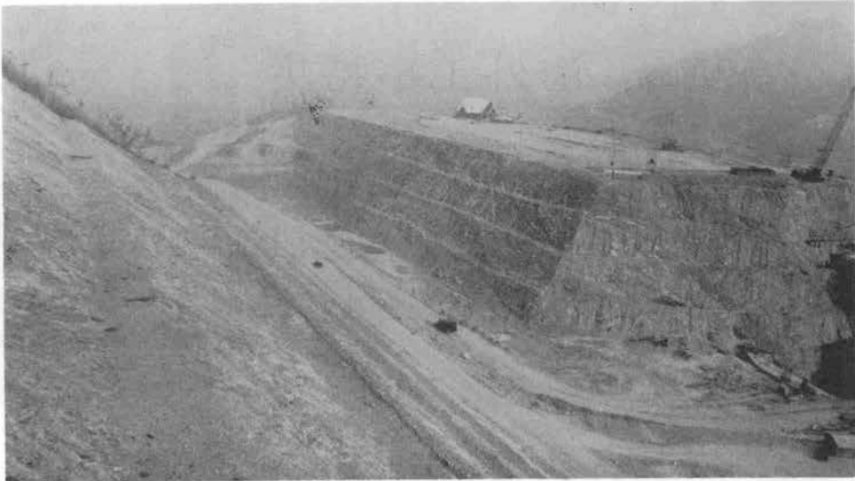
写真一5 プレスブリティ工法によるアプローチチャンネルの掘削（1977年8月）
