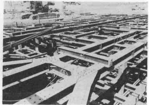
写真-5 インテークの山留工事
