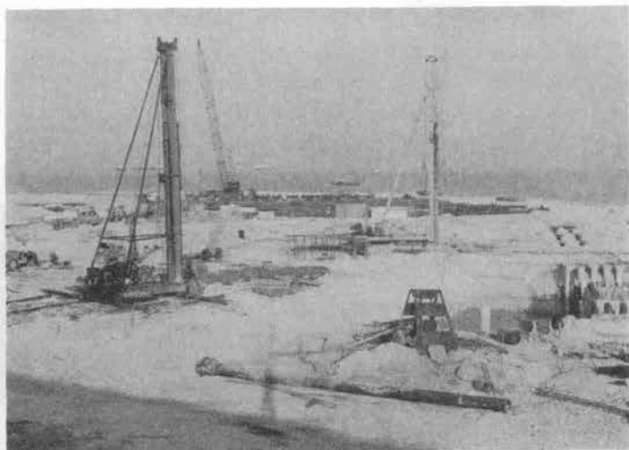
写真-1 ニュードーハホテル建設工事（昭和52年5月頃）
