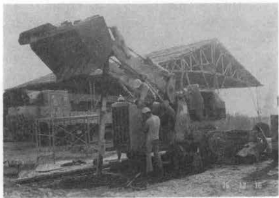
写真—2 現地人メカニックによる修理状況
