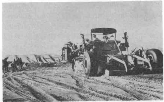
写真-4 “砂漠に緑を” アスファルト阻水盤敷設に従事する Asphalt Moisture Barrier
