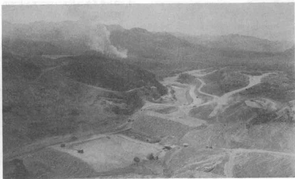
写真-2 施工中のシーナカリンダム (1976 年 3 月)
