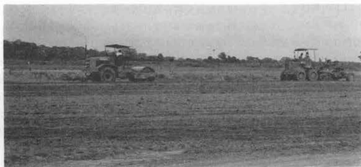
写真一 バイブレーションローラによる主滑走路の締固め
