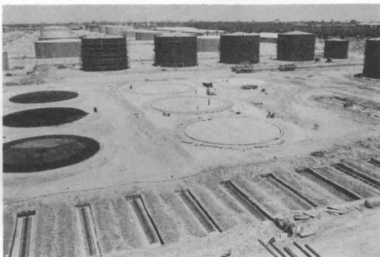
写真—1 タンク基礎工事 (1977年3月)
