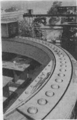
写真-2 ターンテーブル 組立 →
