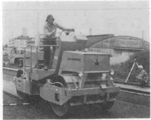
写真1 構内転圧試験
