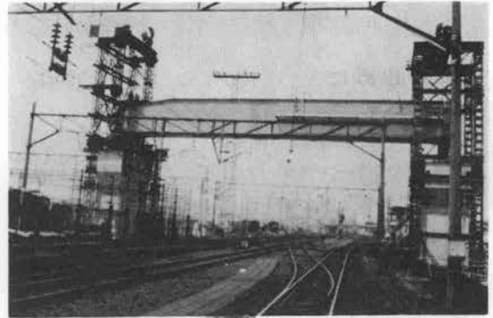
写真-8 受けた打下完了
