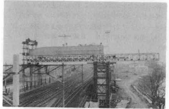
写真-5 受けた引出し完了
