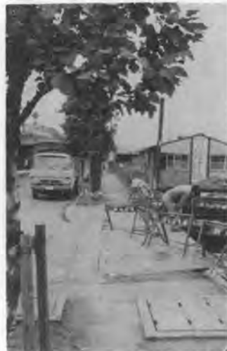
写真一四 覆工板による歩道確保
