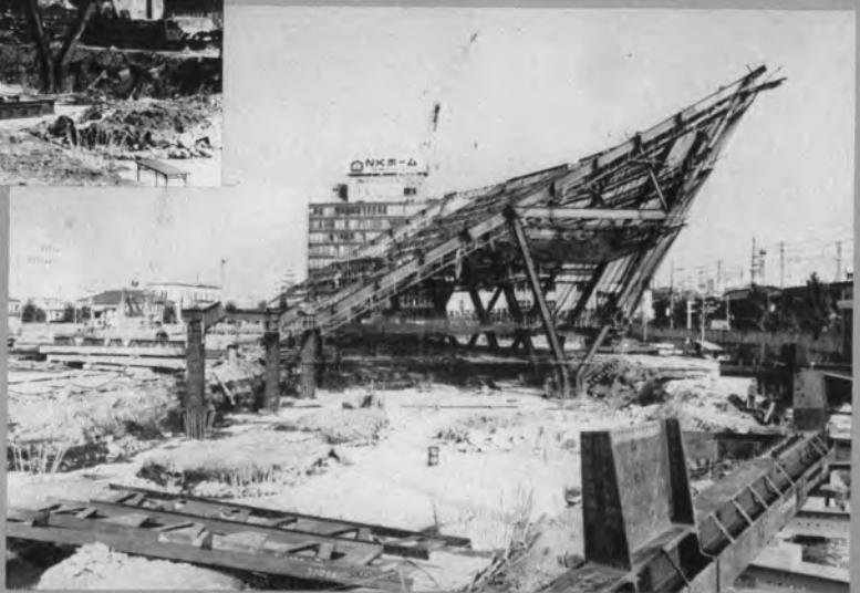
↓ 鉄骨建方工事 (2)
