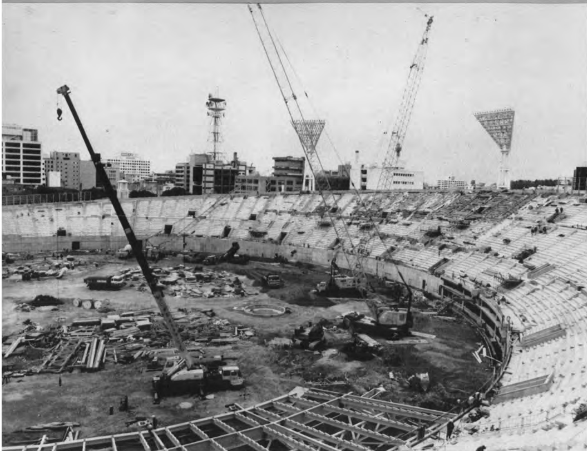
↑ 躯体工事完了直前
