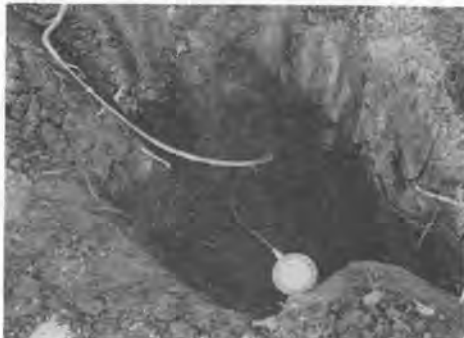
写真-8 タイヤが地中にどんな圧力を与えるかを測定する土圧計の埋込み
