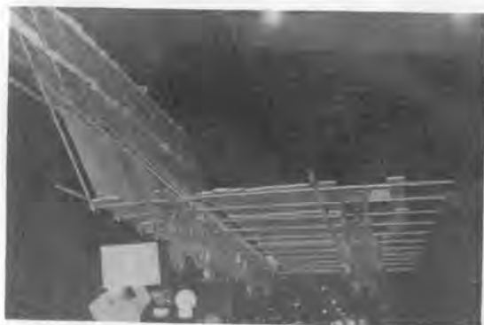
写真-3 足場の一括取りはすし状況
