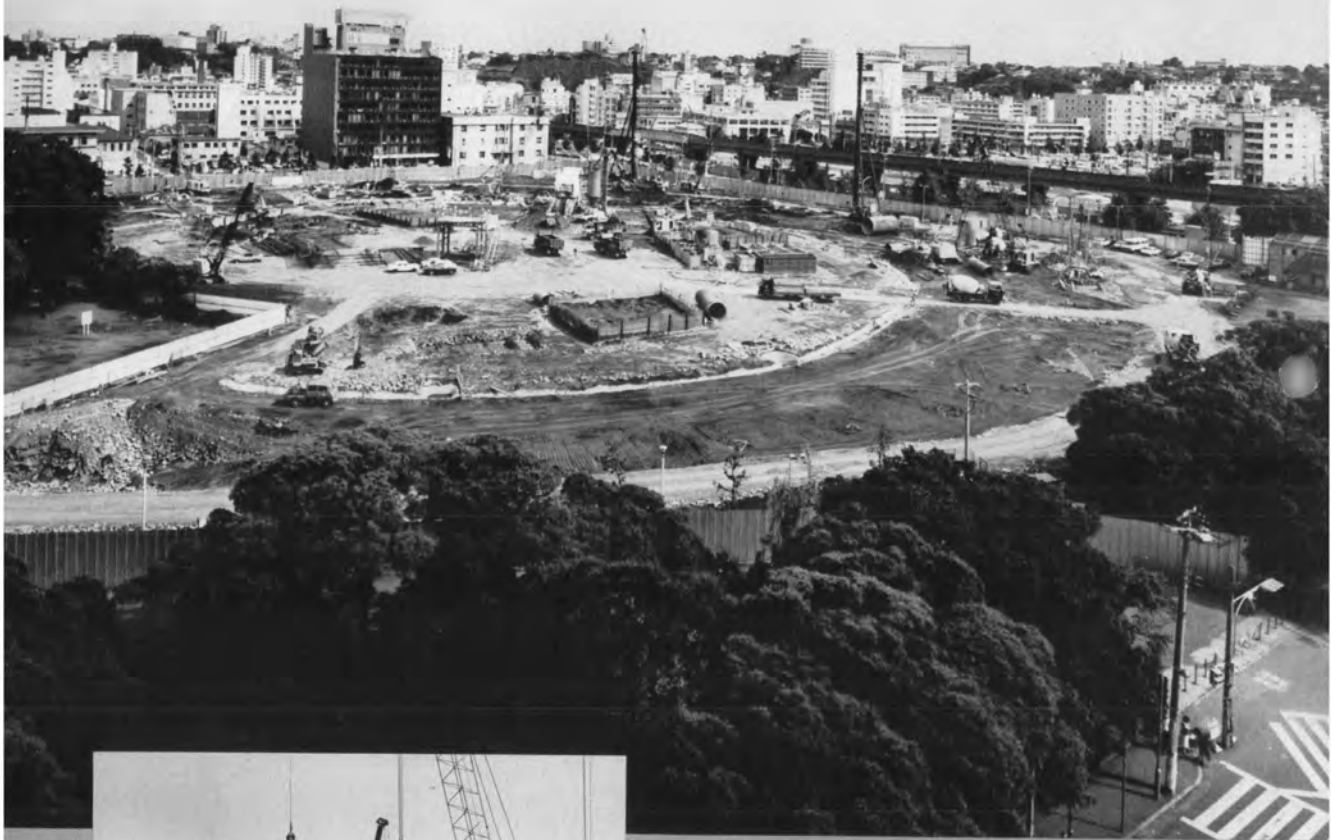
↑ くい打ち工事全景 (高いやぐらは SPIP くい打ち機)
