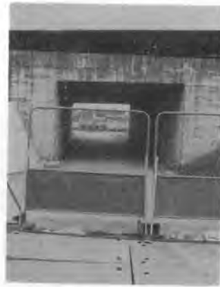
写真-3 小田原・厚木道路のカルバートボックス
