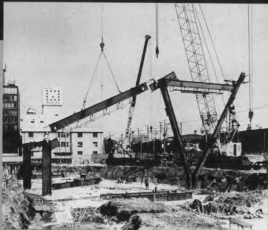
← 鉄骨建方工事 (1)
