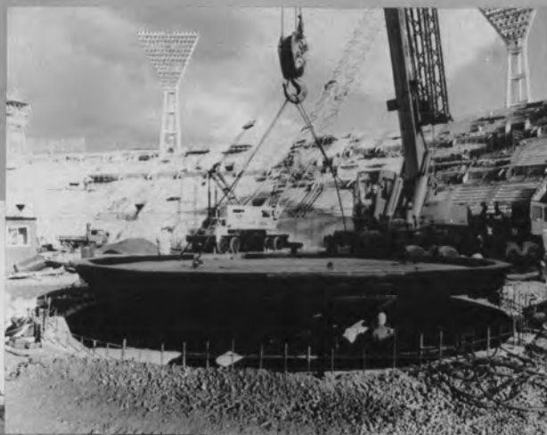
↑ ピッチャーズマウンド 本体の組み込み
