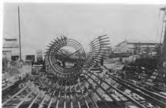
写真-2 鉄筋かご加工機
