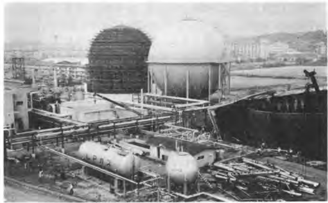
写真-3 ガスホルダー(右端)炎上の跡(仙台市)
