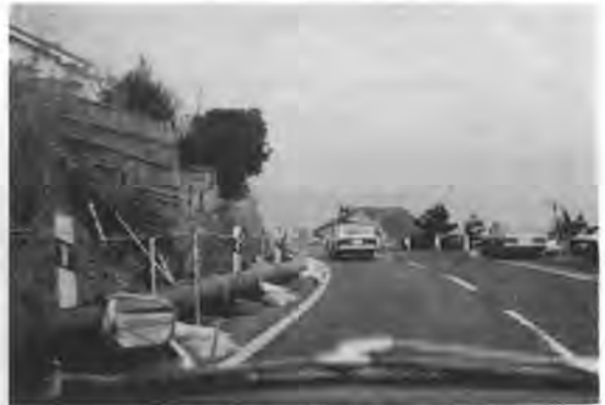
写真-2 応急給水のための地上配管（伊豆河津町）
