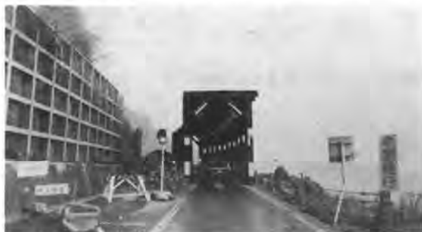
写真一 崩し除けの応急洞門工（国道 135 号線，伊豆河津町）
