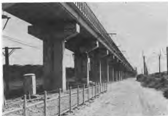
写真-4 RC ホロースラブげたと壁式ピア
