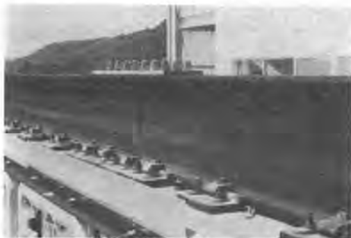
写真-3 案内路鋼体継目部
