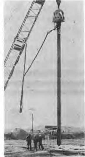
写真-2 パイロット (建設機械調査提供)
