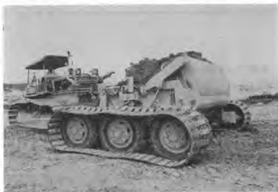
写真-5 クローバ（国土開発工業提供）
