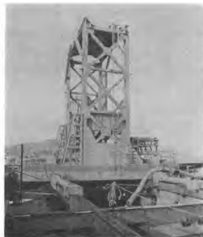
写真-4 MD 440 シャフトボーリングマシン
