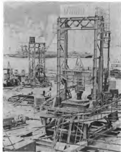
写真-3 S 500 R リバースサーキュレーションドリル
