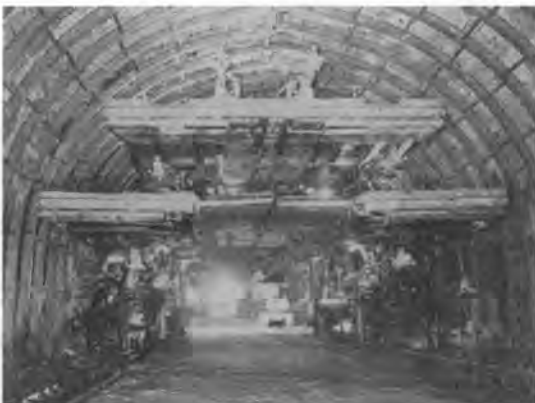
写真一1 油圧さく岩機搭載の8ブームドリルジャンボ (関越トンネル)
