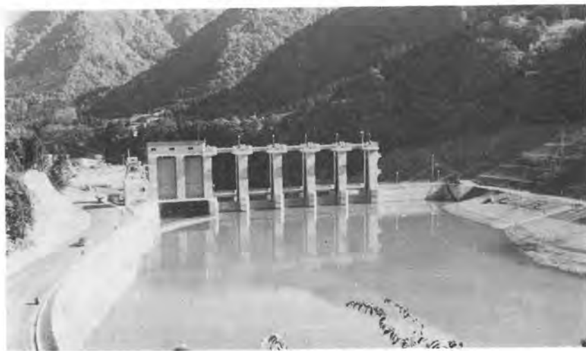
写真-1 赤尾ダム上流面
