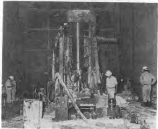
写真-2 パイロットホール掘進中の BM-100 N のドリルユニット
