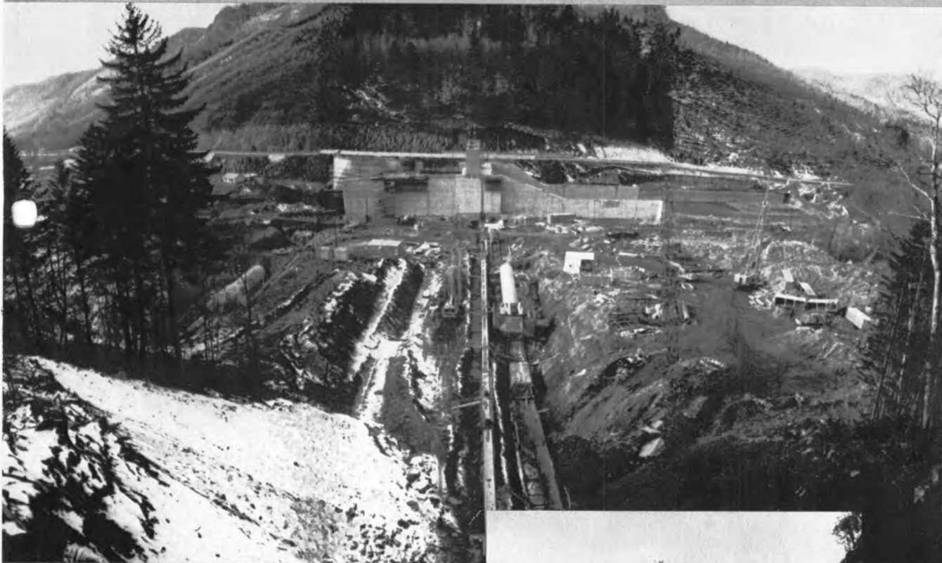
↑ 武利ダム全景（右岸より望む）
