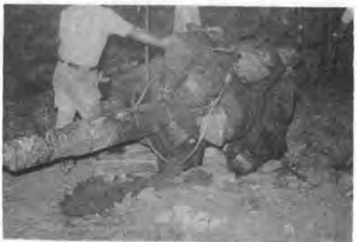
写真-3 リーミングビットの交換作業(φ1,450 mm, ローラカッタ 12 個)
