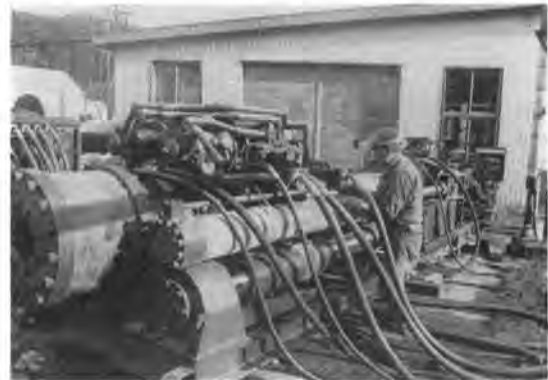
写真-4 長尺ボーリングマシン (青函トンネル)
