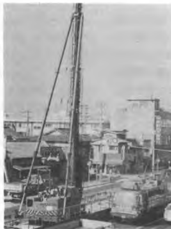
写真-3 共同溝工事
