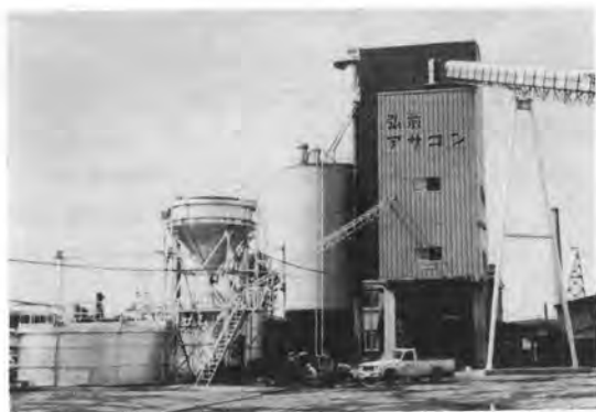
写真-1 生コンプラントと廃水処理設備
