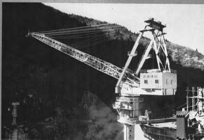
↑コンクリート打設用タワークレーン 同タワークレーン基礎➡
