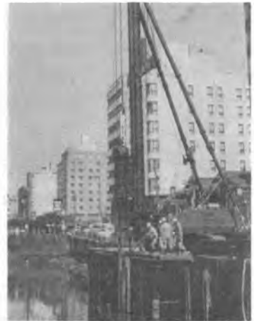
写真-4 立坑工事
