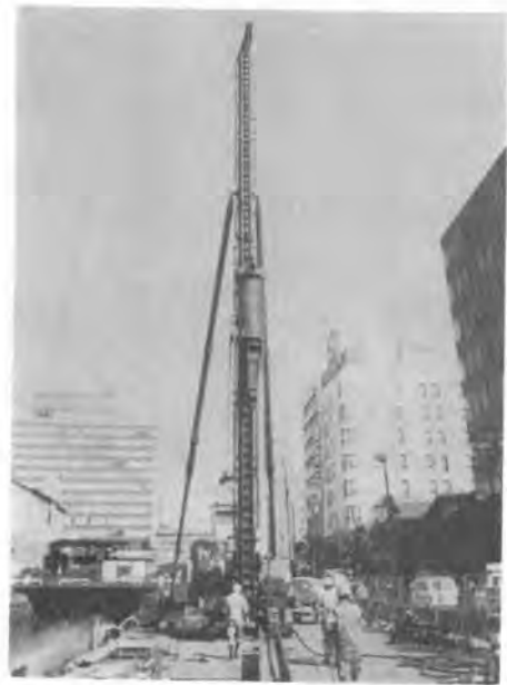
写真一 DJP 式くい打ち機
