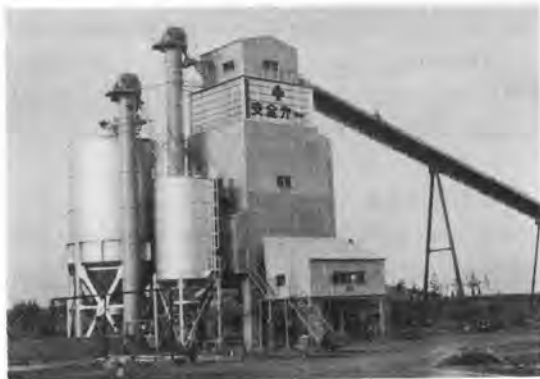
写真-2 操作室が独立したプラント
