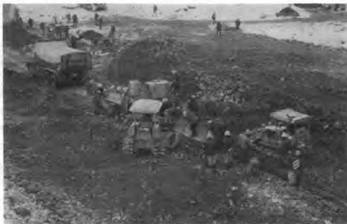
写真-3 トランジションの施工
