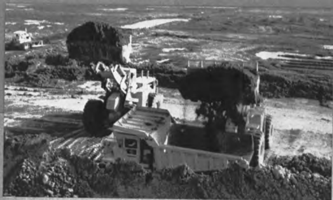
ホイールロードによるダンプへの積み込み➡
