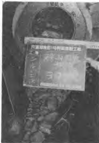
写真-2 トロンメルよりのれき取り状況
