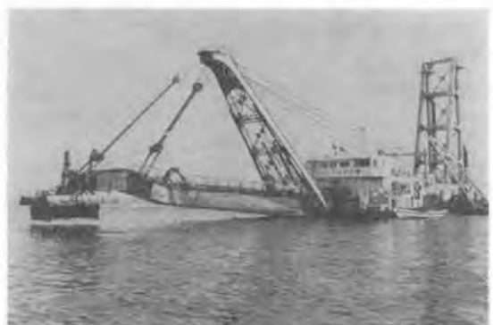
写真-10 ヘドロ浚渫船「クリーンナップ2号」
