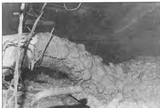
▲アーチ・コンクリート打設中
