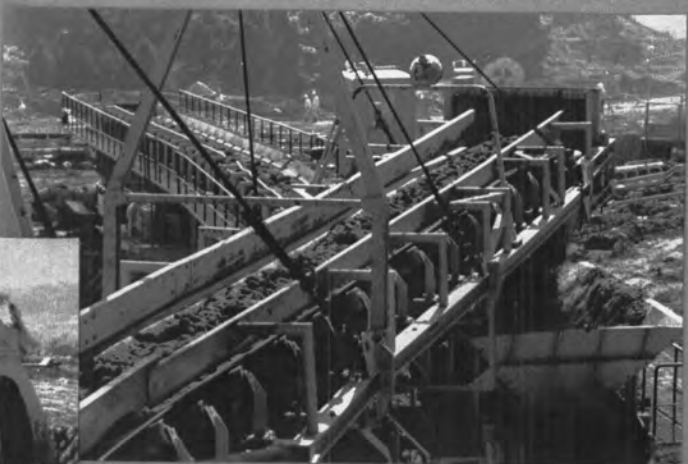
掘削された土砂は トランスファーワゴンへ導かれる →
