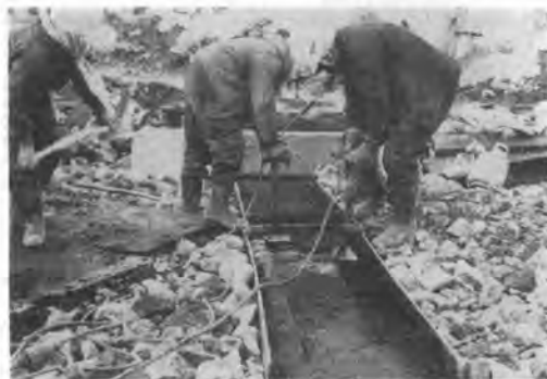
写真-2 端部の人力施工
