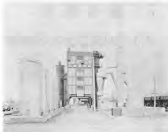
写真-1 大容量ホットビンのアスファルトプラント
