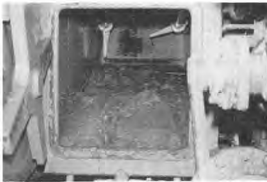
写真-1 れき取りチャンバ内の状況
