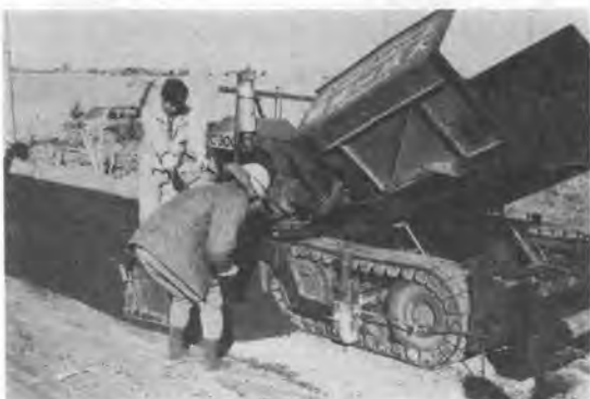
写真-4 C-300型アスファルトフィニッシャー
