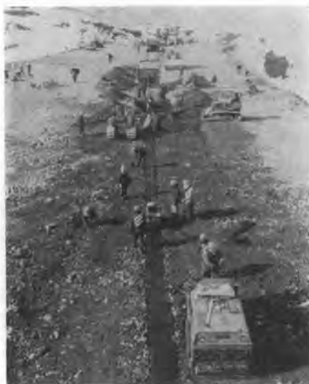
写真-1 アスファルトコア舗設作業
