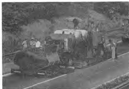
写真—5 舗装版再生施工機械 (西ドイツ・ウィルトゲン社)
