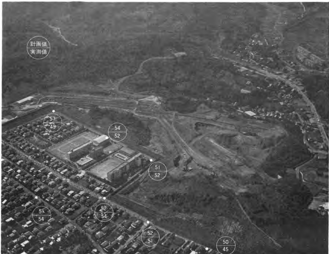
写真-1 工事中の騒音値
