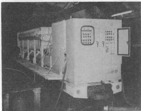
写真—1 坑内移動式泥水処理装置
