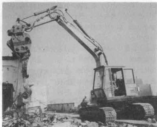
写真-10 日本ニューマチック S-10 油圧式圧砕機
