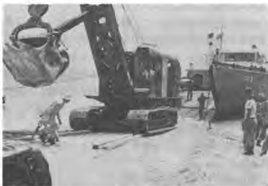
上陸用舟艇から荷揚げしたパワーショベル(本部)
