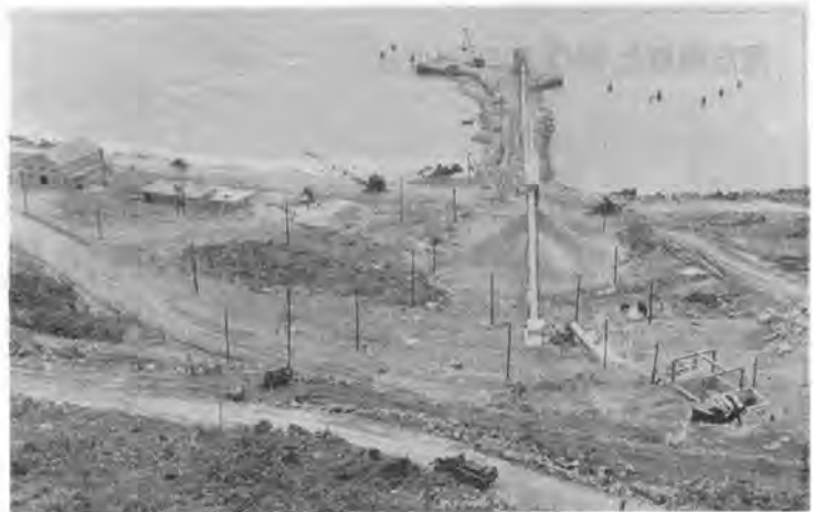
本部突堤 (手前右は第 1 クラッシャ、左端の建物は発電所)
