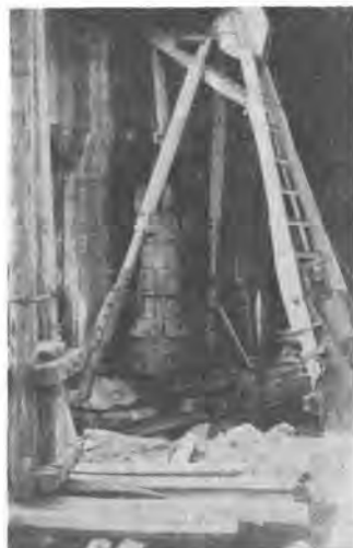
写真-2 大阪駅高架橋アンダーピンニング工事のベントNo.6改造機(昭和33年11月)
