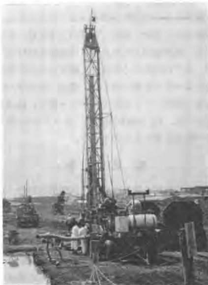
写真-3 我が国最初のリバース掘削 (昭和38年4月、品川駅構内)
