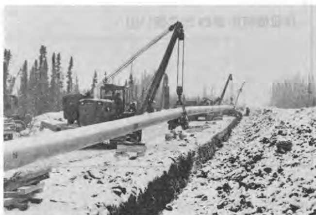
パイプライン敷設工事で稼働中のD155Cパイプレーヤ
