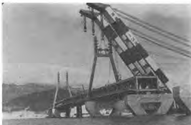
写真-2 ケーブルタワー (630 t) の架設
