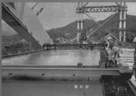
ゴマコ社製コンクリートフィニッシャによる 床版コンクリート（軽量コンクリート）の打設
