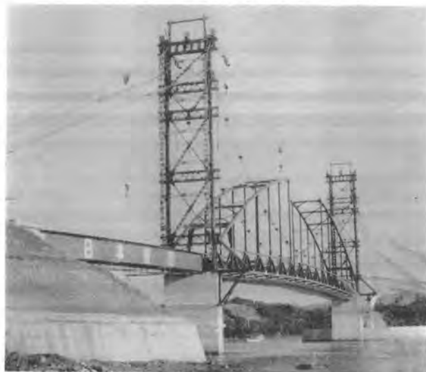
写真-14 大矢野橋の架設
