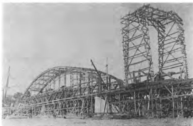
写真-2 那珂川大橋の架設
