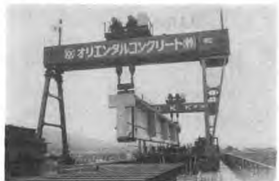
写真-1 門型架設機による桁のつり込み
