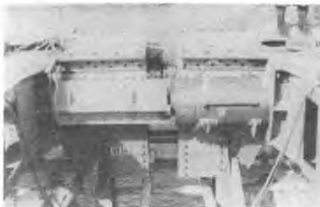
写真-8 (2) 西海橋のアーチ閉合に用いたジャッキ
