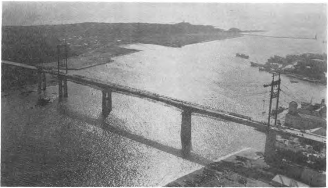
写真-10 城ヶ島橋の架設
