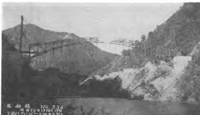
写真-5(1) 尾鈴橋のケーブル式斜つり架設
