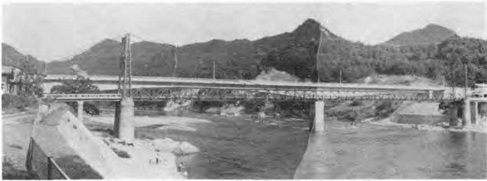
写真-7 鹿ノ瀬橋
