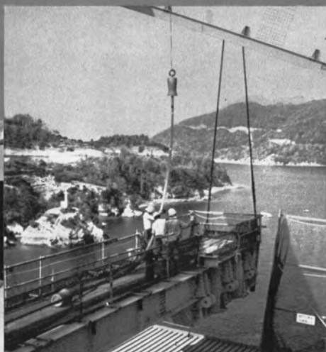
つり材の架設 (仮設備架台上の作業) ⇨ ウタイの閉合 (昭53.10)
