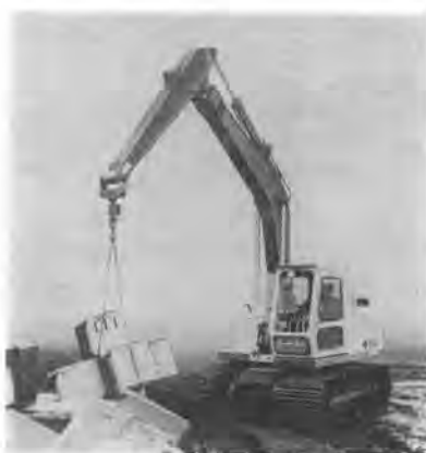
写真-5 住友 S-40 油圧クレーン
