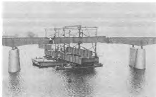
写真-3 江川橋のポンツーン架設
