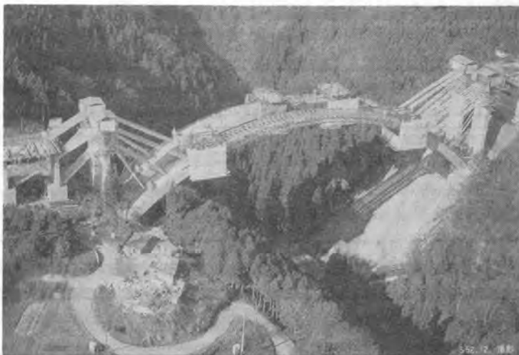
写真-4 帝積橋の架設状況
