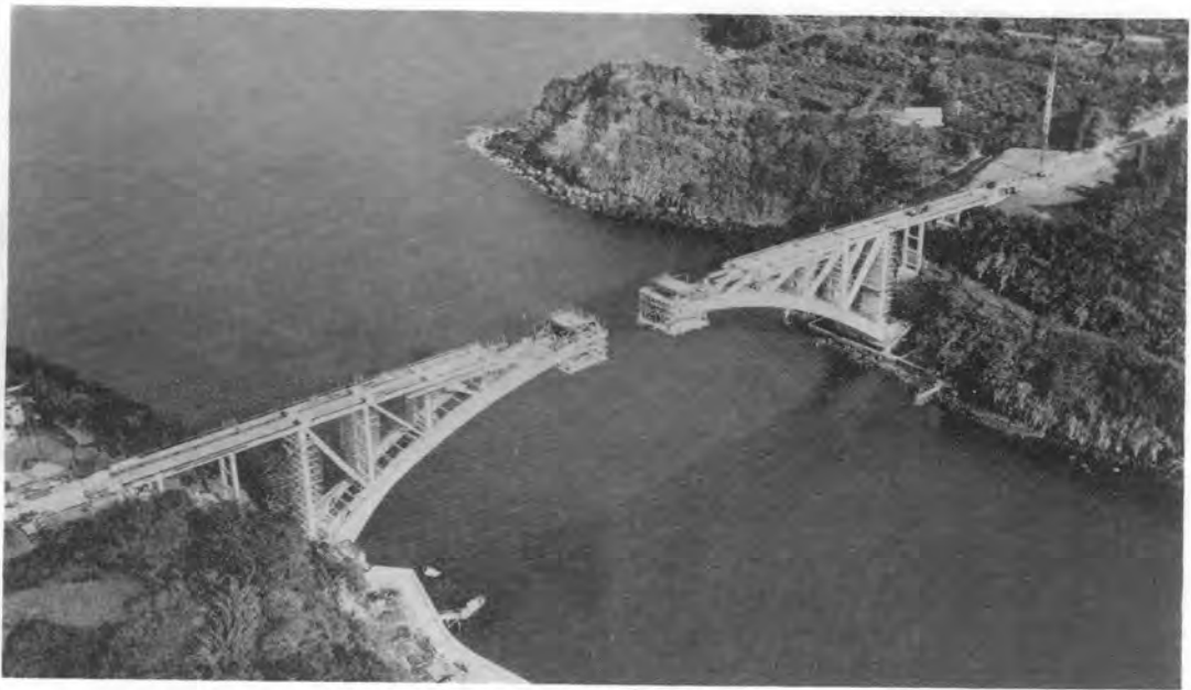
写真-3 外津橋の架設状況
