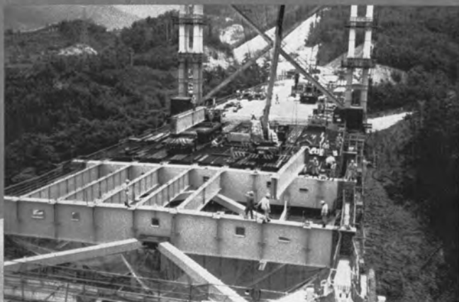
側タイ部の架設 側タイ完成状況とアーチリブの塗装
