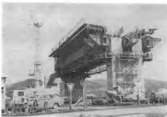
写真-1 可動支保工（ストラバーク工法）
