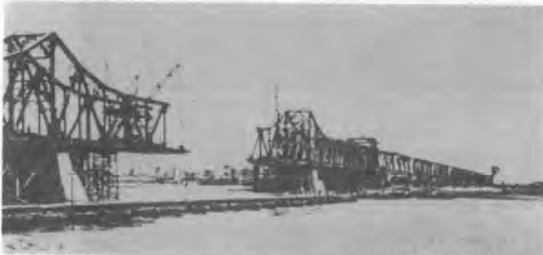
写真-1 黄河鉄道橋の架設
