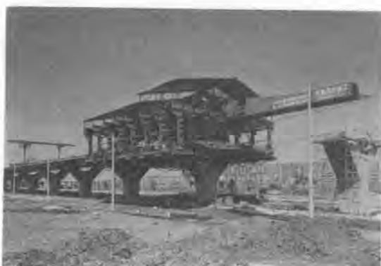
写真-2 移動つり支保工（ゲリュストワーゲン工法）
