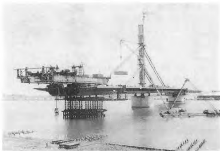
写真-18 水郷大橋の架設
