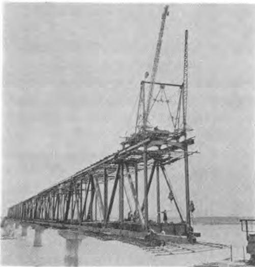
写真-11 最上川橋梁のトラスの片持式架設
