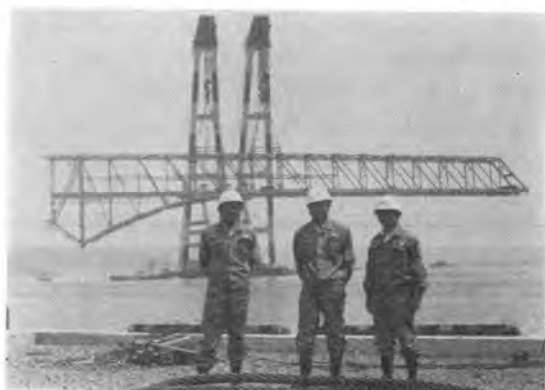
写真-17 大島大橋のトラスつり運搬
