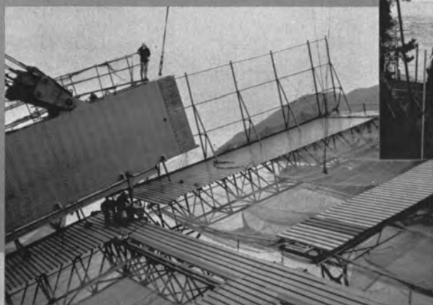
アーチリブ第1ブロックの組立(昭52.12) ⇨ ⇨ 移動防護工(伯方島側)の組立(昭53.2)
