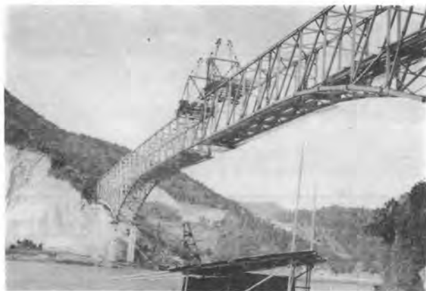
写真-13 天門橋の片持式架設
