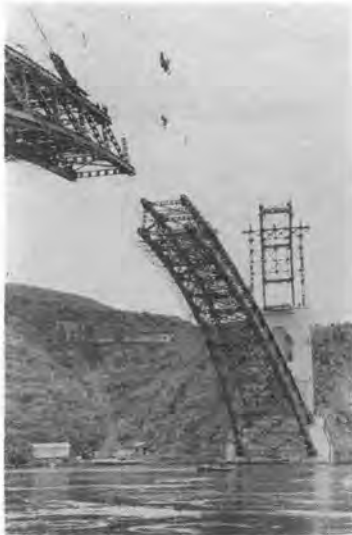
写真-8 (1) 西海橋の架設
