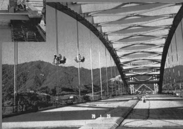
ゴマコ社製コンクリートフィニッシャによる 床版コンクリート（軽量コンクリート）の打設
