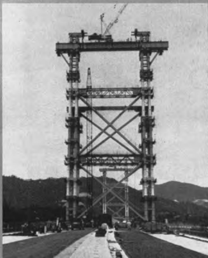
⇨ 仮設備・ケーブルクレーン鉄塔と斜り鉄塔の建方(昭52.8)
