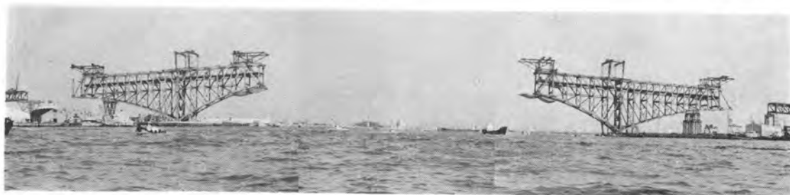
写真-16 港大橋のバランスカンチレバー架設
