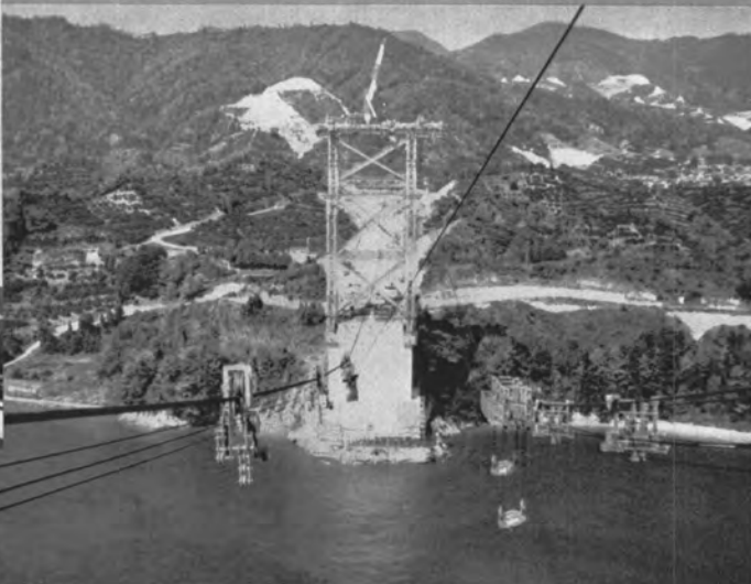
⇨ ケーブルクレーンの組立 右は15tづり、左は45tづり(昭52.9)
