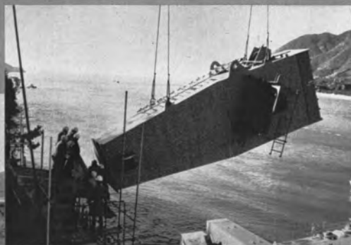
アーチリブ第1ブロックの組立(昭52.12) ⇨ ⇨ 移動防護工(伯方島側)の組立(昭53.2)
