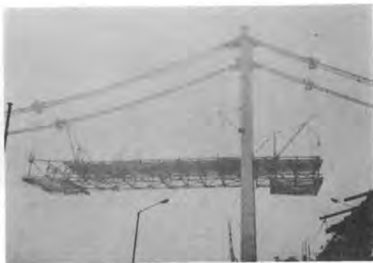
写真-15 関門橋の補剛トラスの架設
