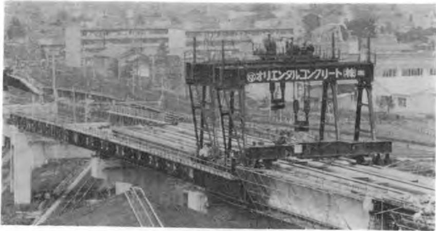
写真-2 ガーダ全体の送出し
