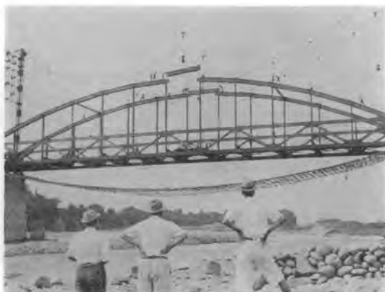
写真-6 群馬大橋のケーブル式直つり架設
