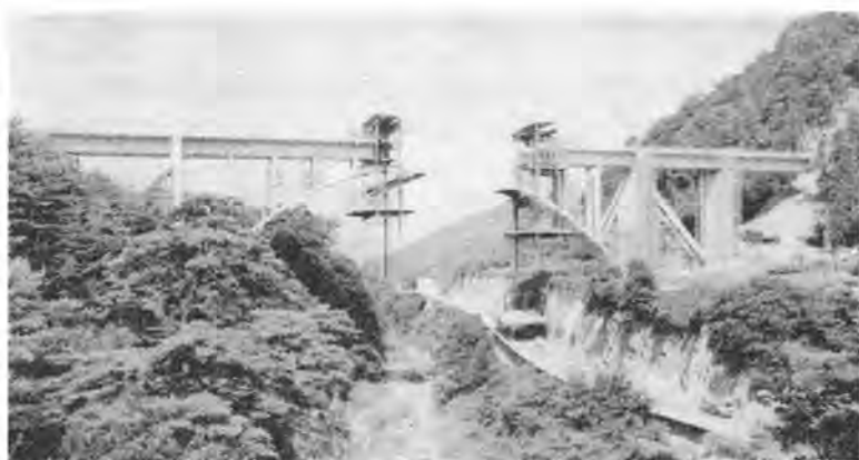
写真-5 赤谷川橋梁の架設状況
