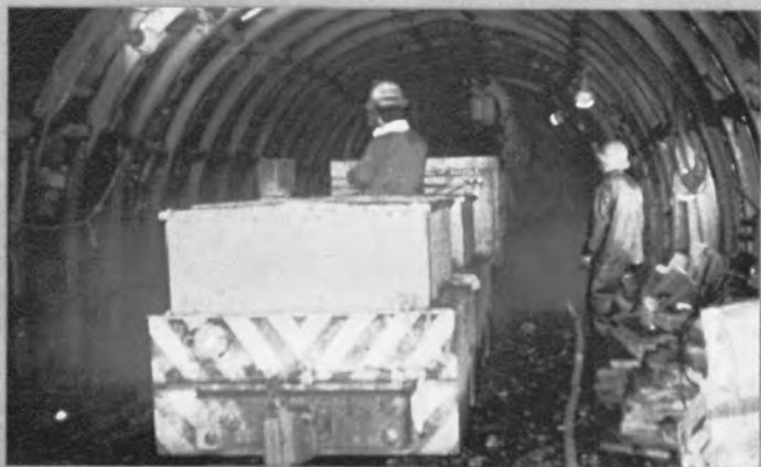
⇨導坑掘削後のロッカーショベルによるずり積込作業状況
