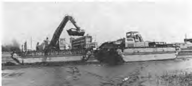
写真-1 河床清掃機（左は掘削機，右は運搬機）
