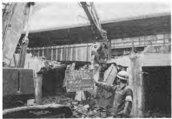
写真-3 擁壁の取り壊し
