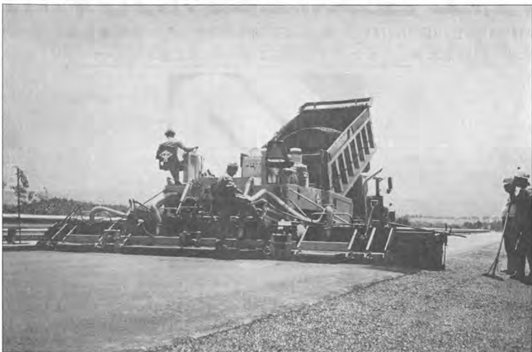
PF-500型(ゴム・パット付クローラ方式)最大舗装幅8.23m
