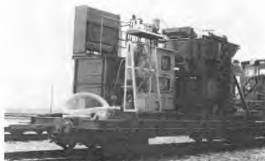
写真-1 CA モルタル注入車汚水処理装置
