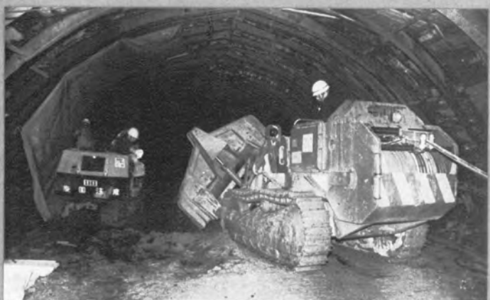
⇨上半ずり出し両サイドダンプ式ショベルによりホッパ口への投入状況
