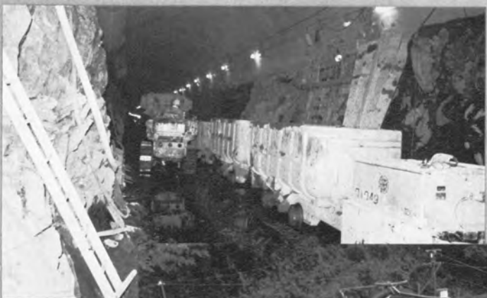
⇨土平掘削におけるずり積込作業状況
