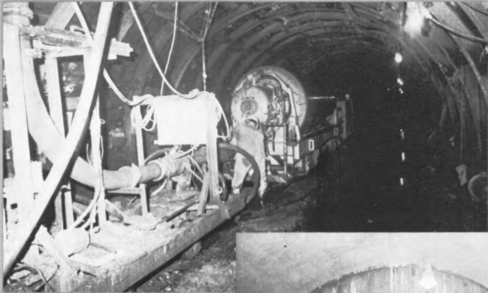
⇨ スクリュークリートによる アーチコンクリートの打設
