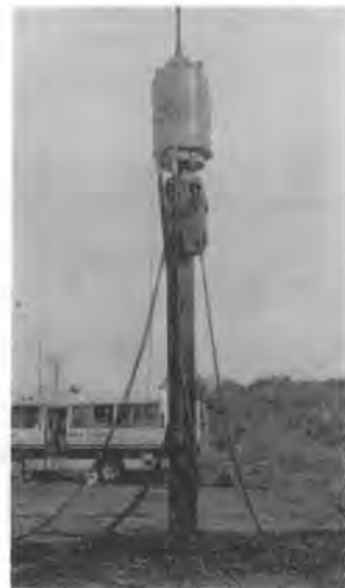
写真-8 超高周波振動杭打(実験)機
