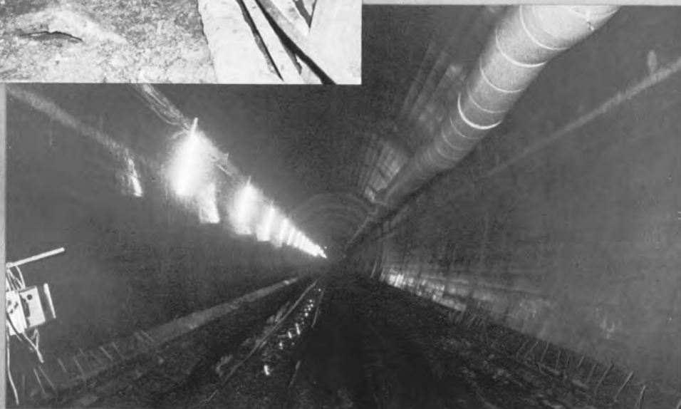
♡本坑アーチ側壁部のライニング状況
