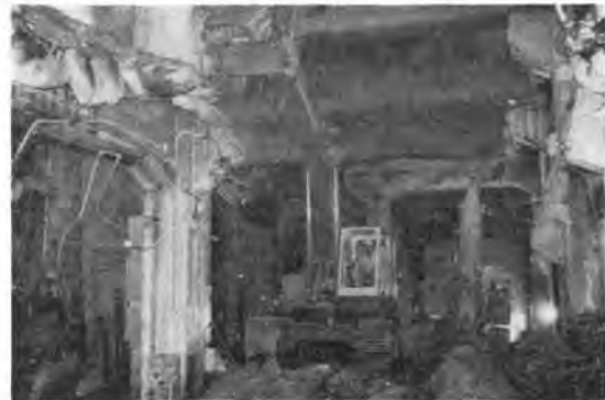
写真-4 旧道路橋の取り壊し
