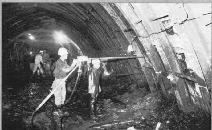
⇨蛇紋岩が出現した第1工区のロック ボルトによる補強作業
