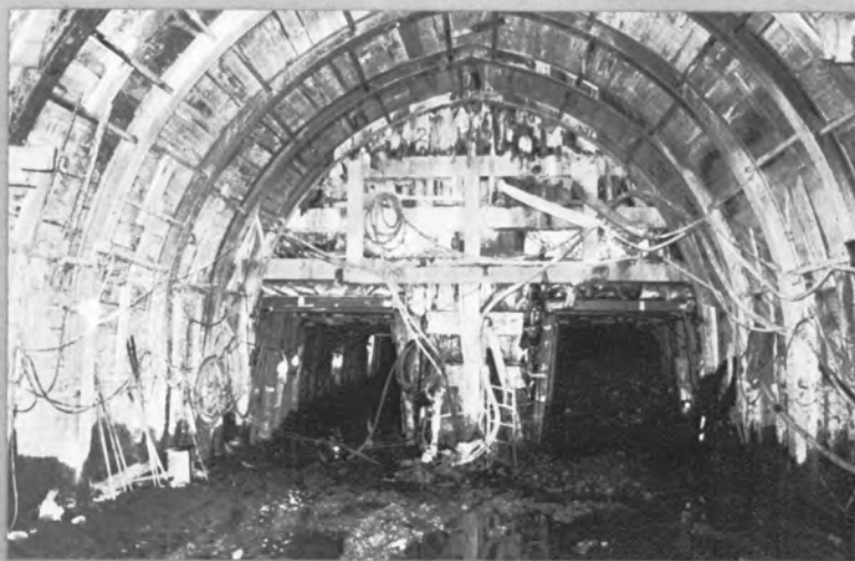
◆第2斜坑坑口より210m付近の神原谷断層部の特に悪質区間はサイロット掘削により施工した
