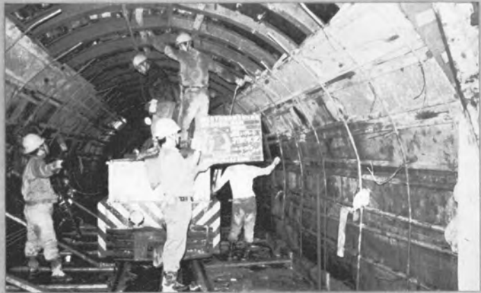
破碎帯部における導坑仮巻プロテク タコンクリートの打設準備 ⇨
