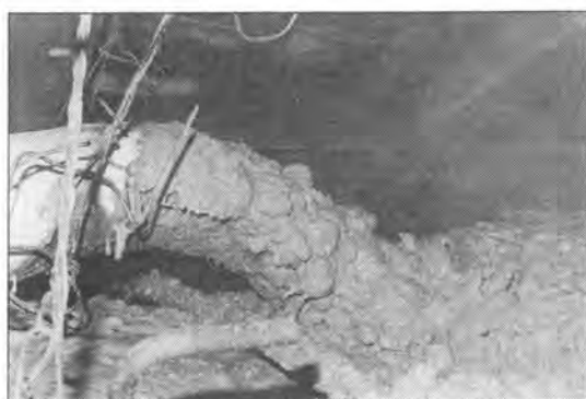
▲アーチ・コンクリート打設中
