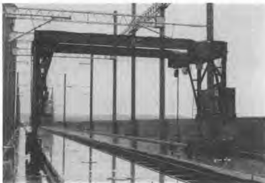
写真-1 門型クレーン
