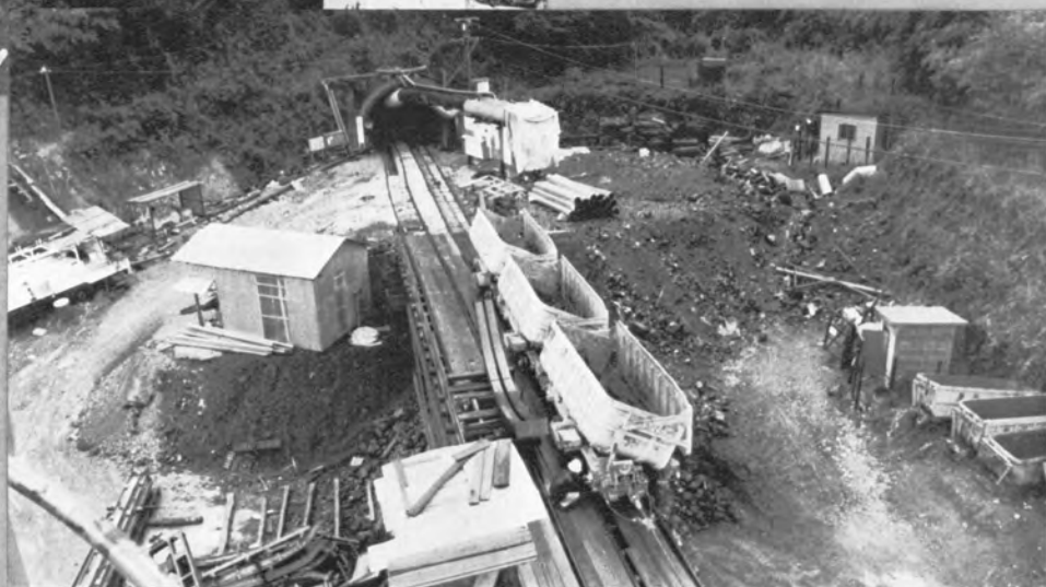
⇨第3斜坑口より斜坑専用鋼車によるずり出し状況
