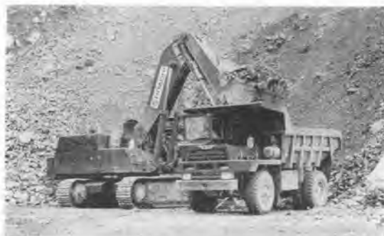
写真-2 砕石場で稼働中の UH 20
