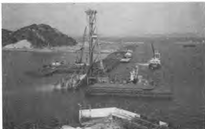
写真-3 鋼管杭打設状況
