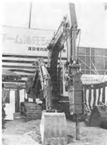
写真-4 2ブーム油圧ショベル
