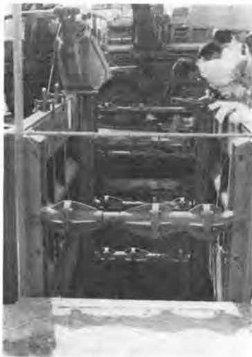
写真-7 簡易土留工法
