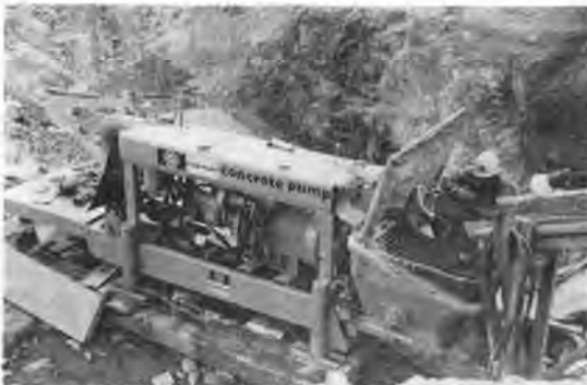
写真-33 コンクリートポンプ・ブツマイスタ
