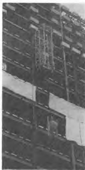
写真-35 高層用低スランプ コンクリート揚重機
