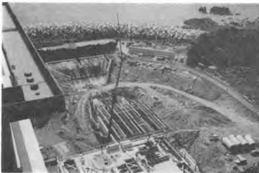
写真-2 取水路工事状況
