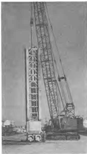
写真-13 ハイドロフリーズ掘削機
