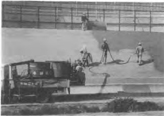
写真-40 高粘性材料散布機
