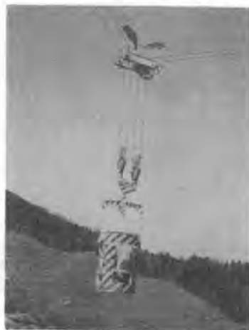
写真-5 H型クレーン・ローディングブロック部
