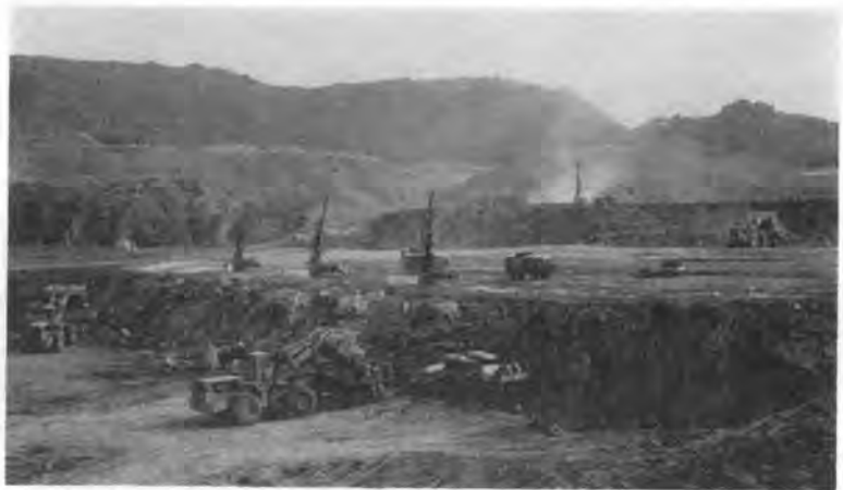
写真-1 貯炭場掘削状況
