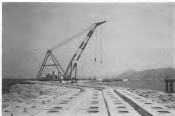
写真-4 ケーソン据付状況
