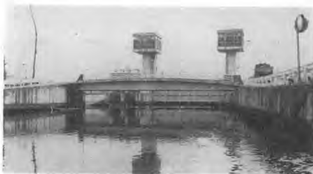
写真-3 完成した大場川水門および伏越し
