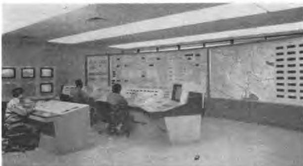
写真-9 完成した操作室
