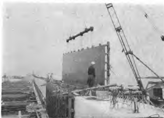
写真-4 大パネルによる型枠組立状況
