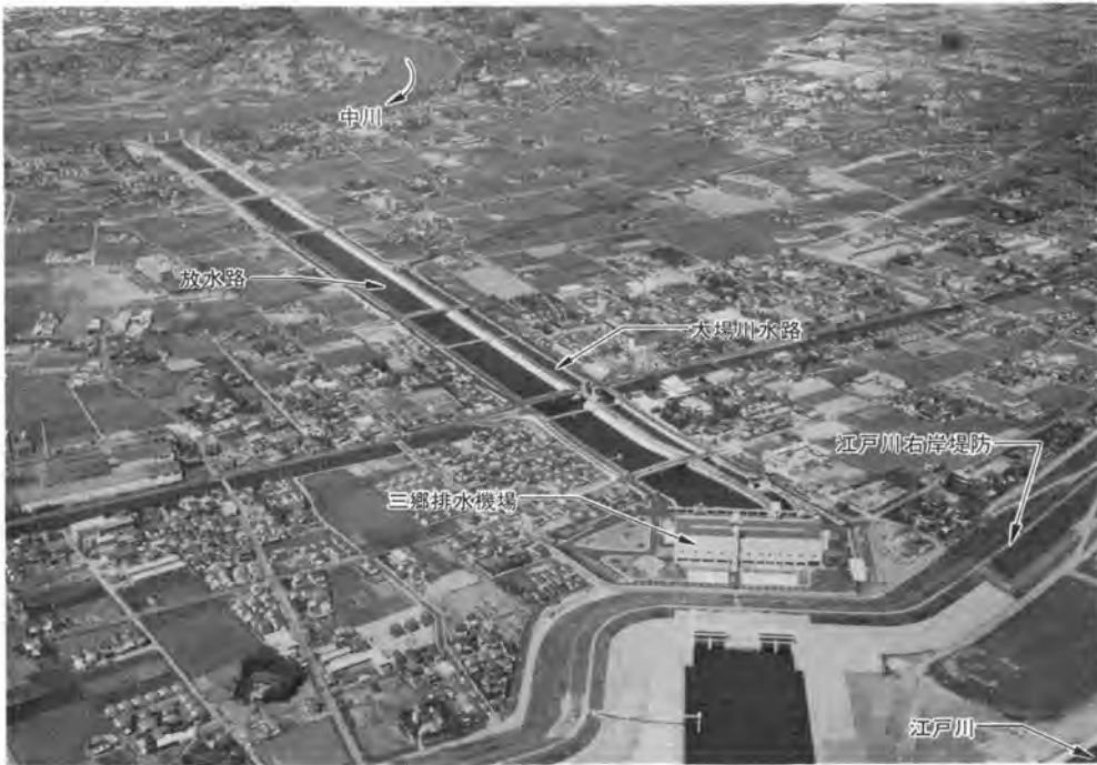
写真-1 完成した放水路
