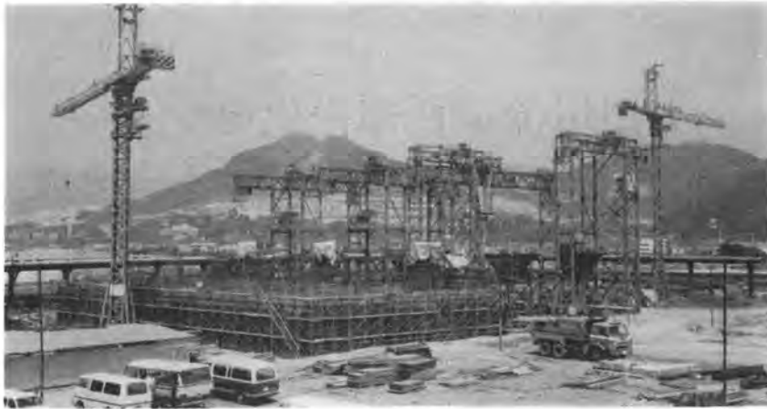
写真-1 工事施工状況
