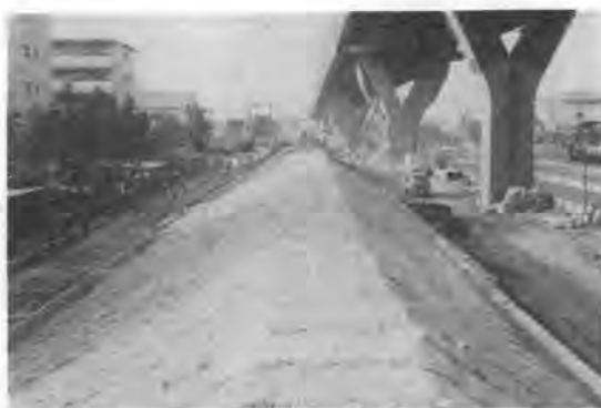
写真-4 完成した築山
