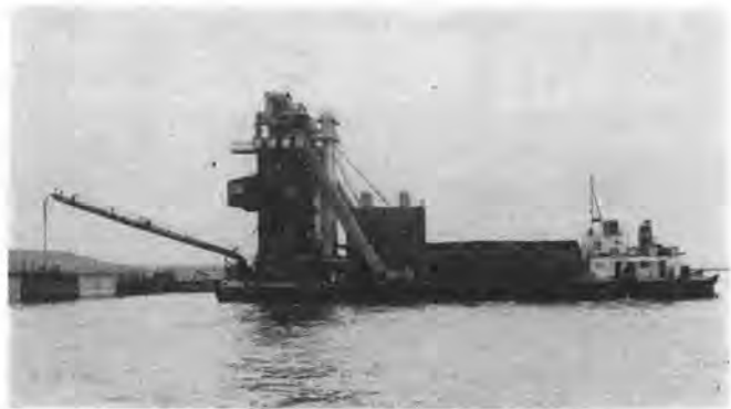
写真-5 ミキサ船によるコンクリートの打設
