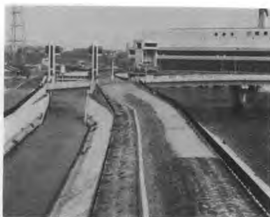
写真-6 完成した大場川水路 (左側が大場川水路、右側が放水路)
