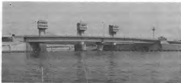
写真-2 完成した三郷水門（手前は境木橋）
