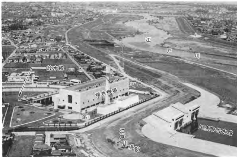
写真-7 完成した排水機場
