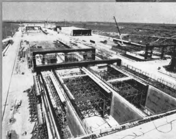
◆ドライドックでの移動式型枠による函体製作
