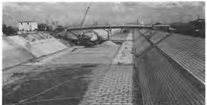
写真-4 施工中の放水路
