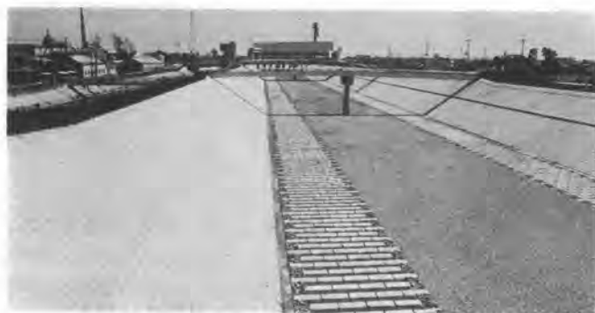
写真-5 完成したブロック張および根固め
