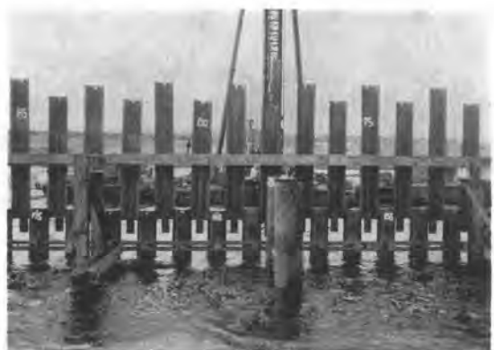
写真-7 落し矢板引上げ状況
