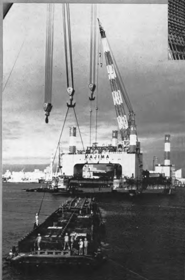
◆SEP "KAJIMA" に引込中の沈埋函
