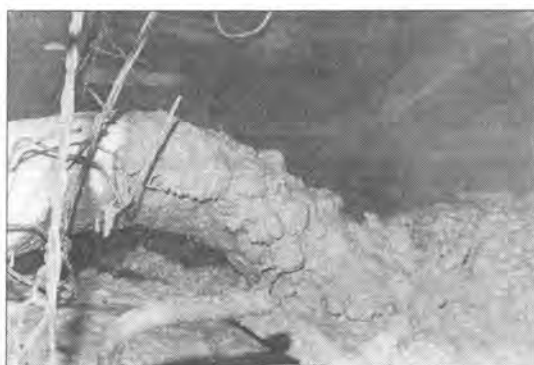
▲アーチ・コンクリート打設中
