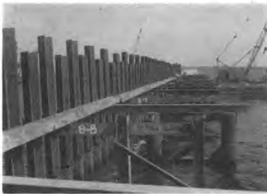
写真-6 縮切鋼管矢板用専材
