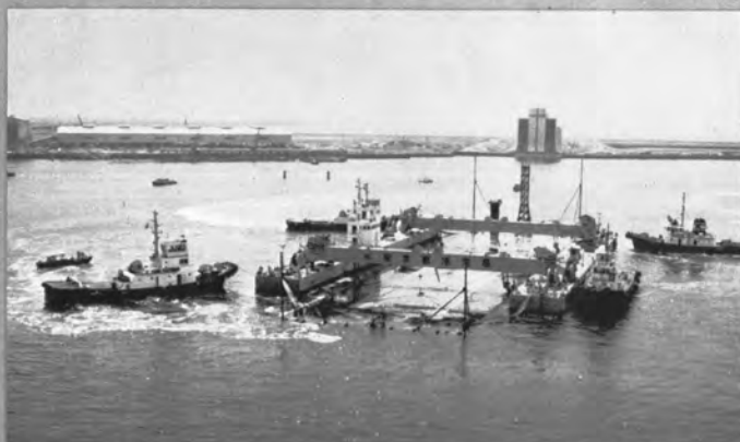
◆沈設現場でプレッシングバージ係留直前
