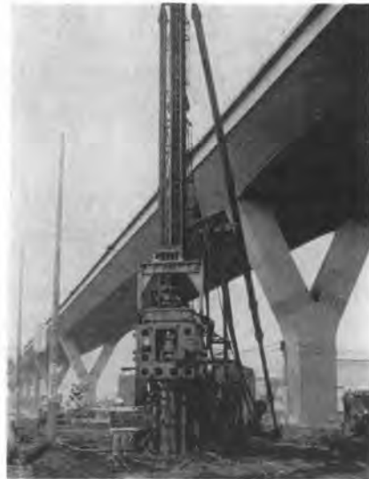
写真-2 打設機本体
