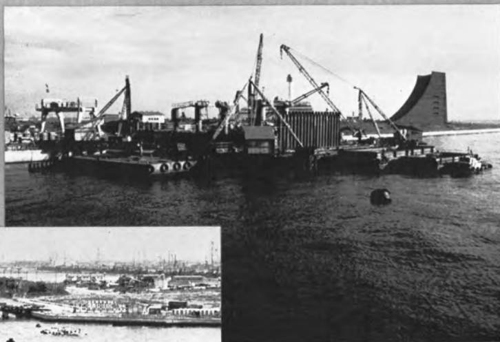
⇨ 13号地立坑の構築作業
