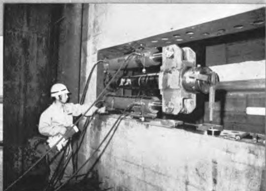
◆引寄せジャッキ設置完了
