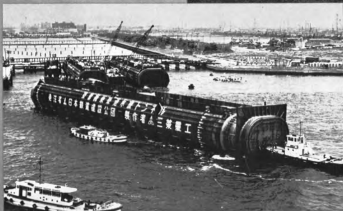
⇨ 艀装ヤードへ曳航中の沈埋函
