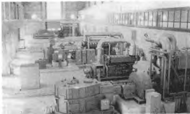
写真-8 完成したポンプ室
