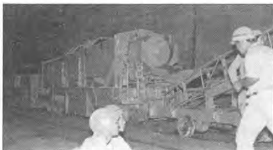
▲アジテーターカー青函トンネル稼動中6m 3 2輪連結
