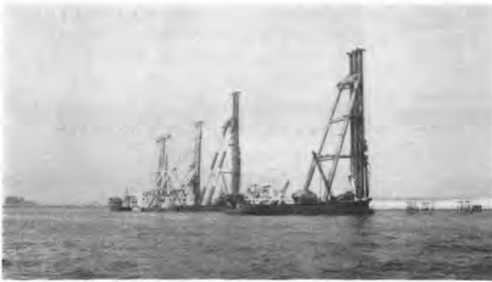
写真-2 締めめ砂杭打込船
