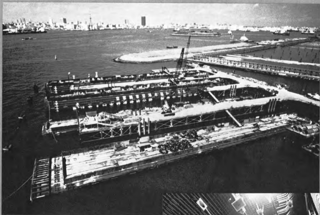
◆沈埋函の機装ヤード
