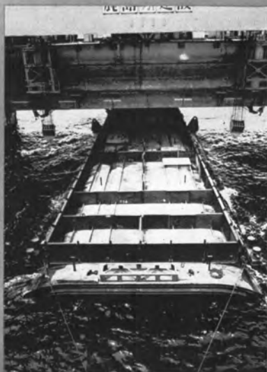
◆沈埋函の載荷枠と止水ガケット
