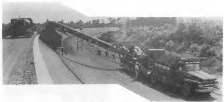
写真—3 高速周回路曲線部のアスファルト舗装の施工状況
