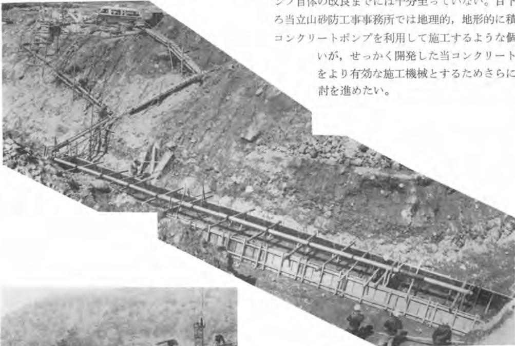
↑ 写真-2 配管状況（ゆるい下り配管）
