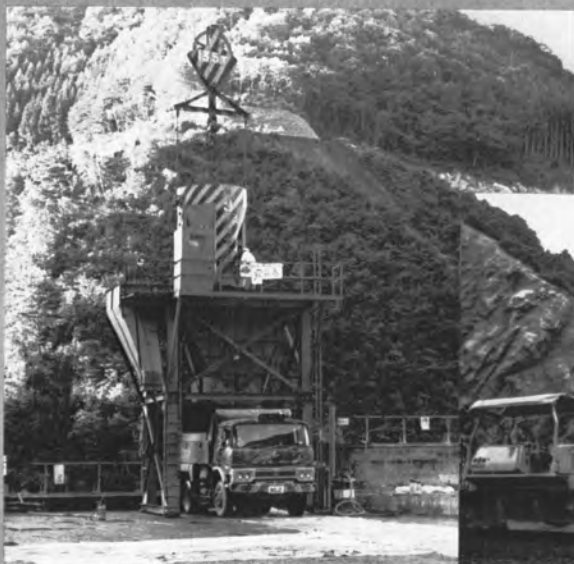
◆ グランドホッパーと 受材中のダンプトラック
