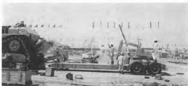
写真—4 A分解のブルドーザの荷台フレーム上への進入
