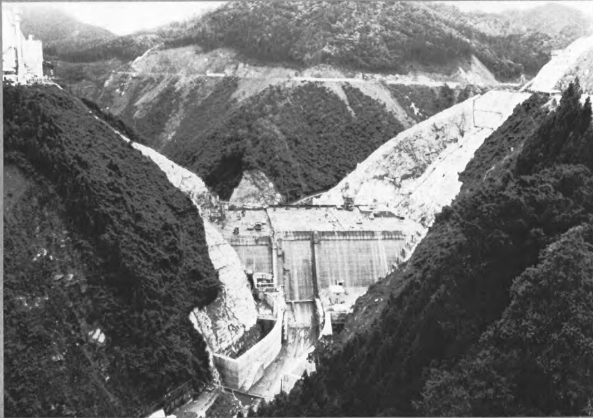
⇨下流側より見たダムサイト
