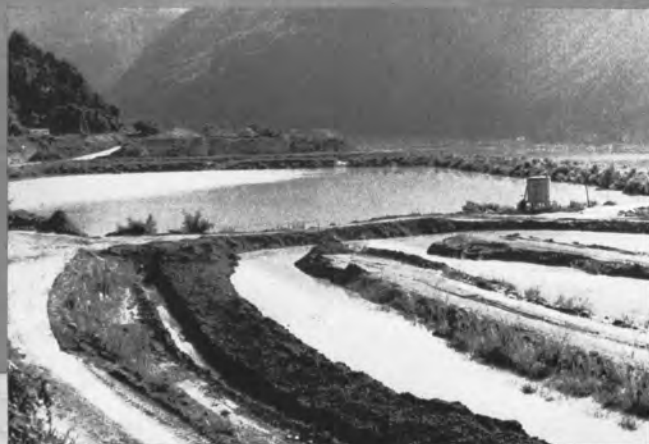
④沈殿池（手前が第1，後方が第2沈殿池）
