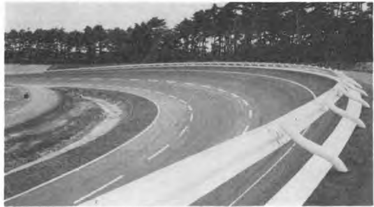
写真-5 完成した高速周回路曲線部の一例
