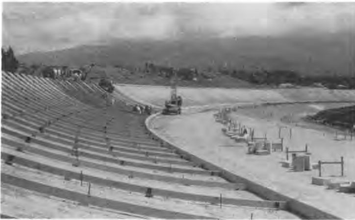
写真-1 高速周回路曲線部のセメント安定処理の従来施工法
