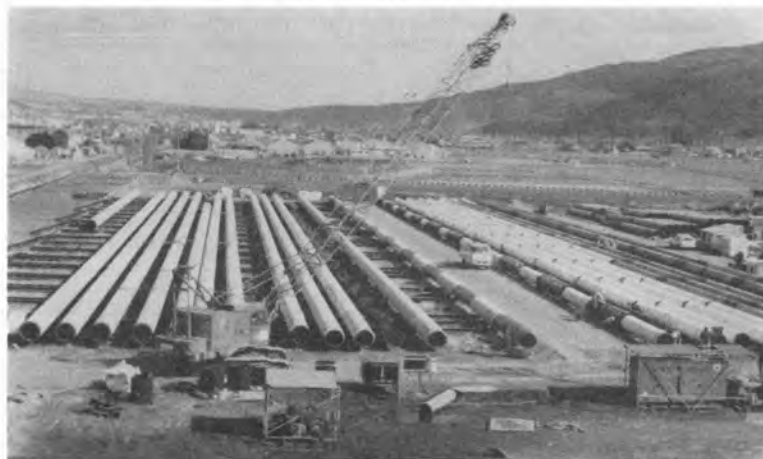
写真-1 長管製作ヤード
