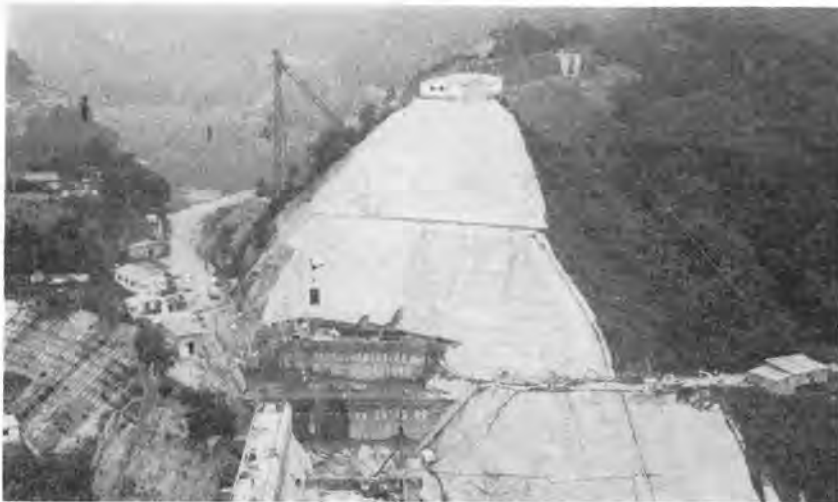
写真-2 ケーブルクレーンによるコンクリートの打設
