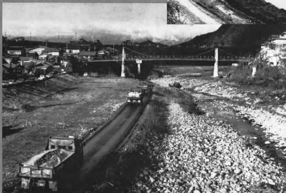
④製品搬出用の三峰川河川道路
