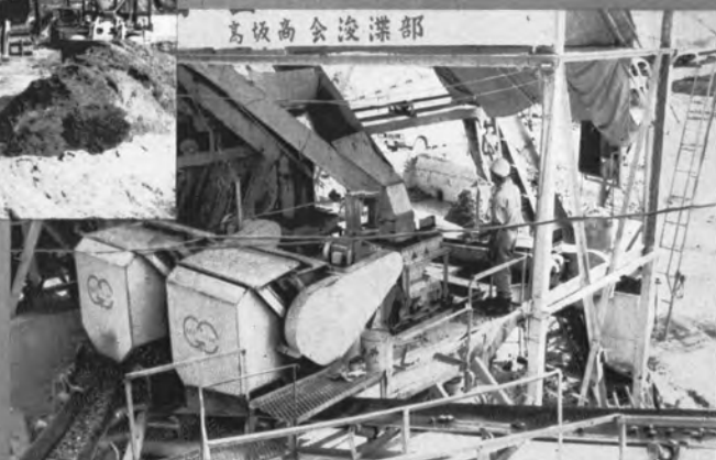
④5台のトロンメルを導入したプラント全景
