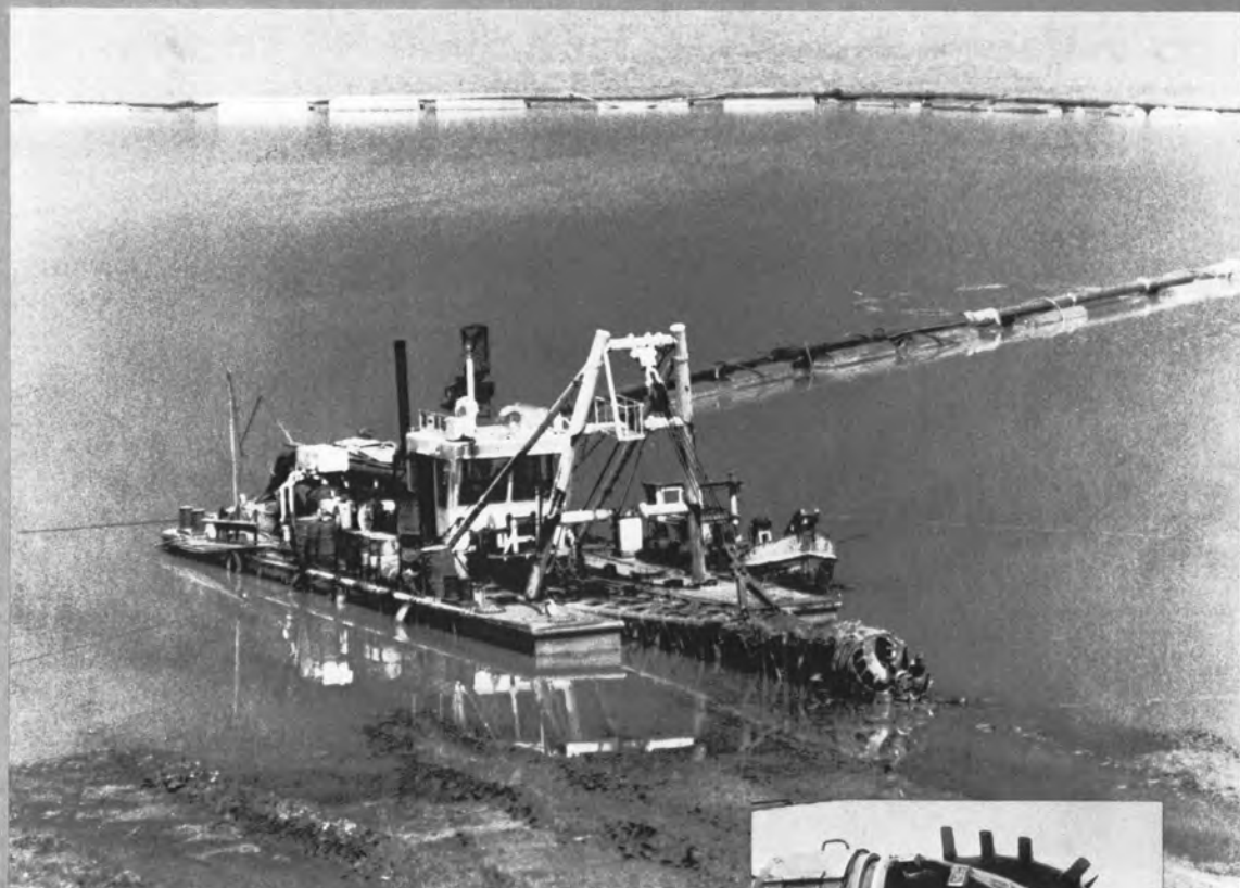
④ポンプ浚渫船
