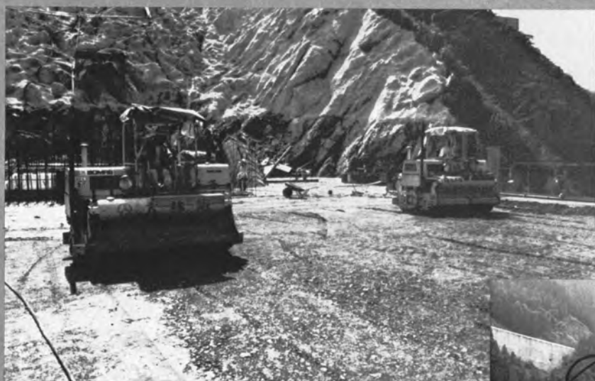
◆ 振動ローラによる締固め
