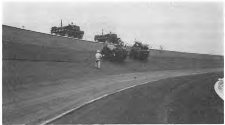
写真-4 高速周回路曲線部のアスファルト舗装転圧状況
