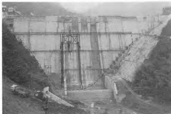
写真-1 川上ダムのかさ上げ（点線は旧ダム堤体）
