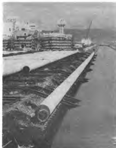
写真-3 長管の進水
