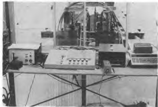
写真-5 指令室制御盤
