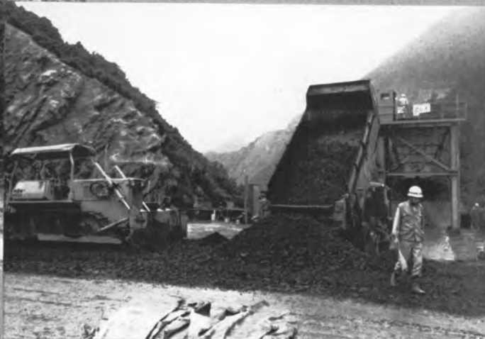
◆ ダンピングおよび敷均し
