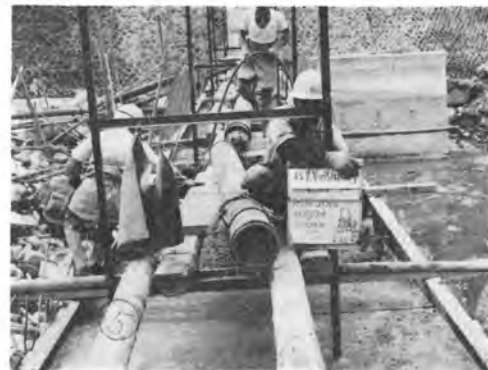
写真-4 コンクリートポンプによる打設状況
