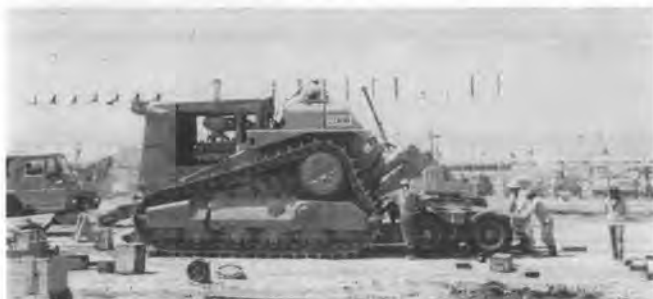
写真—5 A分解のブルドーザの荷台フレーム進入完了
