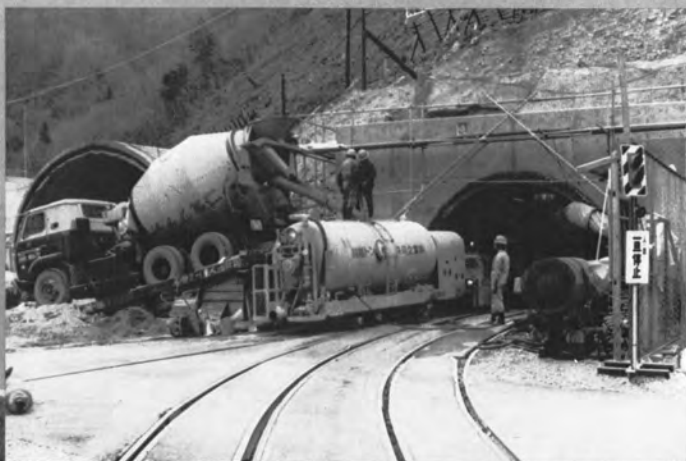
⇨トラックミキサからスク リュークリートへのコン クリート積替え (補助坑)
