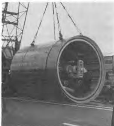
写真-1 ID 3,000×t 250 HP 泥水加圧式セミシールド機
