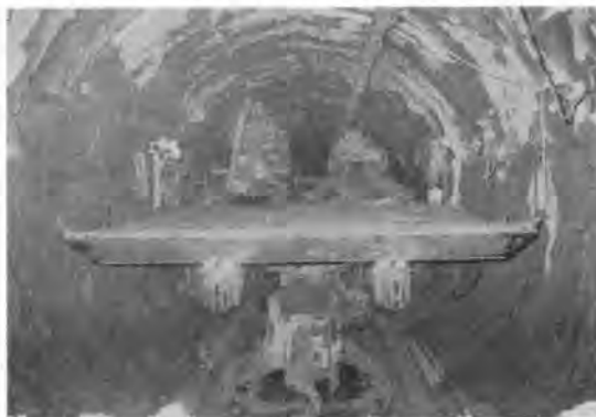
写真-1 掘削架台前部
