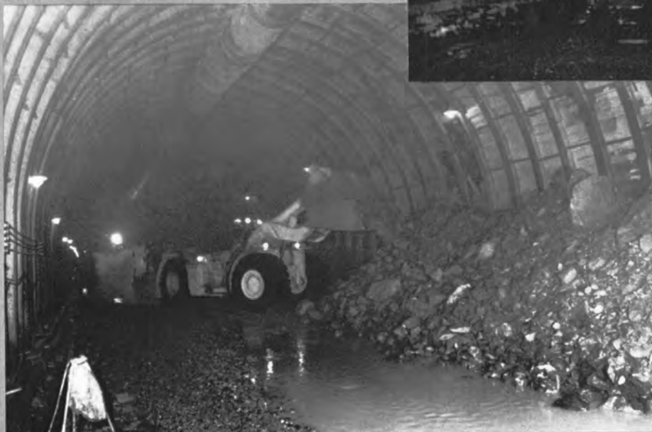
ロードホールダンプによる切羽後方120mへの仮置き
