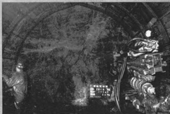
⇨ エアジャンボによる切羽のさく孔 (補助坑)
