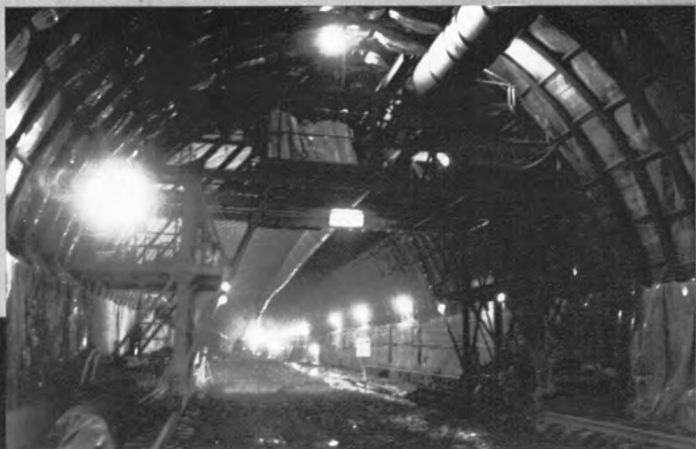
作業架台による防水シート張り (サイロット区間)⇨
