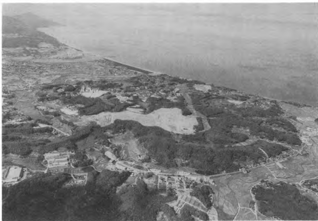
写真-1 上空より見た施工箇所
