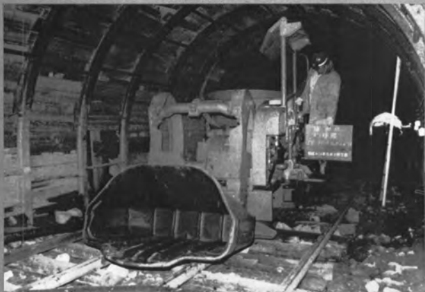
⇨補助坑のずり積み機 (0.7 m 3 )
