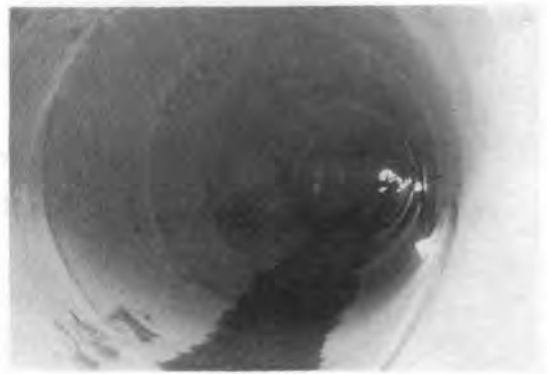
写真-3 推進完成内部状況
