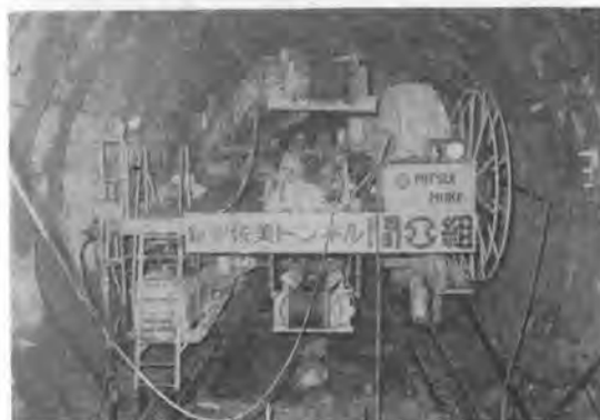
写真-2 掘削架台後部
