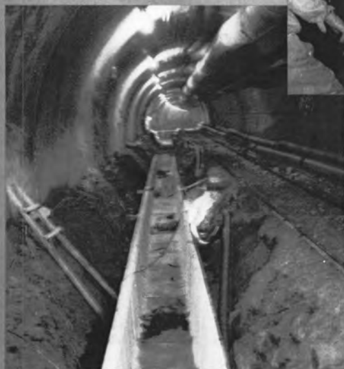
⇨U字溝の敷設 (補助坑)
