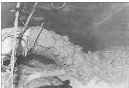
▲アーチ・コンクリート打設中
