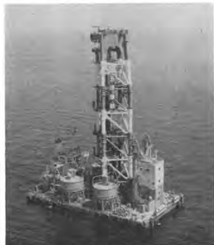
写真-10 川重・深層軟弱地盤改良作業船
