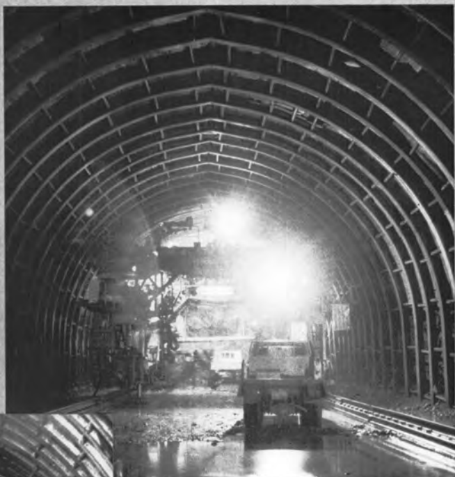
非常駐車帯部と全断面スライドセントラル コンクリート打設の接合点
