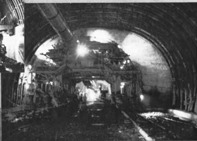
非常駐車帯部と全断面スライドセントラル コンクリート打設の接合点
