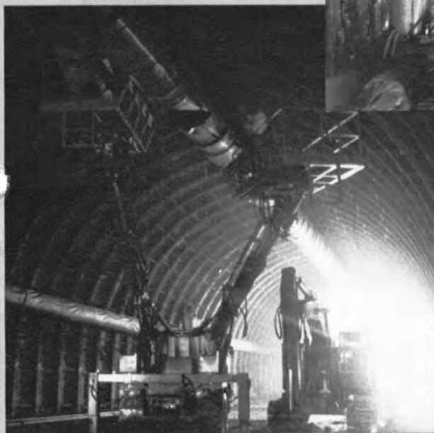
⇨ 2ブームバスケットリフタによる 風管 (1,000 φ×2.4 m) の手直し
