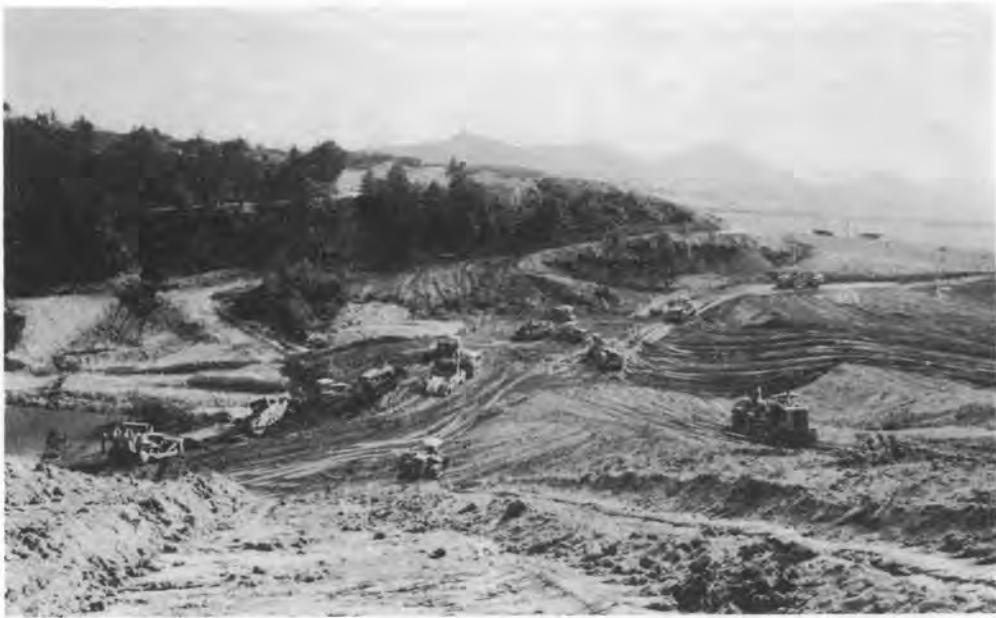
写真-2 基盤造成状況
