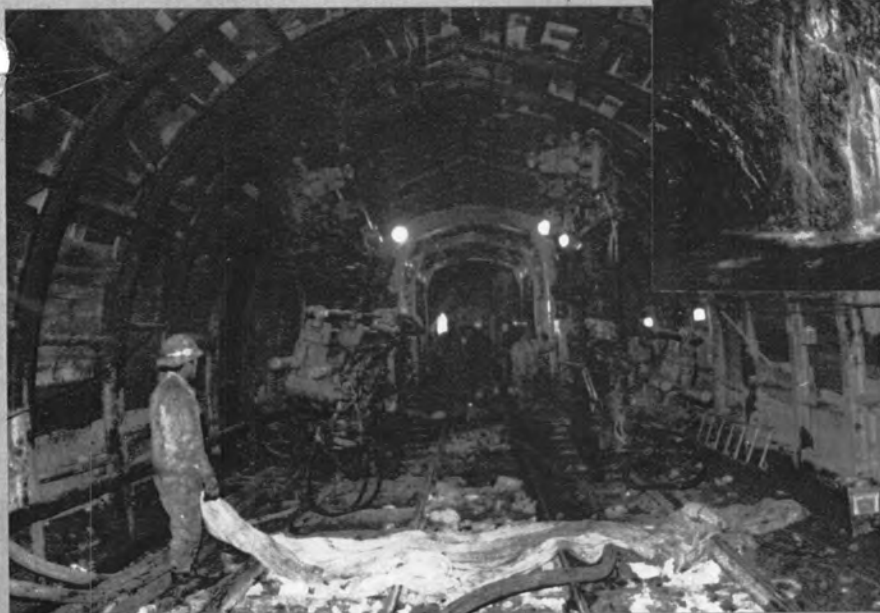
⇨ 補助坑のエアジャンボ (4連 PD 100 型ドリフタ)
