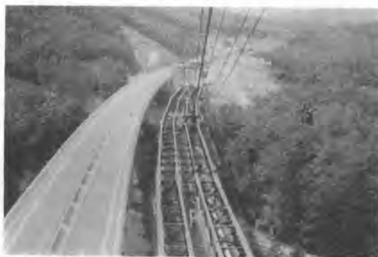
写真-2 上空橋 (左側は供用中の下り線)
