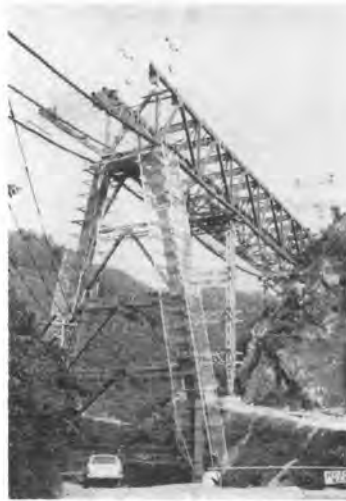
写真-3 上古谷第一橋の架設 (鋼製橋脚高さ h=36 m)
