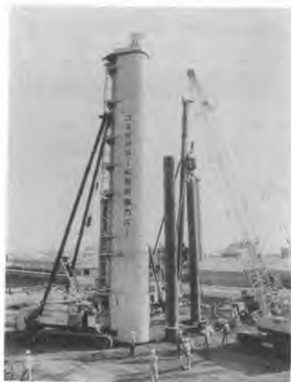
写真-2 JASPP-NC 型超大型カバー (施工可能最大杭径 1,500 mm)
