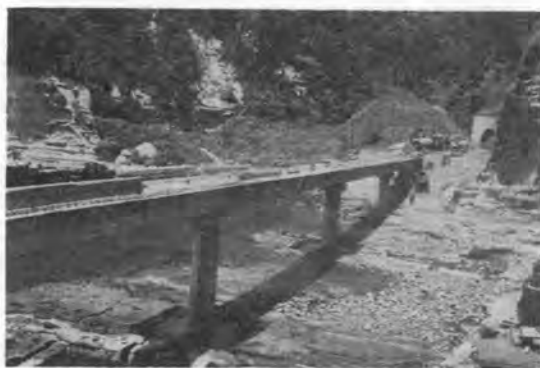
写真-9 陸上部 110 m の渡棧橋 (鉄筋コンクリート製)
