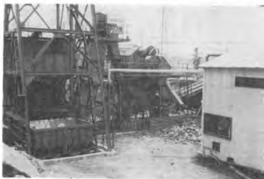
写真-2 温水槽(左)、分級機(中央)、ボイラ室(右)(渡辺組)
