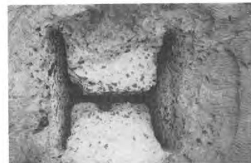
写真-4 H杭(300H)打設跡(対コンクリート)
