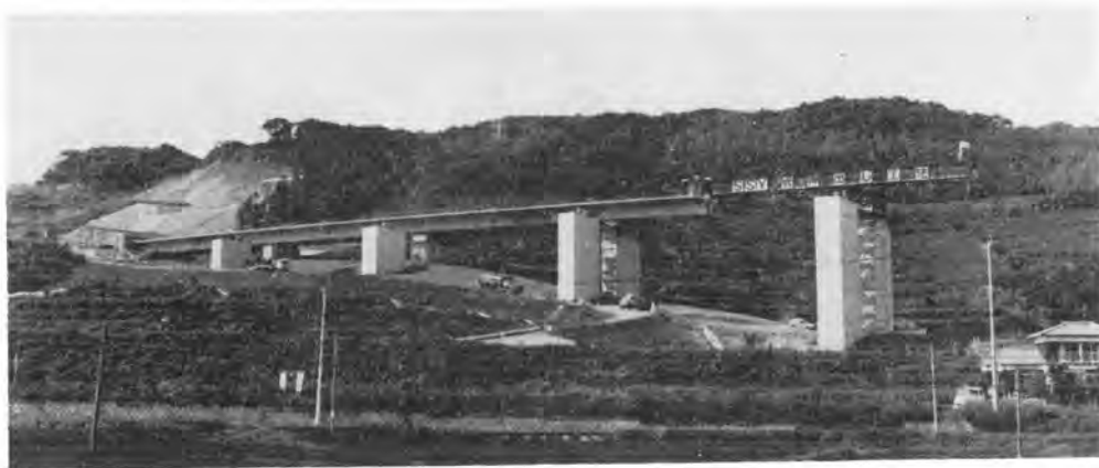
写真-3 工事全景
