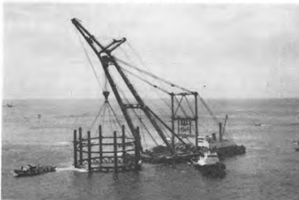
↓ 写真-7 バイルジャケットの現場への曳航(直径 20m)
