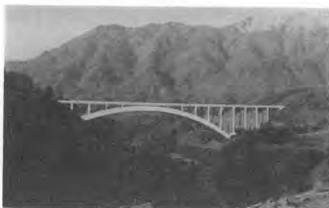
写真-1 宇佐川橋(山口県玖珂郡錦町)
