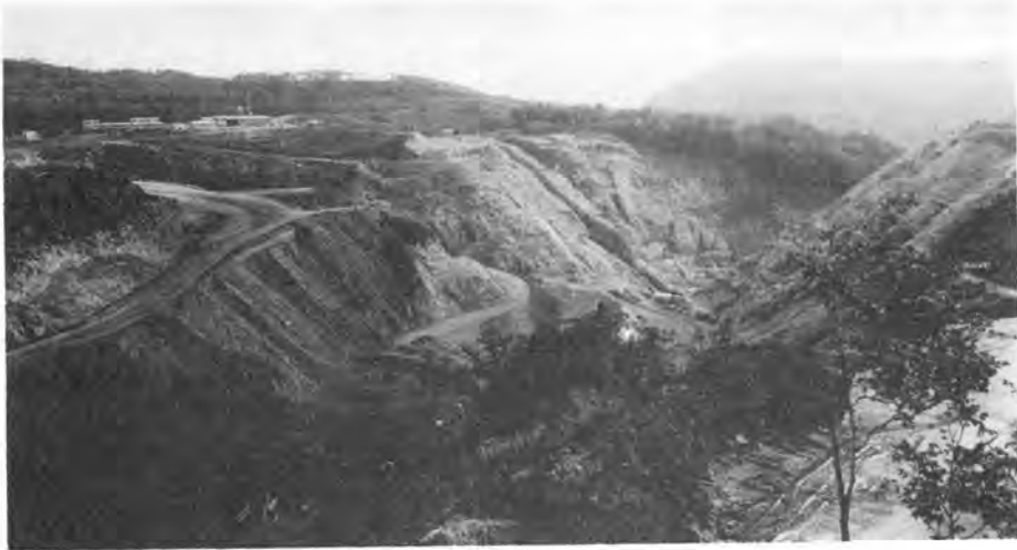
写真-1 盛立開始前の玉原ダムサイト
