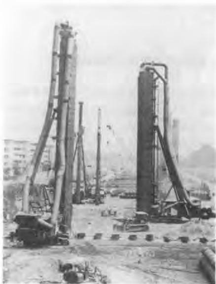
写真-1 油煙対策装置を施した JASPP-NB 型カバー (東関東自動車道小中台高架橋工事)
