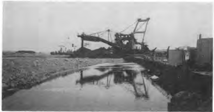
写真-3 揚土中のリクレーマ船
