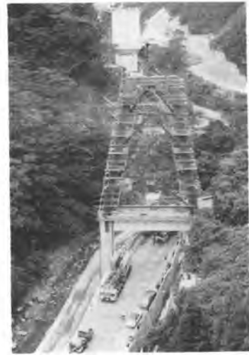
写真-4 下山王橋の架設 (鋼製橋脚)
