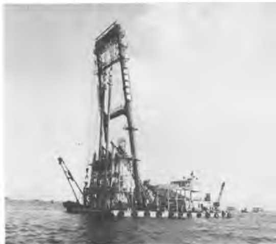
写真-2 施工中のバックドレーン船
